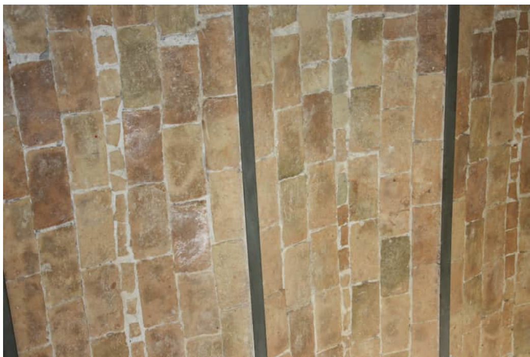
Foto 6 – particolare solaio (voltini e laterizi)
