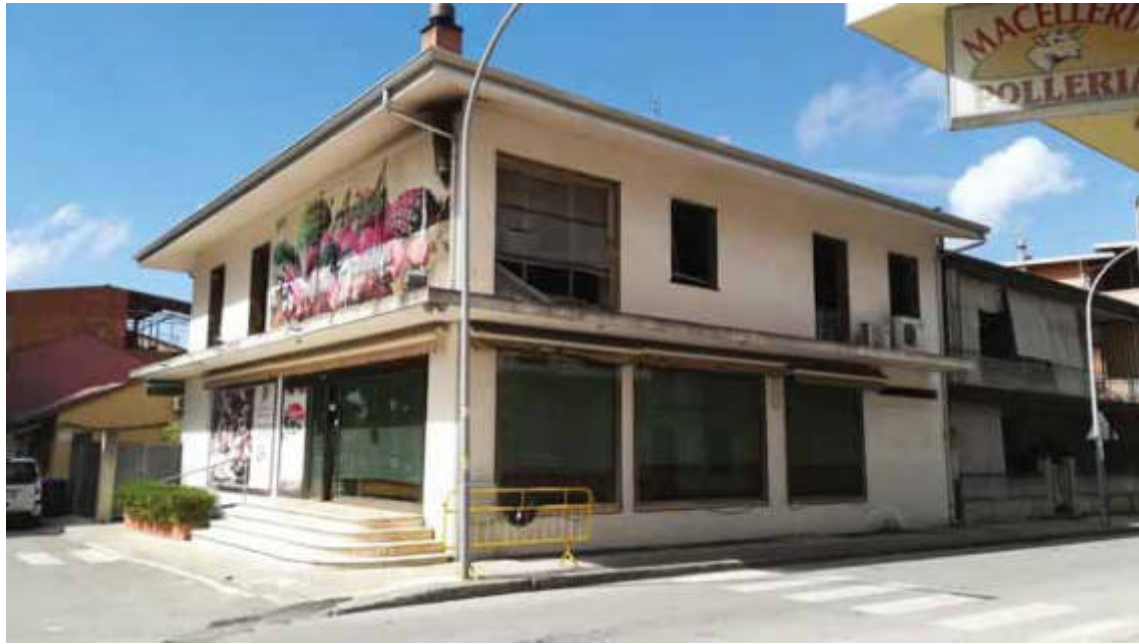
Foto 3 - Prospetto Piazza Aldo Moro angolo Via VIII Settembre
