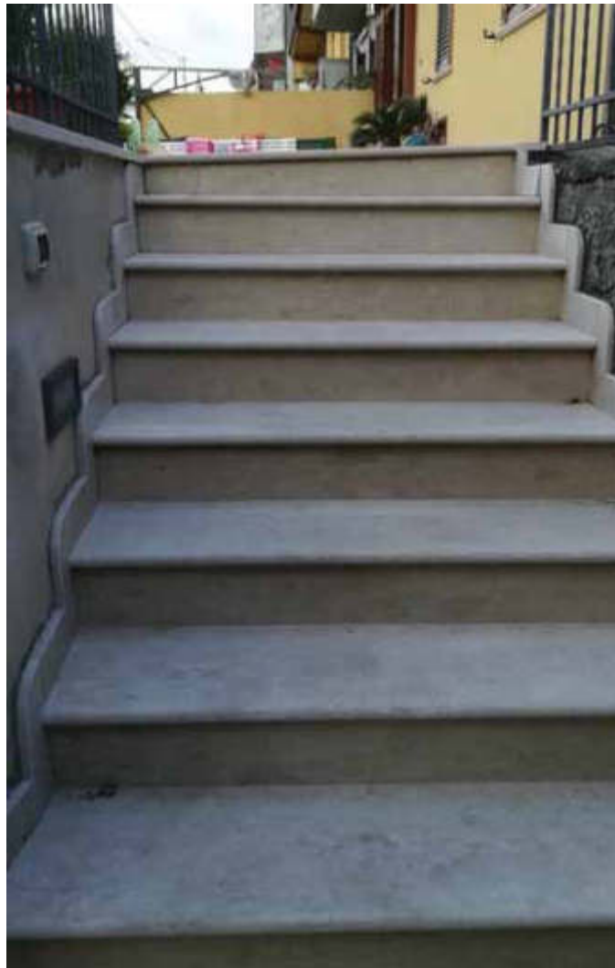
Foto 6 - Accesso pedonale da Via De Gasperi
