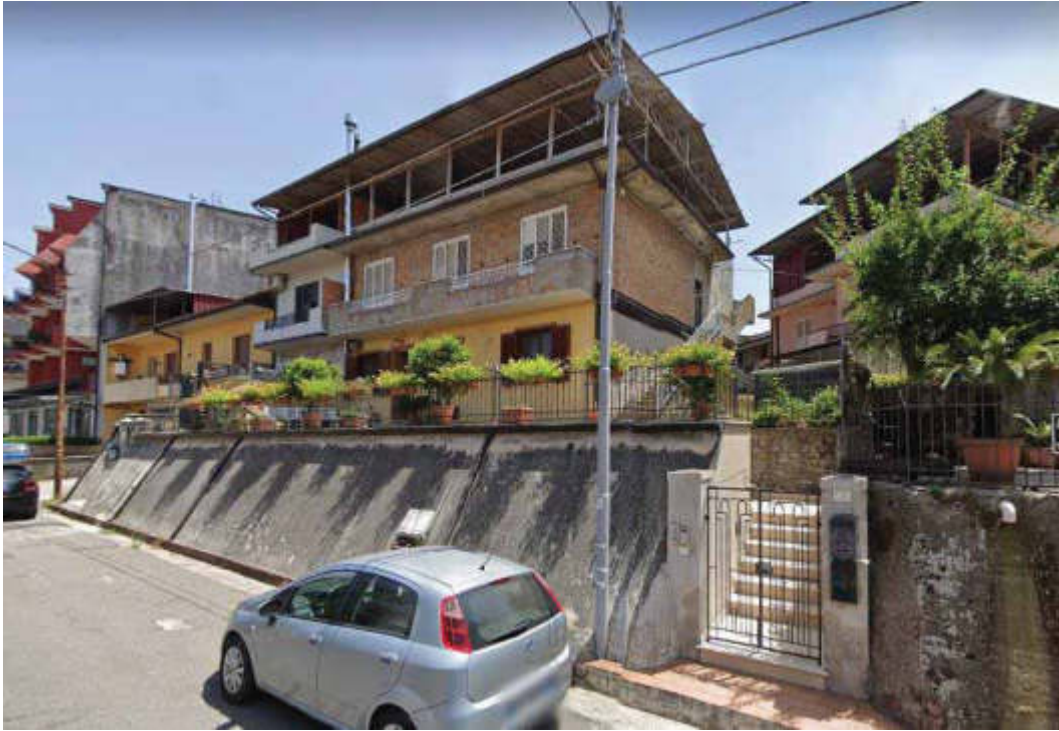
Foto 5 - Accesso pedonale da Via De Gasperi
