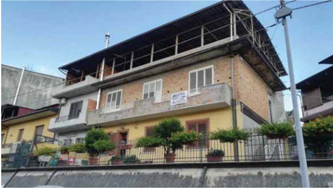
Foto 1 – Prospetto su Via De Gasperi
