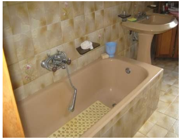
Foto n. 51, 52 "Bagno sub 5 piano 1°"
