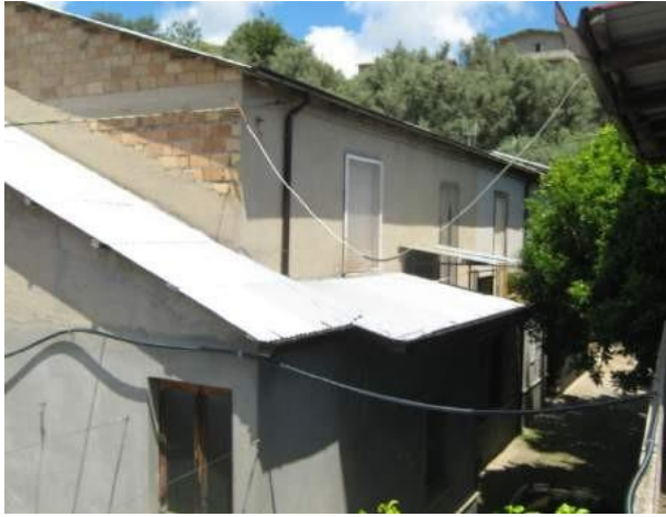
Foto n. 38 "Particella 717 sub 5- Prospetto abitazione"
