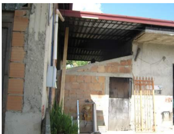
locale dentro cui è posto il forno
