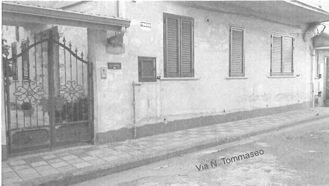
Prospetto su Via N. Tommaseo
