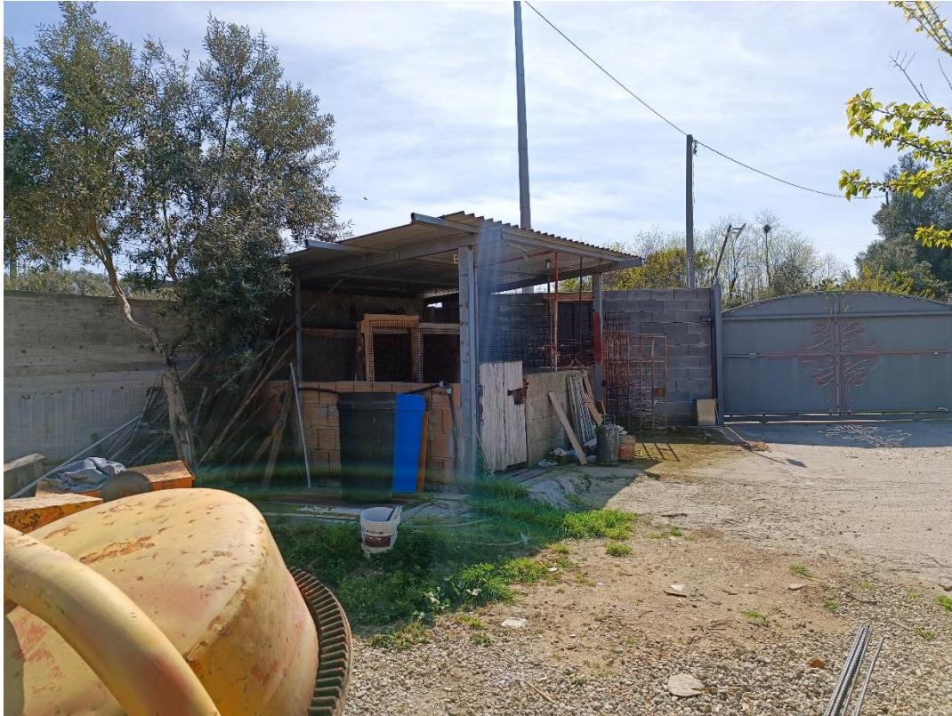
Foto 3: Catasto Terreni di San Ferdinando, foglio 17, particella 923, Contrada Focoli. In prossimità dell'accesso pedonale è stata realizzata una tettoia di circa 20,00 mq.
