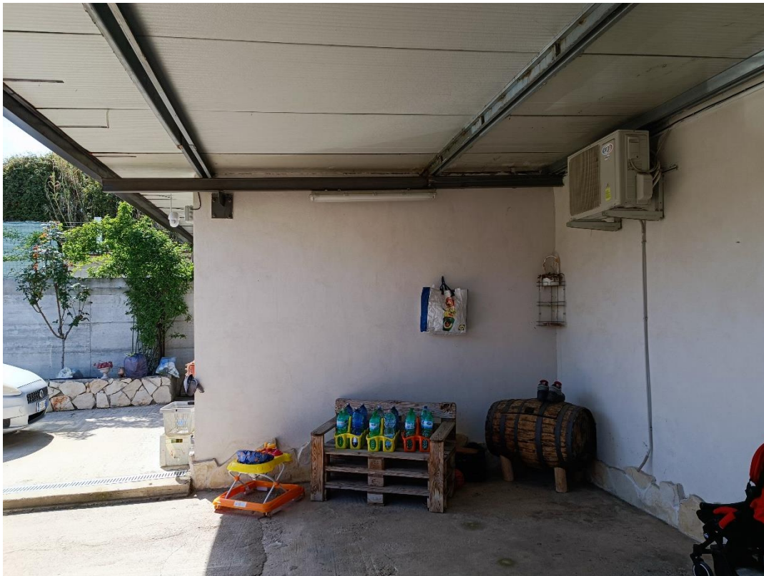
Foto 6: la facciata del lato sud dell'abitazione, identificata con la particella 924, è stata intonacata e rifinita con grassello di calce.
