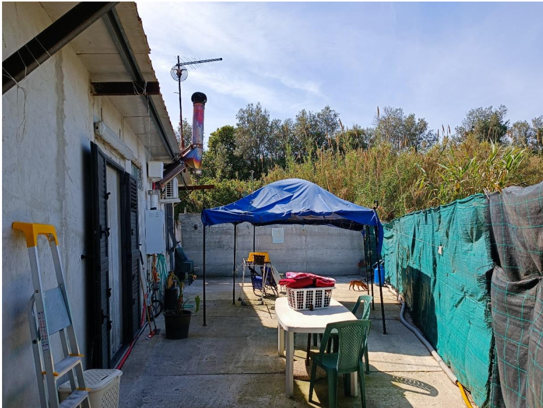
Foto 7: la facciata del lato nord dell'abitazione è stata intonacata al rustico.
