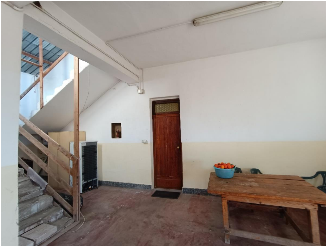
Foto 7: Catasto Terreni di San Ferdinando, foglio 17, particella 654, Contrada Focoli. Atrio di collegamento tra i sub 2 e sub 3 e vano scala che conduce al sub 4.
