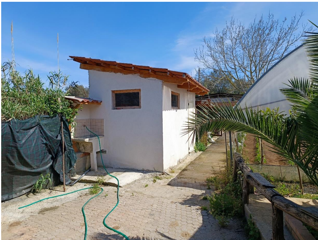
Foto 4: deposito di circa 10,00 mq, realizzato lungo il confine est della particella 923.
