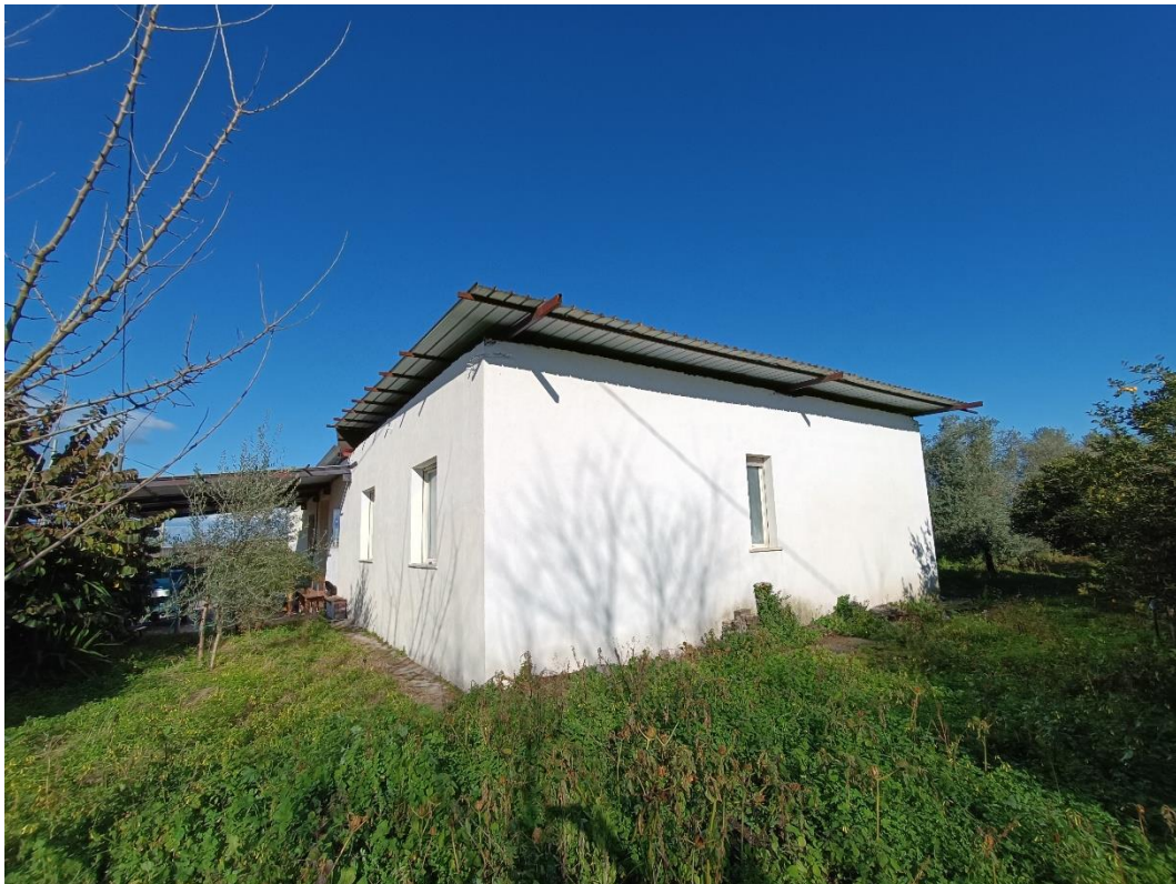
Foto 4: Catasto Terreni di San Ferdinando, foglio 17, particella 654 sub 2, Contrada Focoli. Abitazione.
