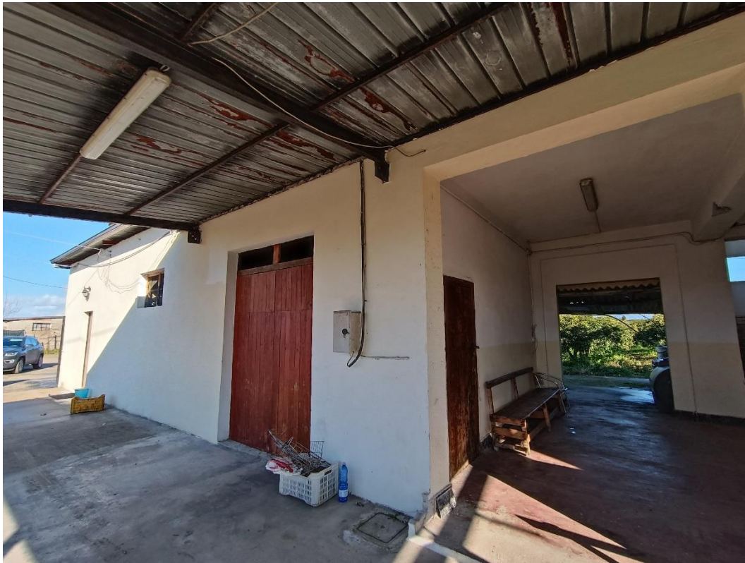
Foto 5: Catasto Terreni di San Ferdinando, foglio 17, particella 654 sub 3, Contrada Focoli. Deposito.
