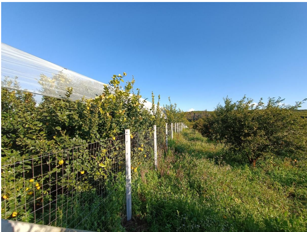
Foto 6: la porzione coltivata a limone è separata dal resto della proprietà con una recinzione realizzata con paletti di cemento e rete metallica.
