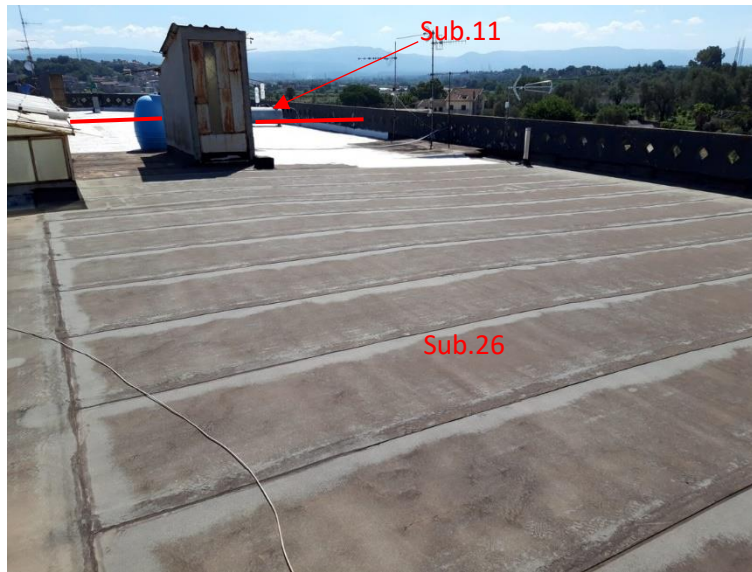
LOTTO 001a – Lastrico solare comprendente il sub.26
