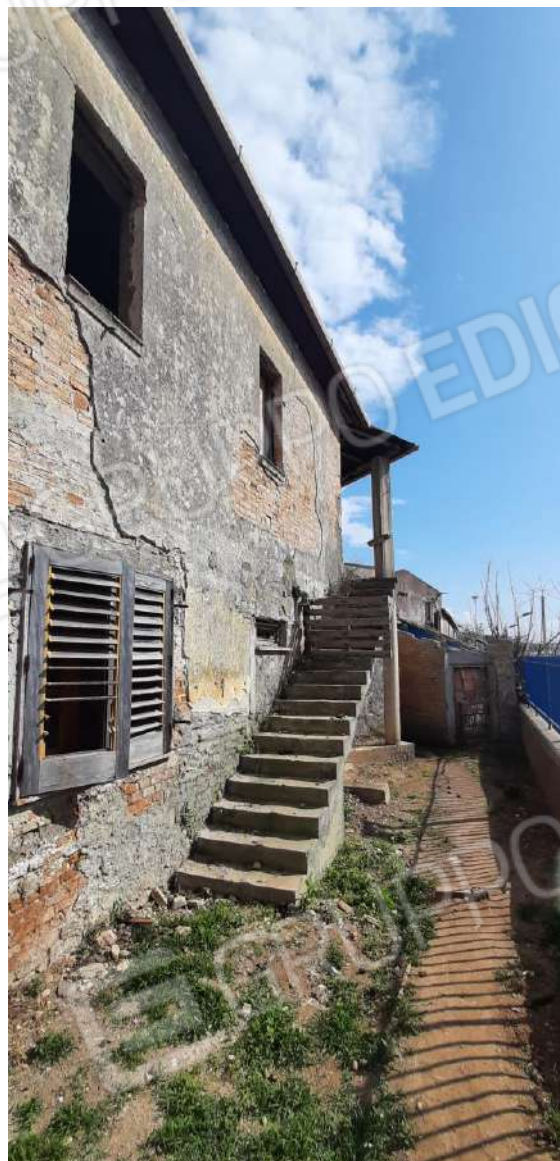
Foto 11: scala d'accesso al piano primo
