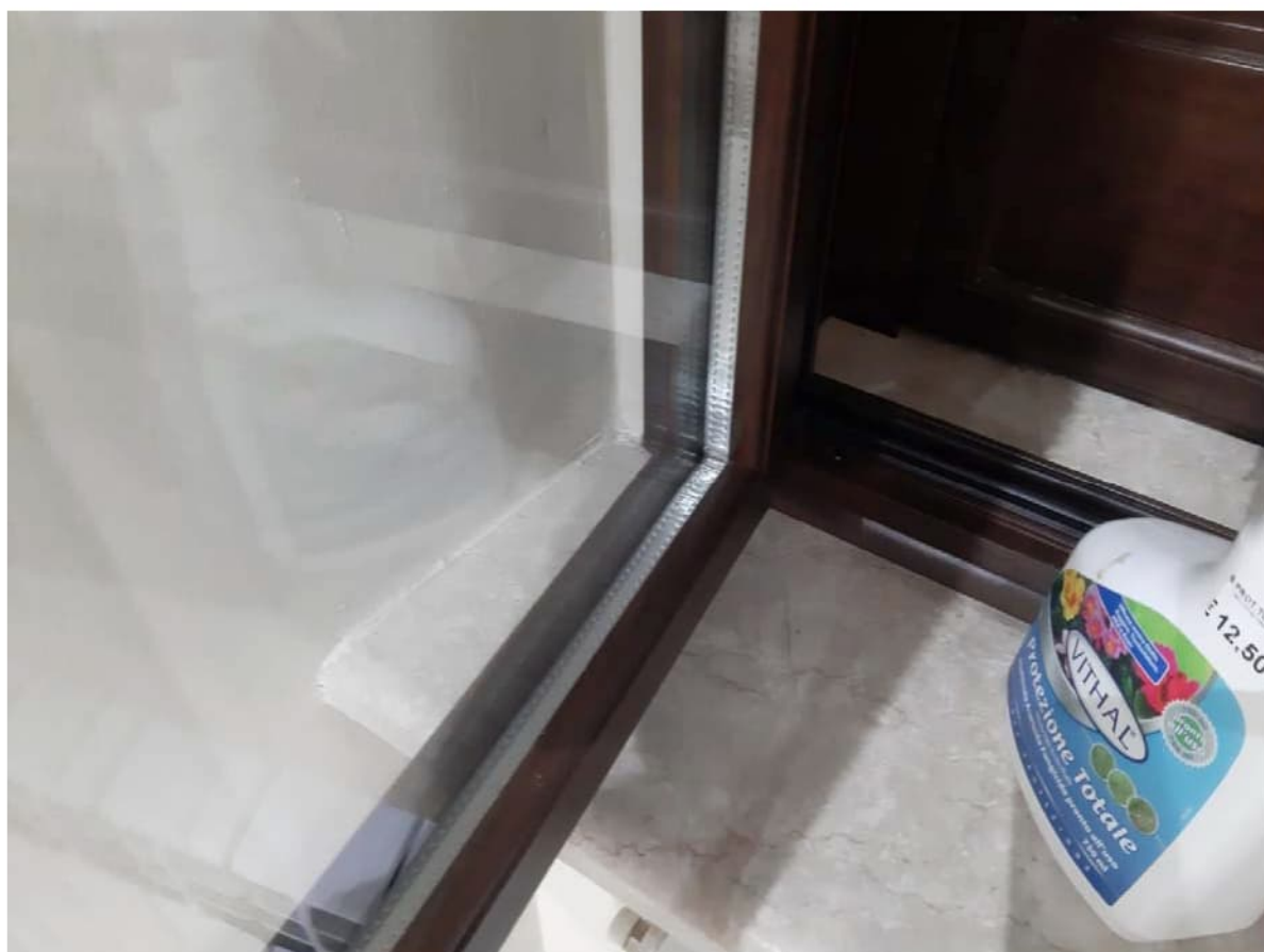
Foto n° 6 – Particolare degli infissi esterni con vetrocamera
