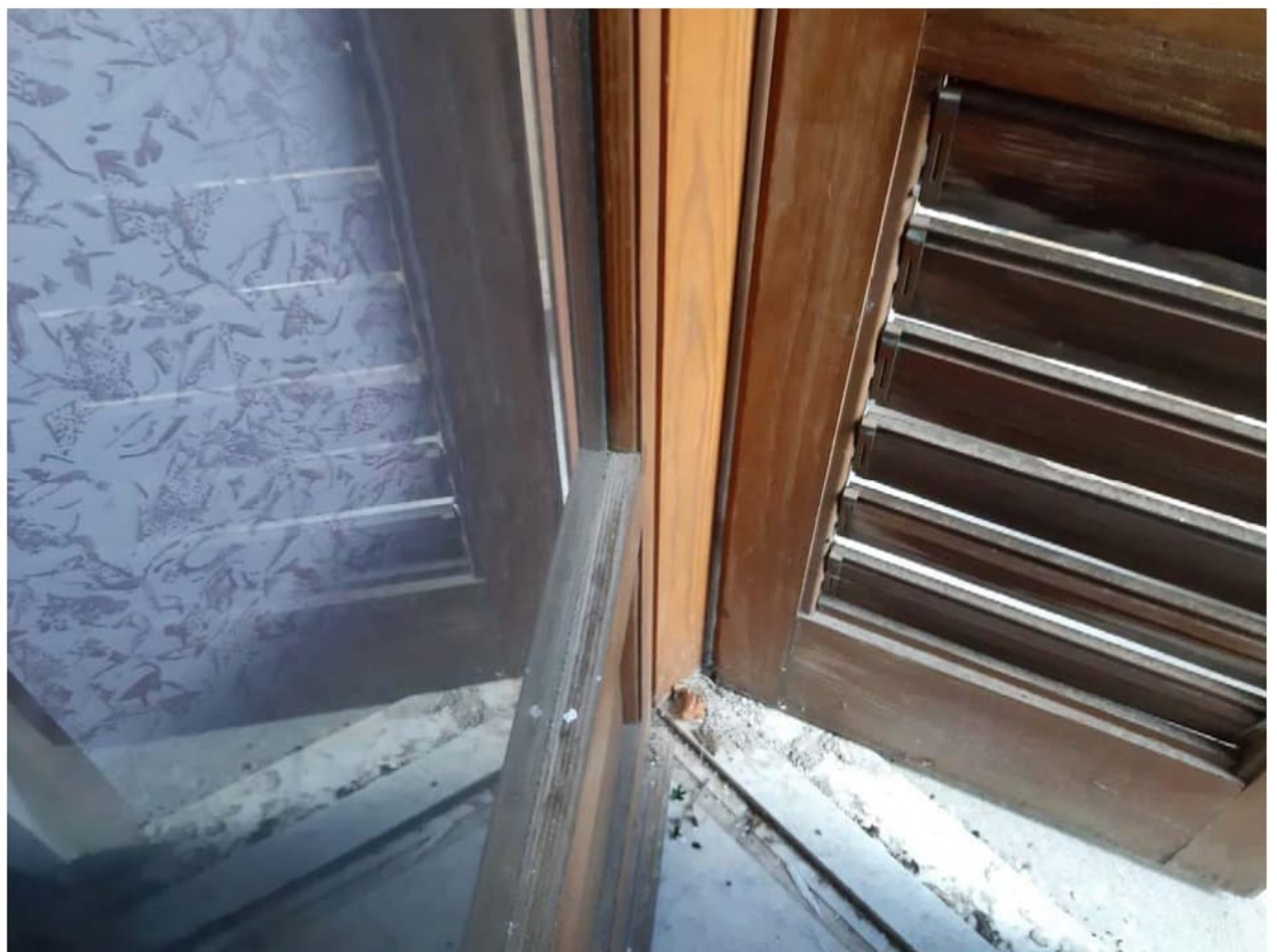
Foto n° 12- Particolare degli infissi al primo piano
