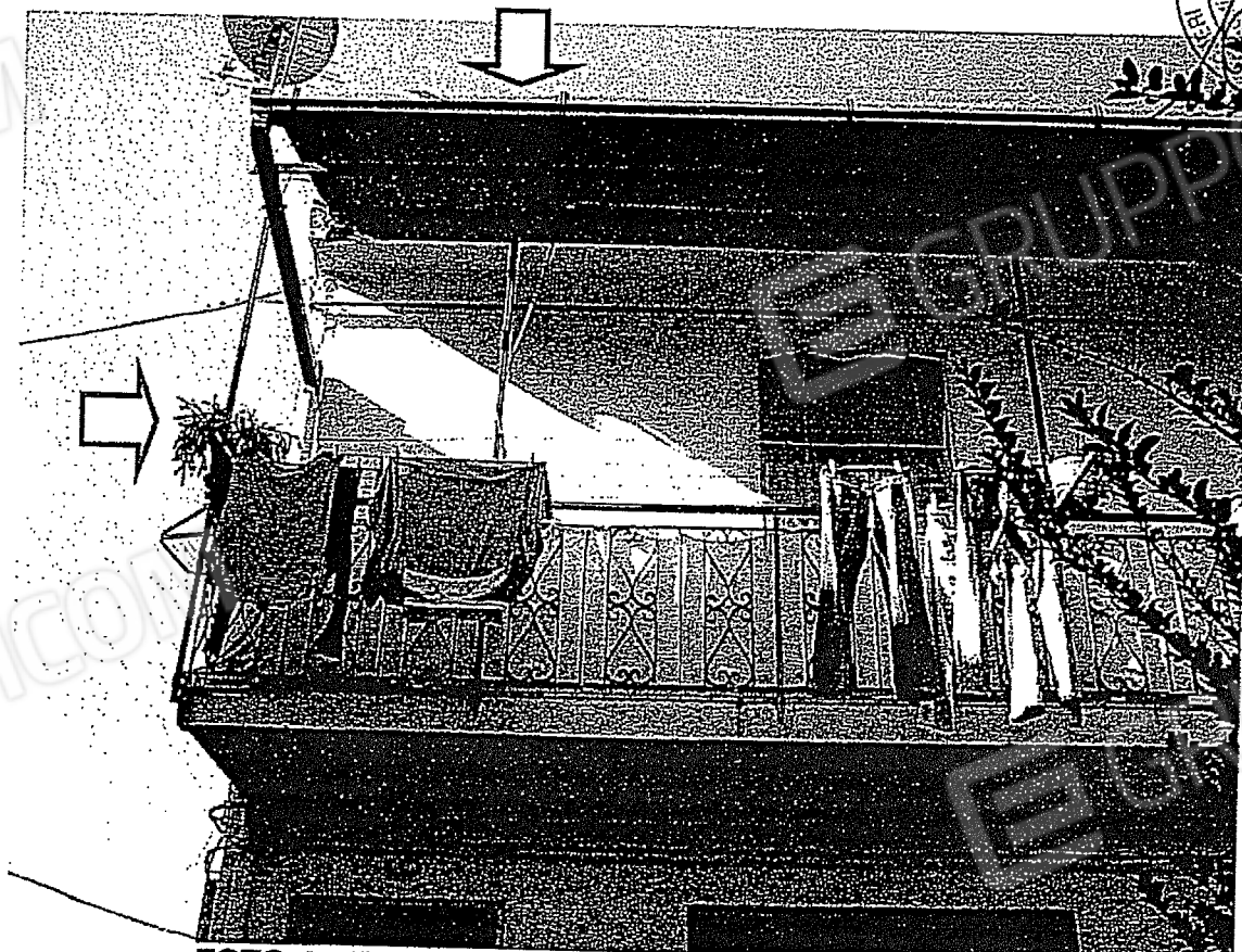
FOTO 4 – Foglio n. 39 particella 86 sub 3 - Vista dalla particella 155 Vista balcone protetto da pensilina
