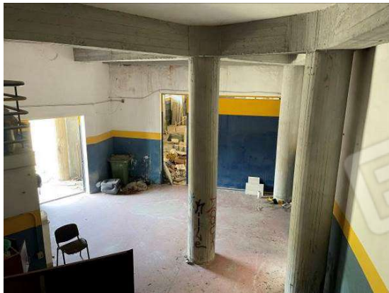
Foto 21 – androne di accesso
