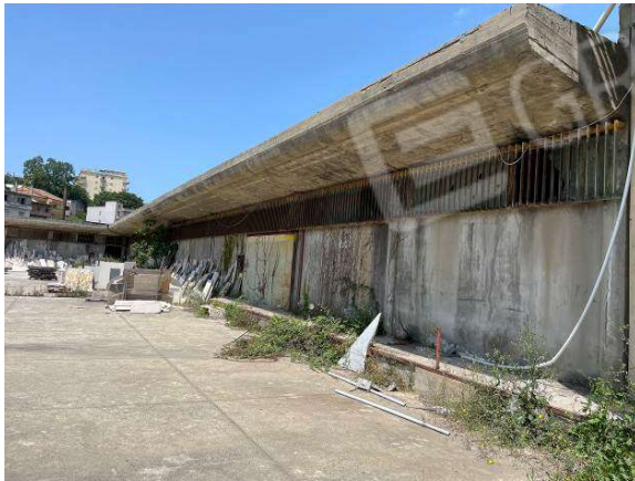
FOTO 1 – prospetto del piano terra
