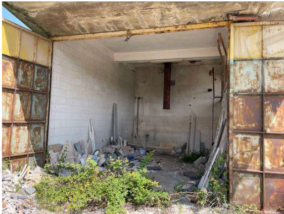
FOTO 3 – locale ex centrale termica
