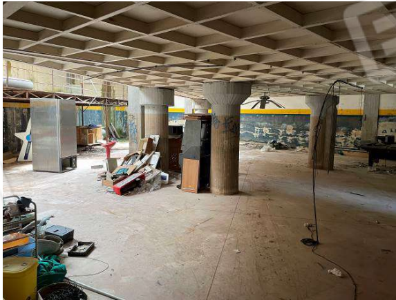
FOTO 15 – locale magazzino soppalco
