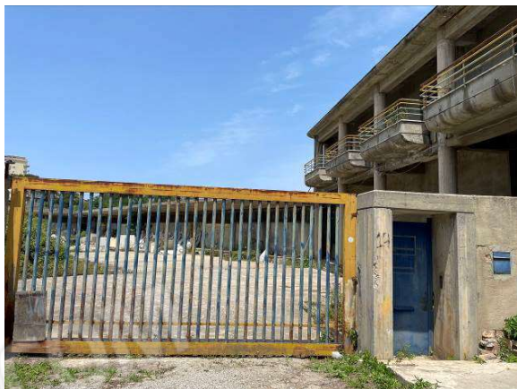
Foto 54 – cancelli di accesso
