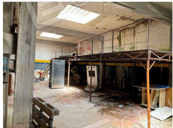
Foto 18 – piccolo soppalco in acciaio
