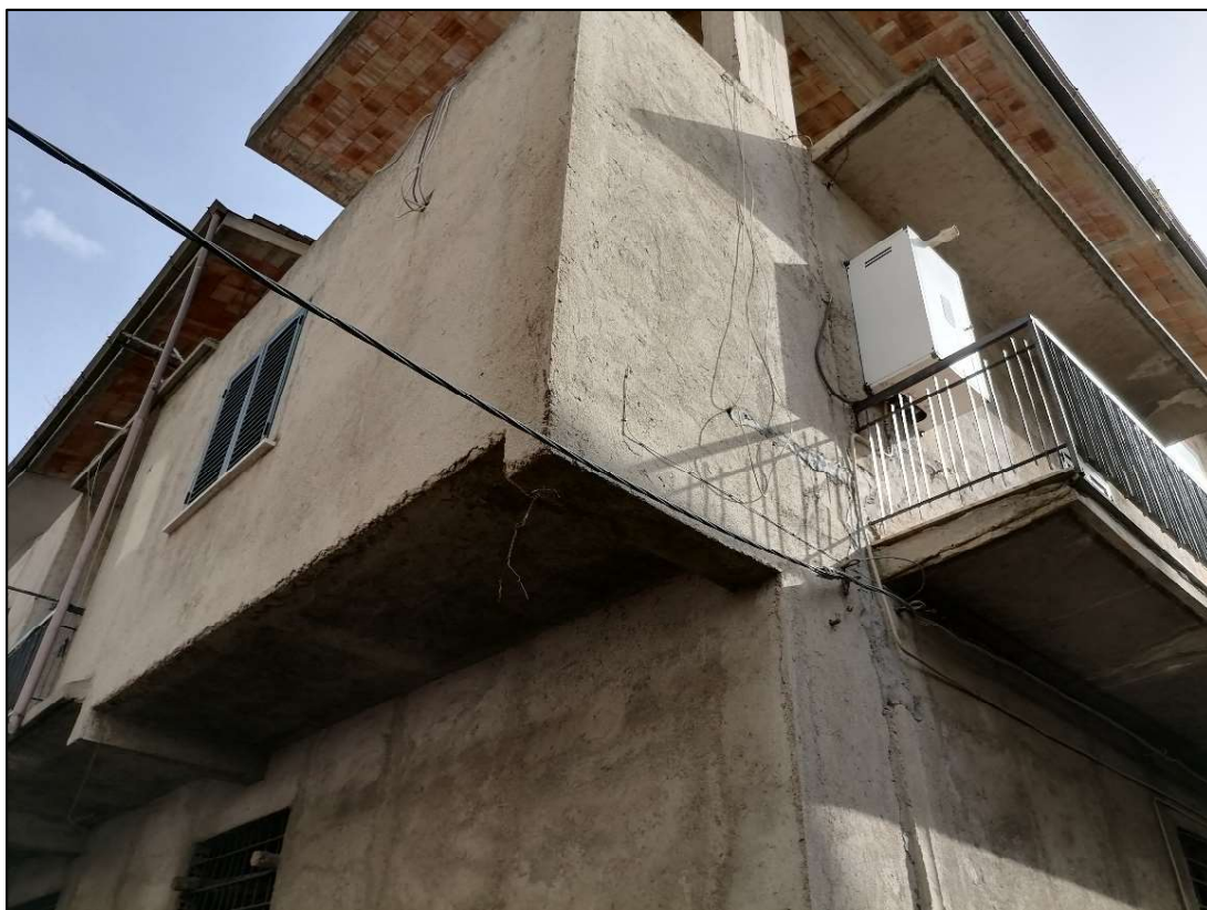
Foto 3: Immagine esterna appartamento
