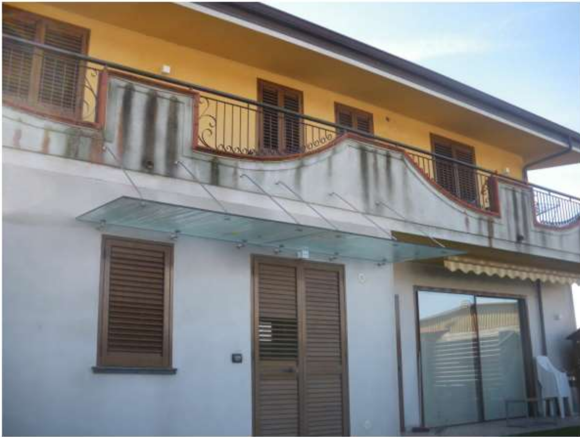
Foto n. 01: Prospetto principale del fabbricato
