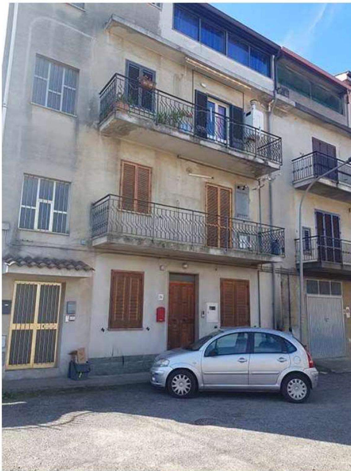
Foto 1: Cittanova foglio 45 particella 845 sub. 2 - Facciata principale
