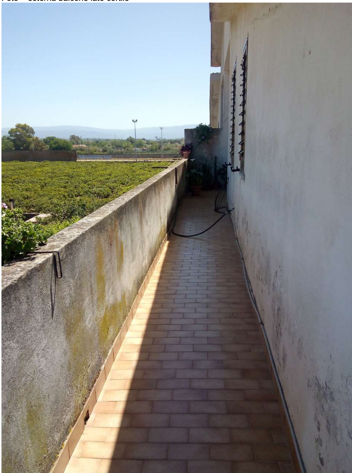
Foto – esterna balcone lato cortile
