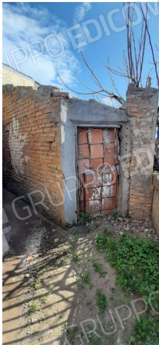
Foto 20: piccola costruzione in muratura posta nel retro dell'abitazione
