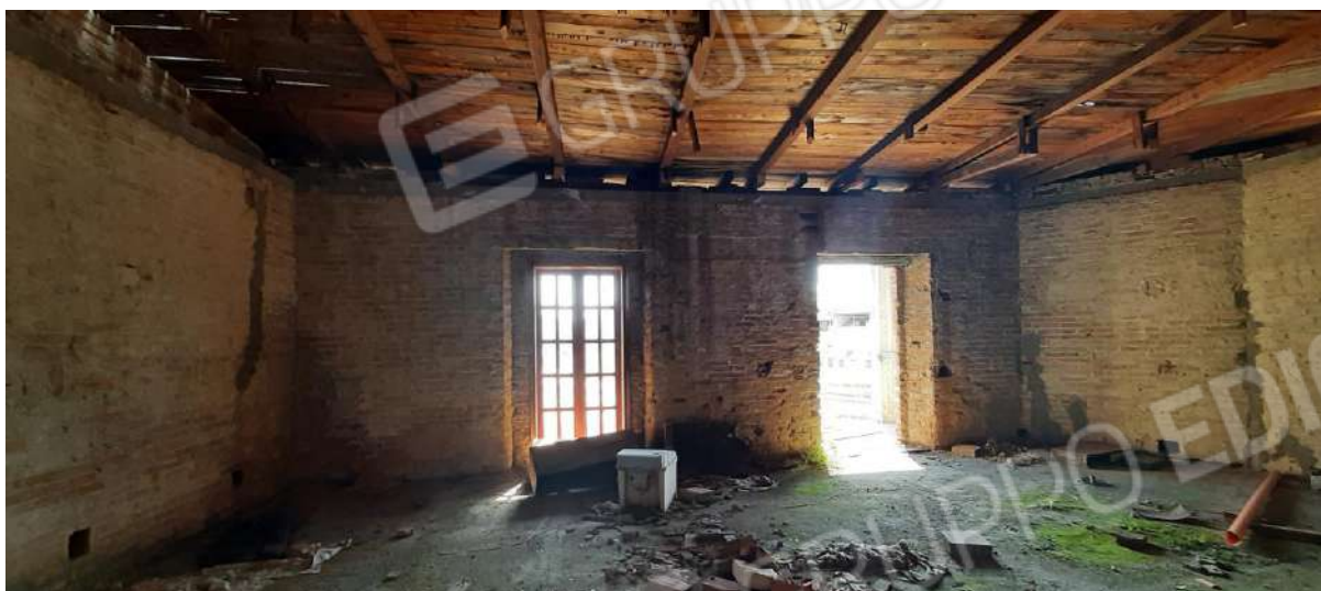
Foto 16-17-18: interno abitazione al piano primo
