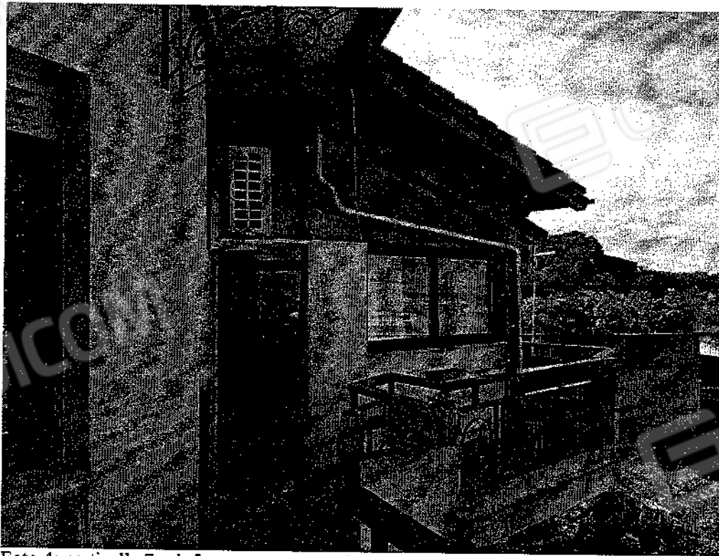
Foto 4: particella 7 sub 5 – appartamento al primo piano. Esterno lato nord.
