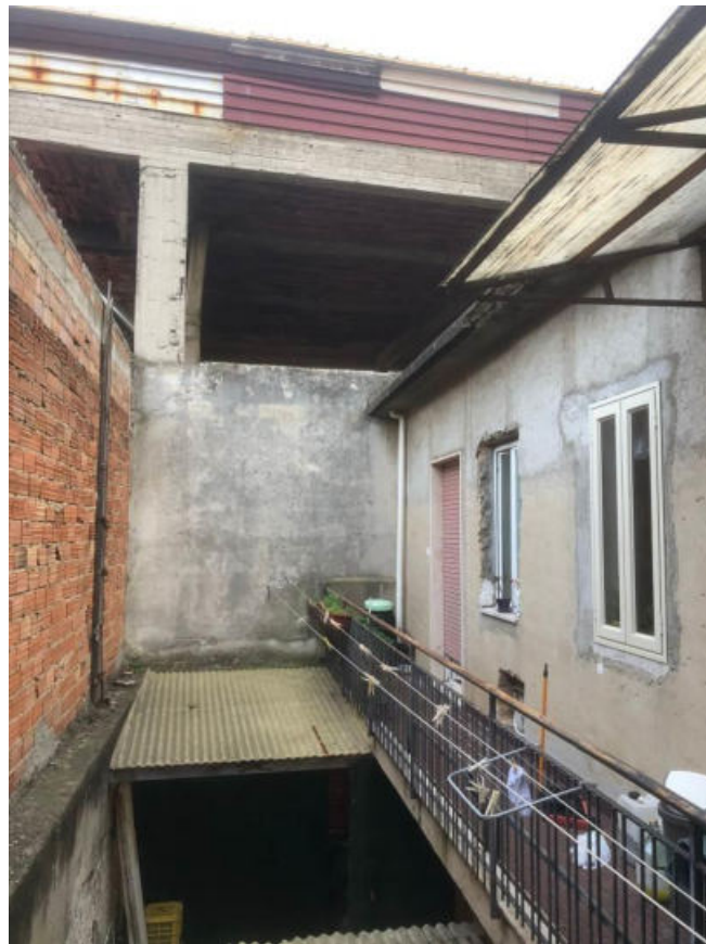
Piano primo - prospetto retro – balcone
