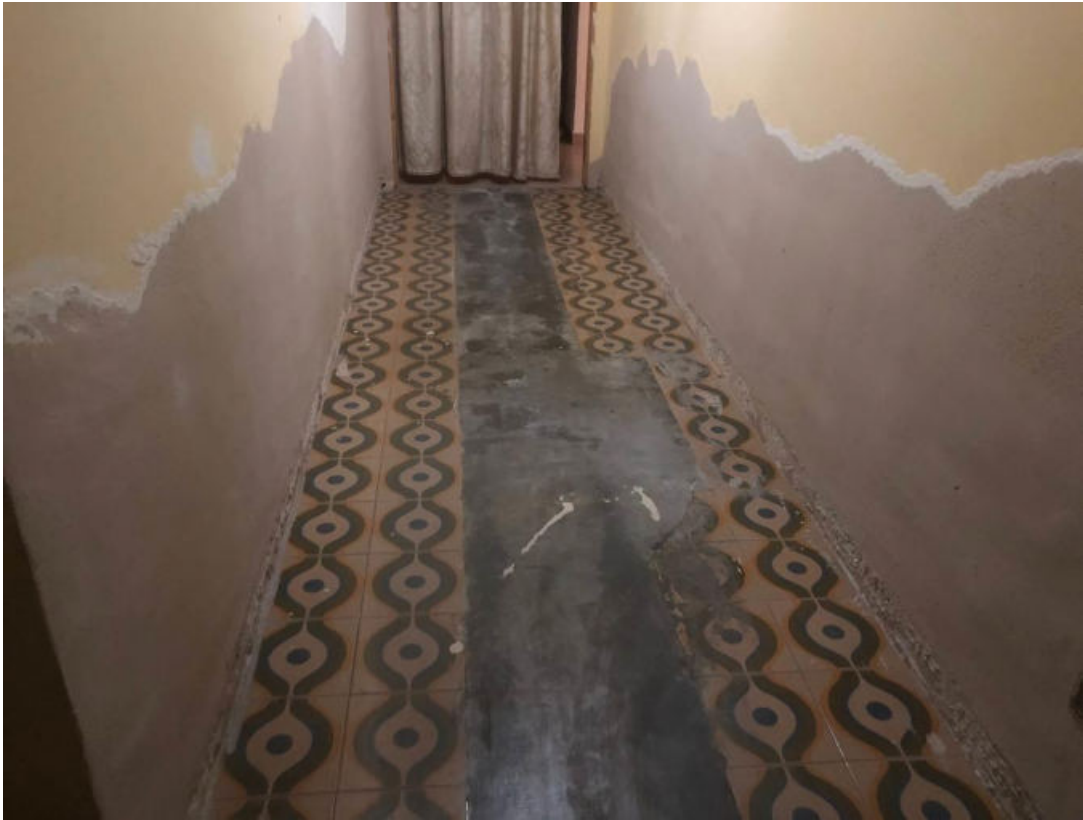
Piano Terra - ingresso corridoio
