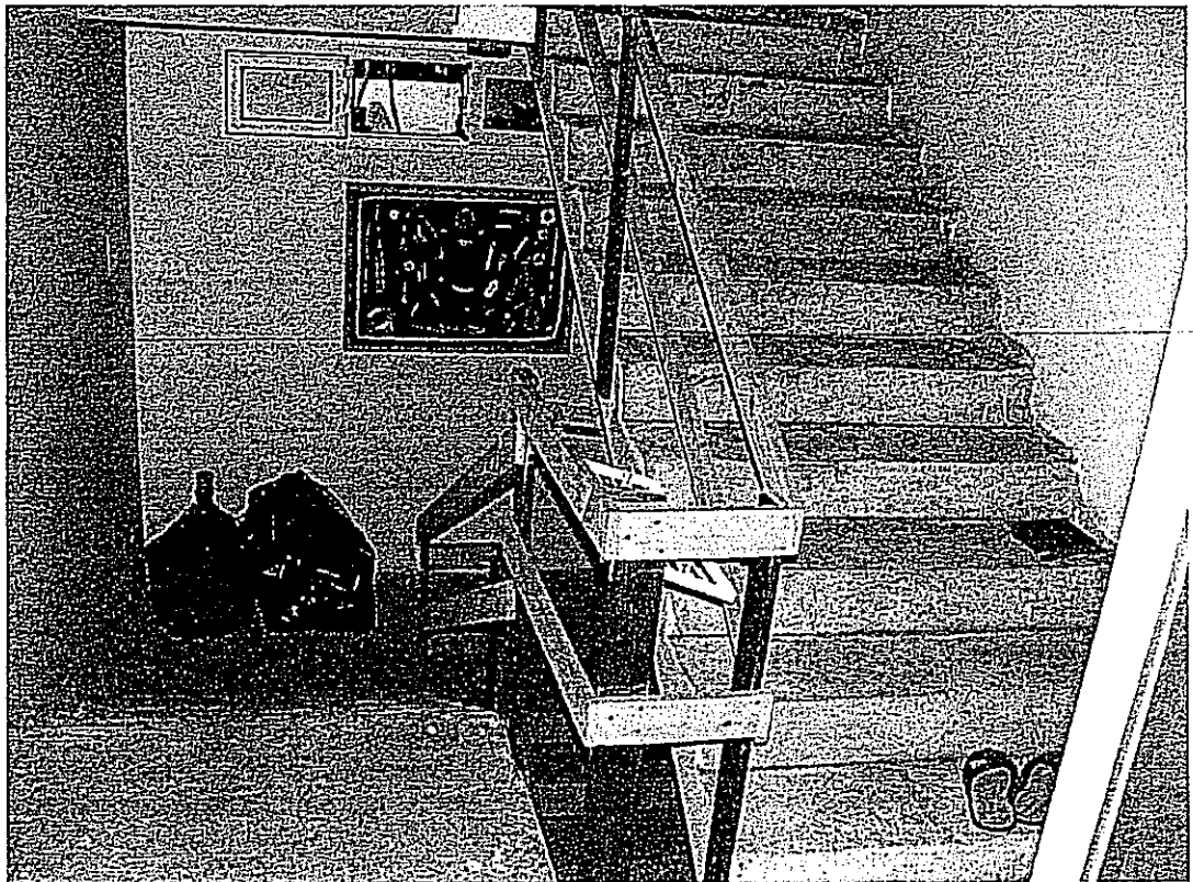
Foto n° 4: Le scale, ancora prive di rivestimento e di ringhiera.
