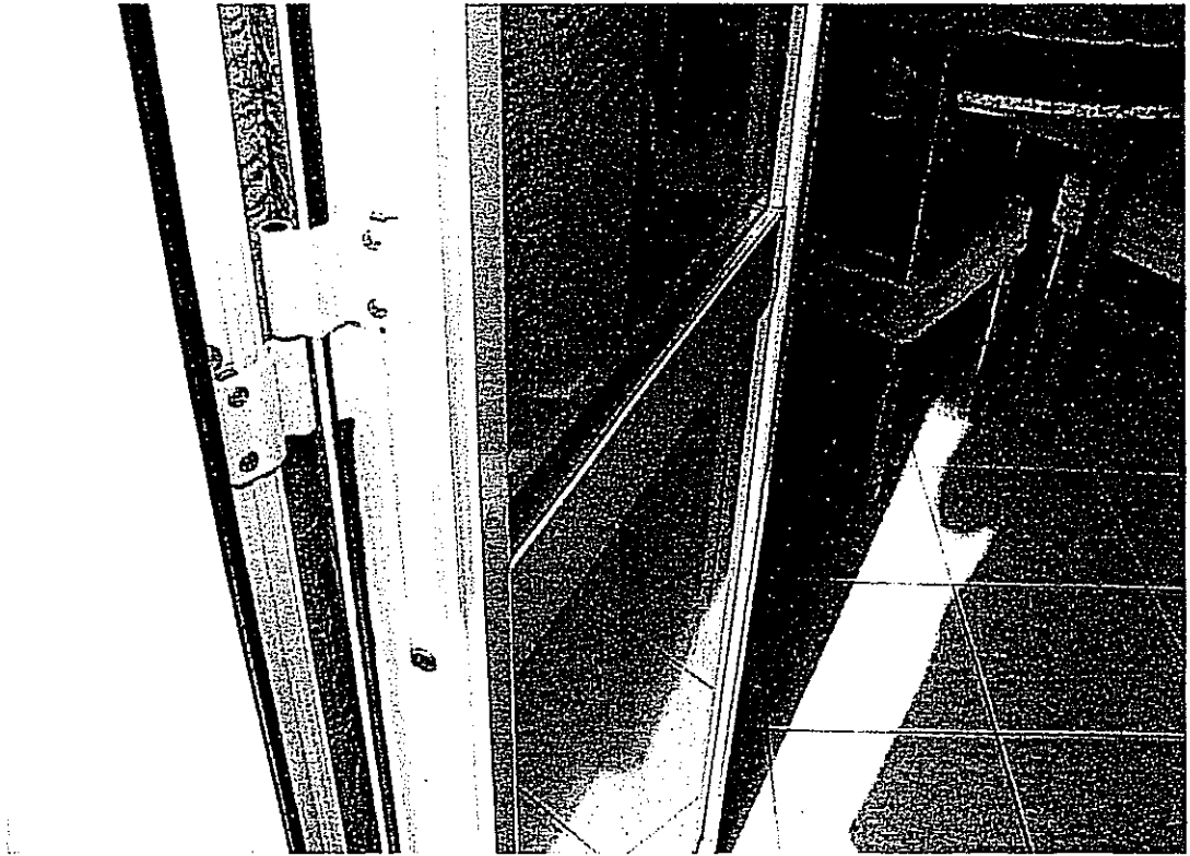
Foto n° 7: Particolare degli infissi esterni e del pavimento.
