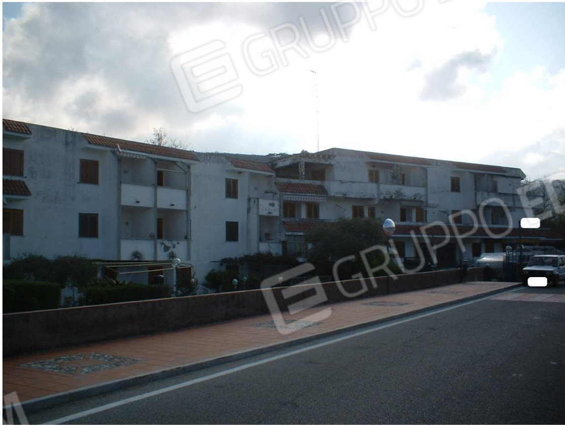
Foto 1- Facciata Ovest del fabbricato
