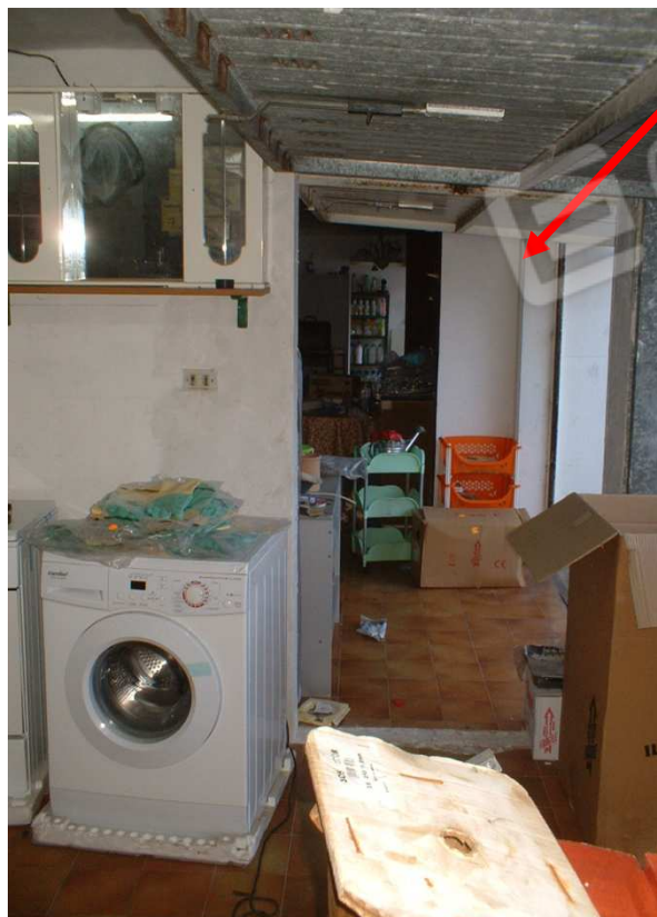
Foto 4- Varco di comunicazione con locale adiacente sulla parete sud/sud-est
