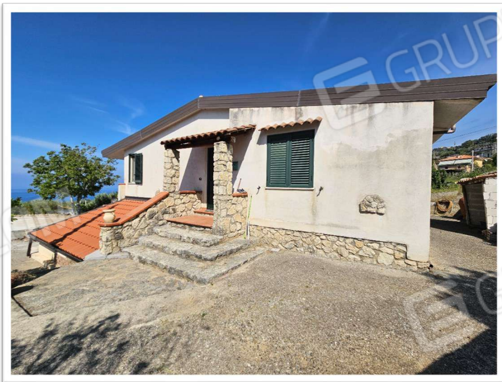
Foto 2 - Vista prospetto Sud
