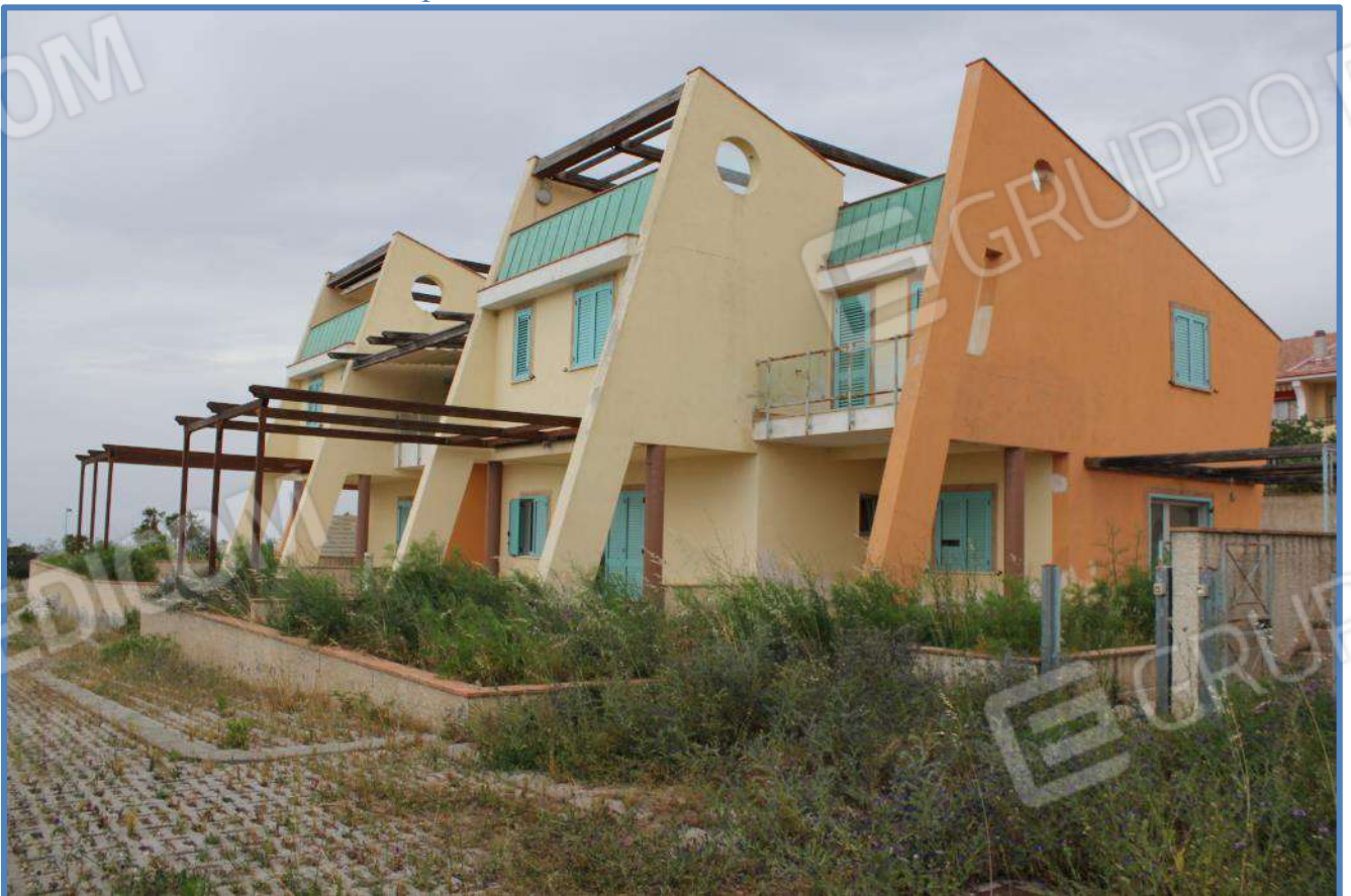
0.10- Fabbricato individuato con particella n. 733
