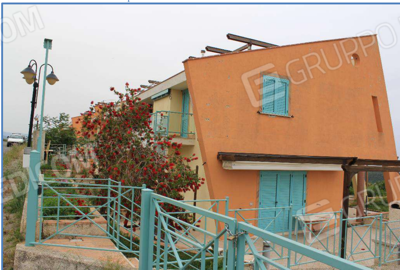
0.12- Fabbricato individuato con particella n. 733
