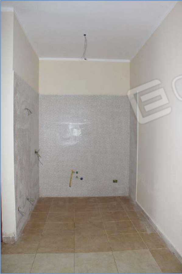
7.5, 7.6- Zona giorno – Angolo cottura e locale WC
