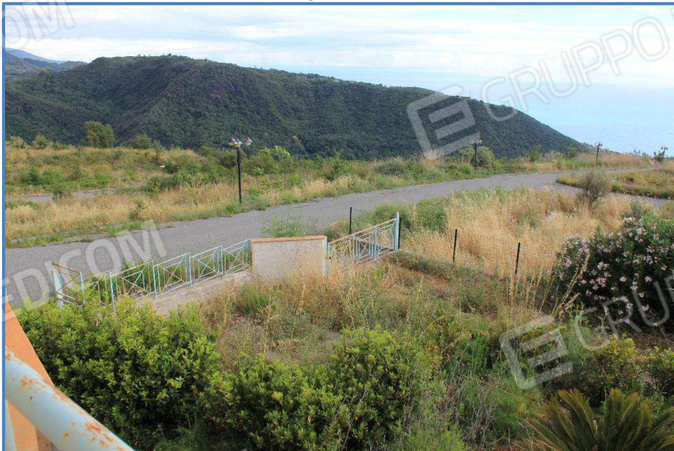
0.16- Strada di lottizzazione – lato S/E – Vista panoramica
