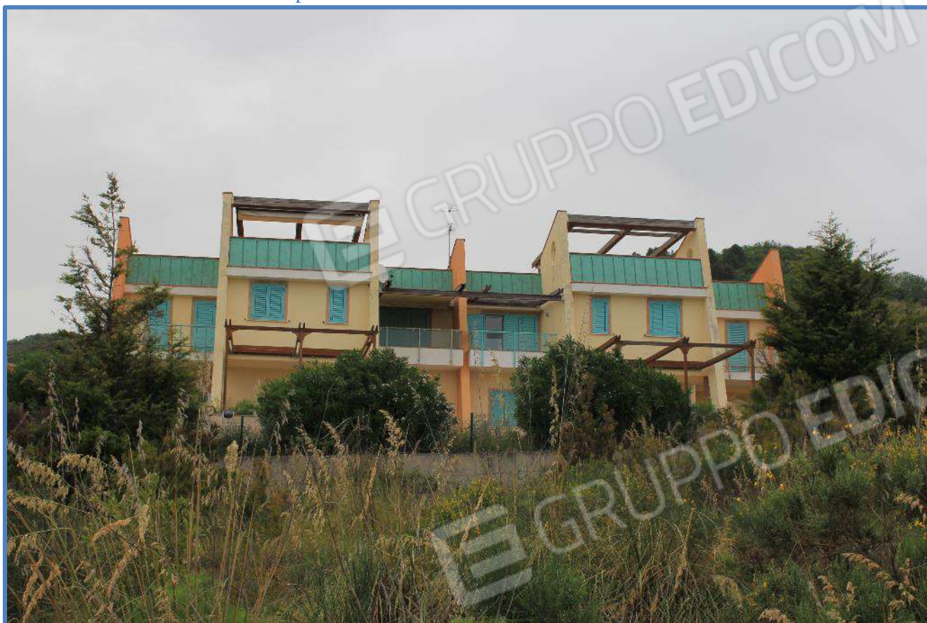
0.11- Fabbricato individuato con particella n. 733
