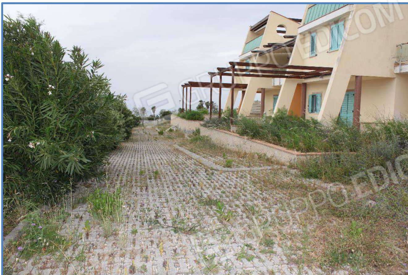
0.15- Corte di accesso ai fabbricati – lato S/O
