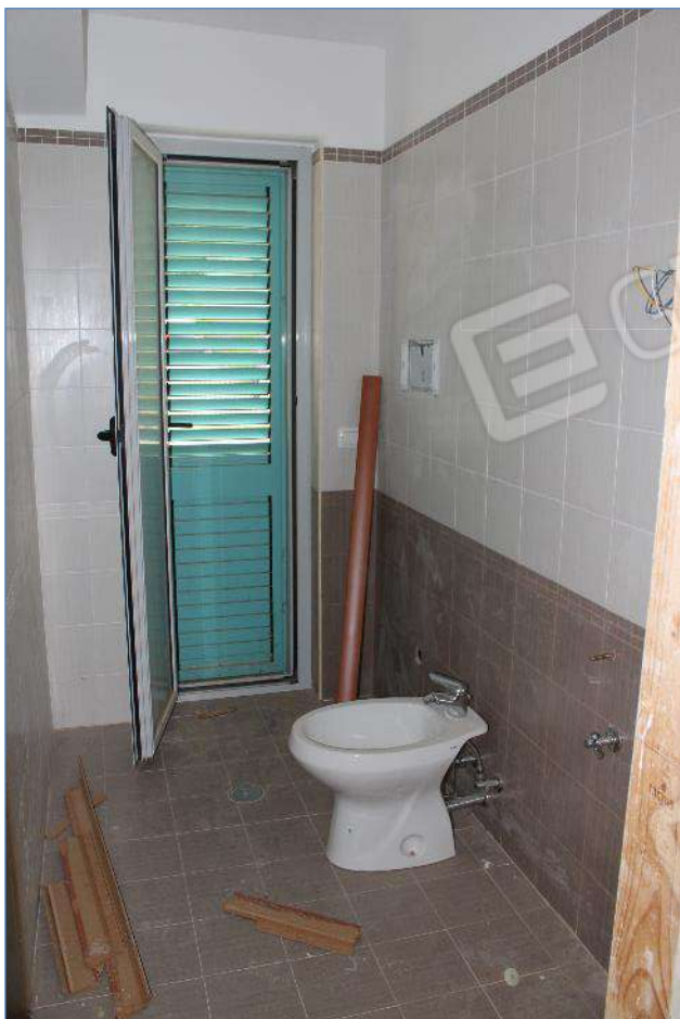
4.23, 4.24- Zona notte – Locale WC
