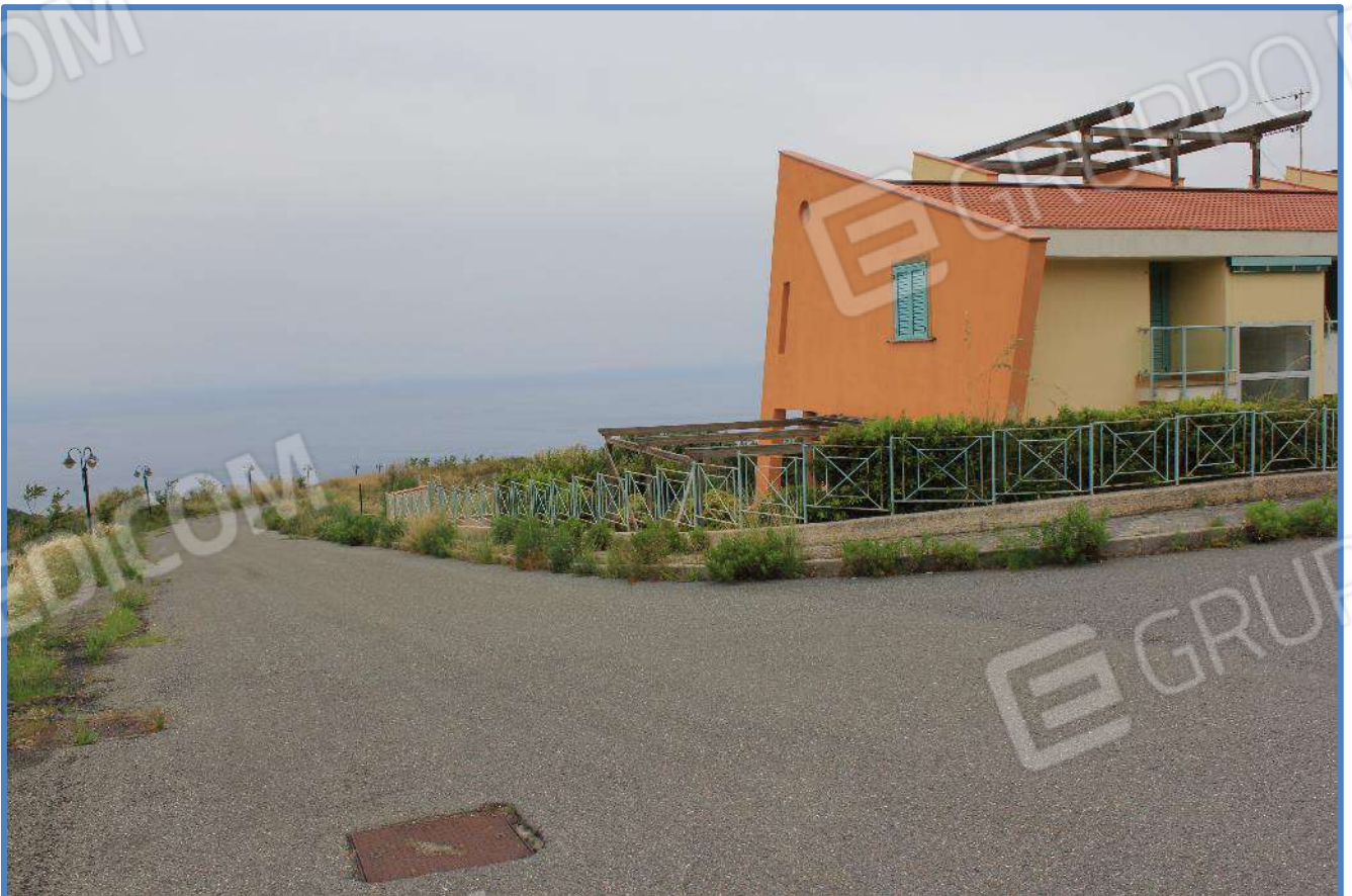
0.14- Strada di lottizzazione – lato S/E
