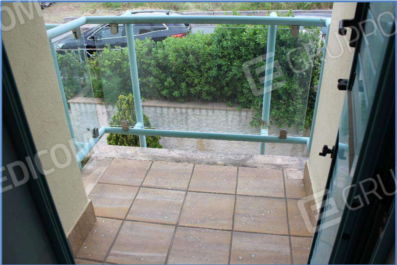
5.17- Zona notte – Balcone prospiciente il Locale WC
