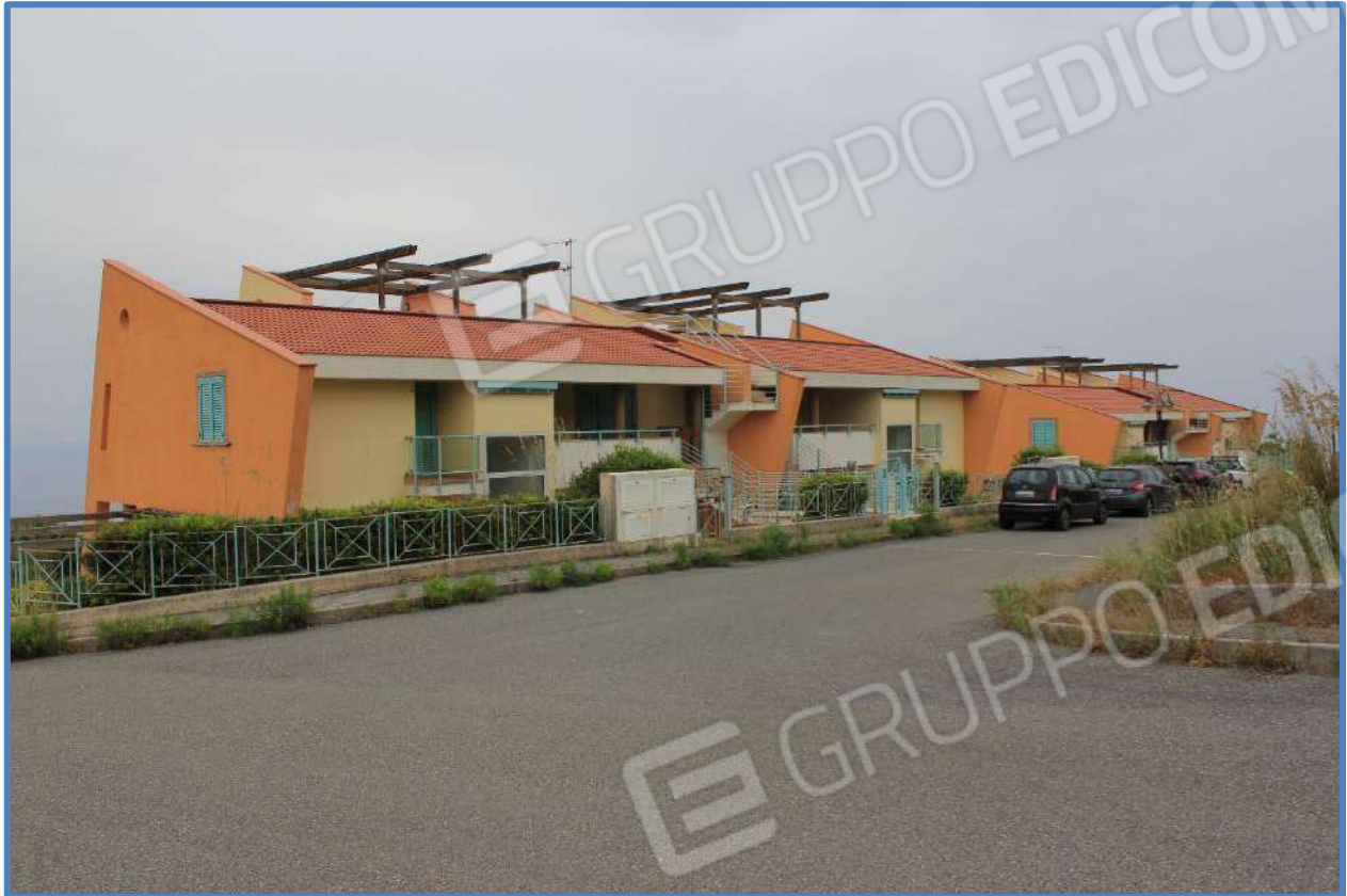
0.3- Complesso edilizio in cui ricadono gli immobili in pignoramento – Vista angolo Est
