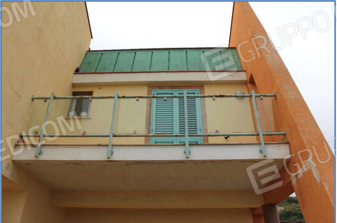
8.8- Balcone della zona notte – piano primo, vista esterna
