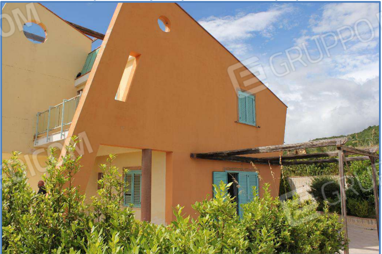
8.2- Facciata del locale "Duplex" – La zona giorno al piano terra, la zona notte al piano primo.
