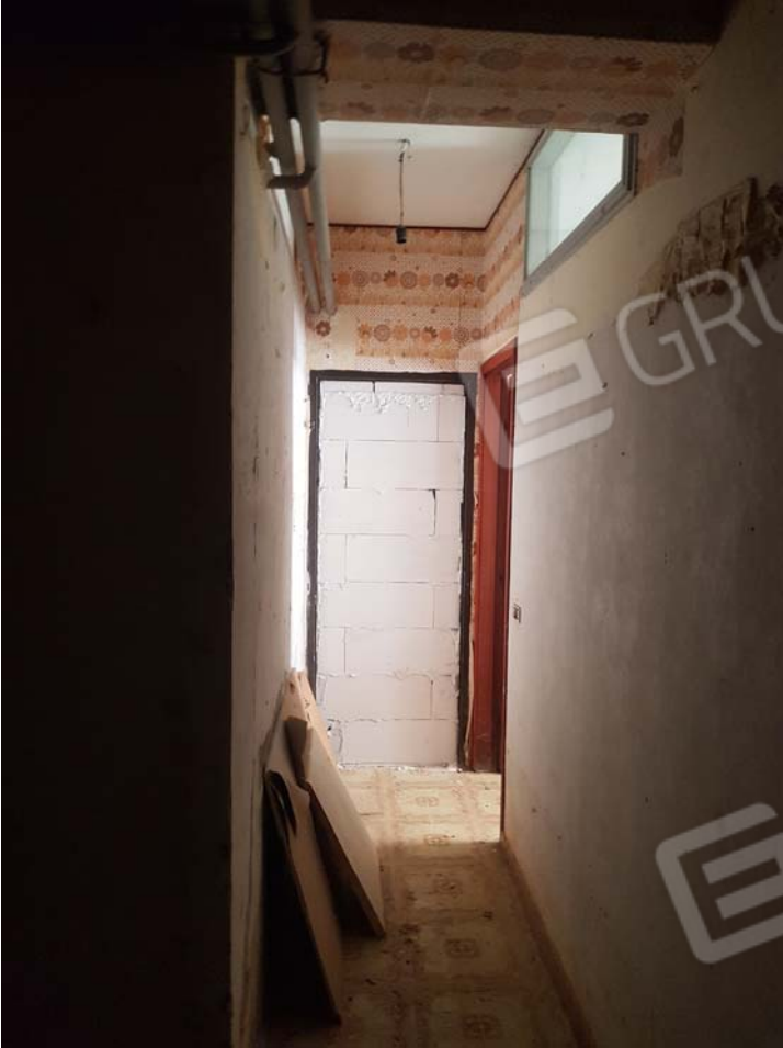
FOTO 49 - Sub.25 appartamento - piano seminterrato
