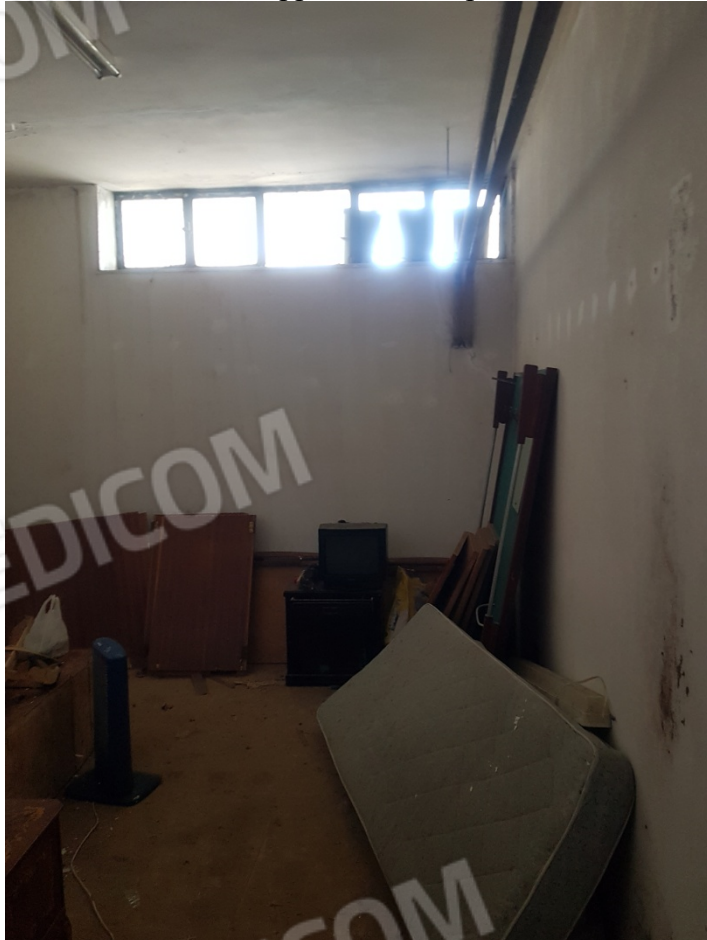
FOTO 36 - Sub.25 appartamento - piano seminterrato
