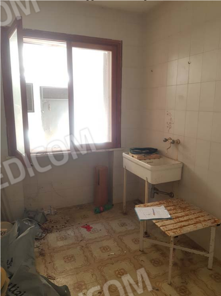
FOTO 48 - Sub.25 appartamento - piano seminterrato
