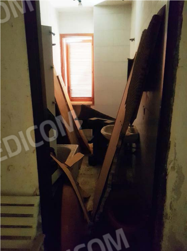
FOTO 50 - Sub.25 appartamento - piano seminterrato
