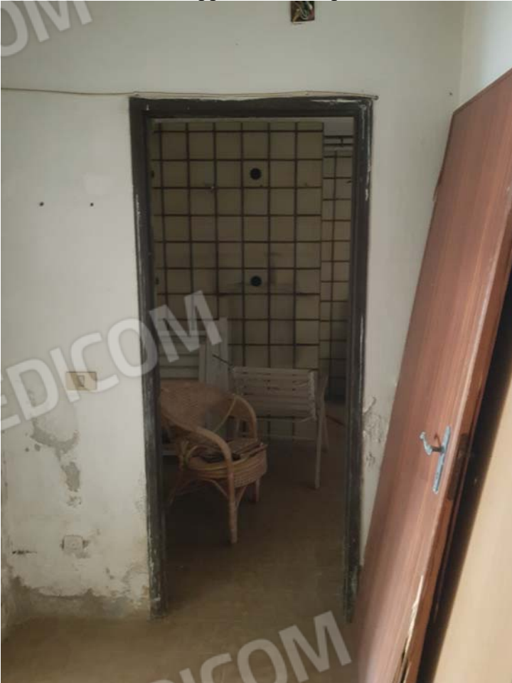
FOTO 38 - Sub.25 appartamento - piano seminterrato
