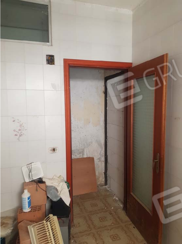
FOTO 47 - Sub.25 appartamento - piano seminterrato
