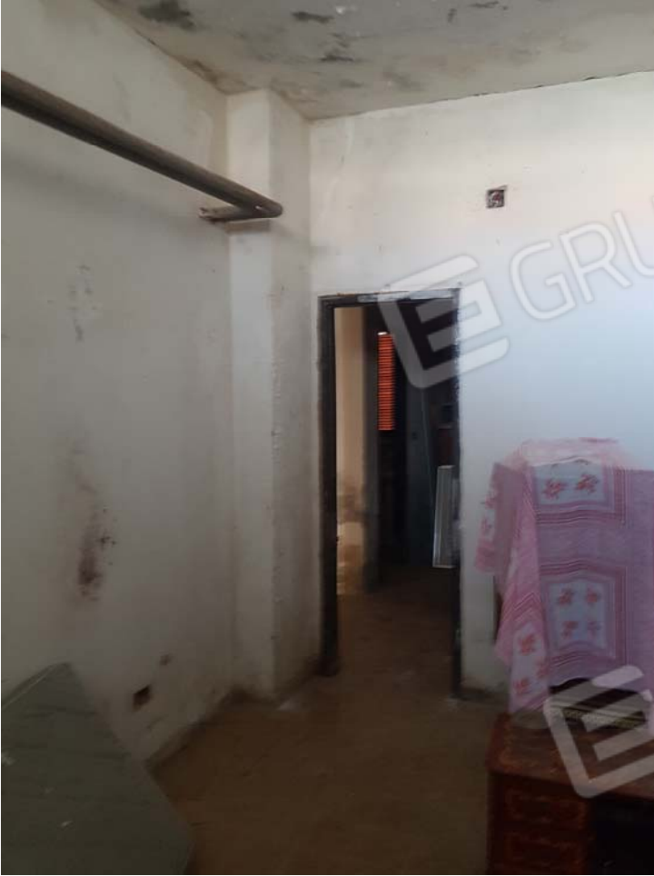
FOTO 37 - Sub.25 appartamento - piano seminterrato
