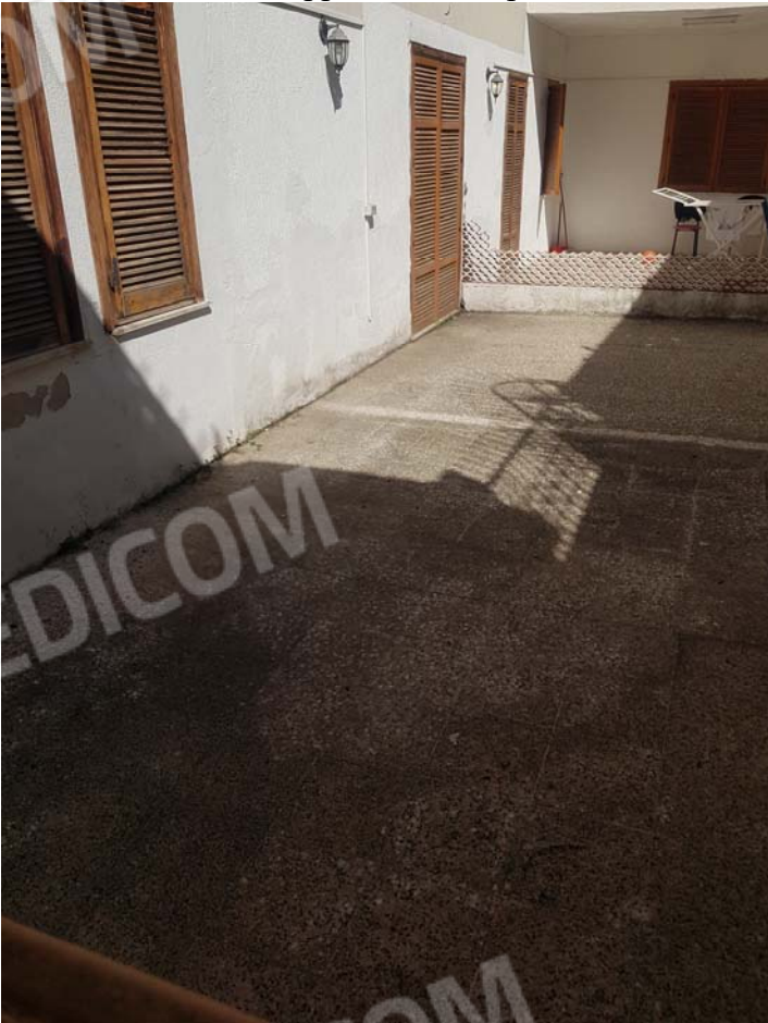
FOTO 44 - Sub.25 appartamento - piano seminterrato
