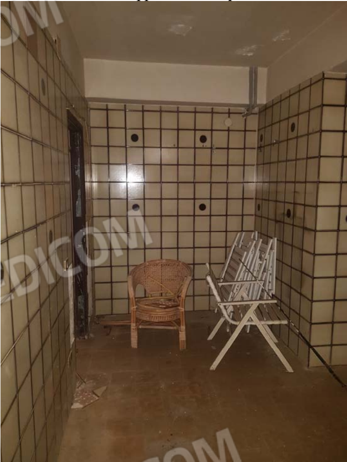
FOTO 40 - Sub.25 appartamento - piano seminterrato
