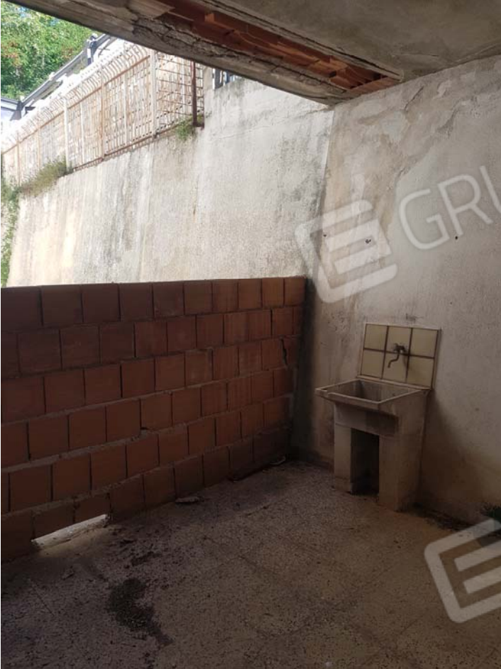
FOTO 43 - Sub.25 appartamento - piano seminterrato
