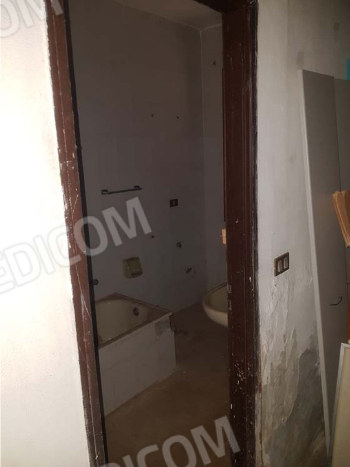
FOTO 34 - Sub.25 appartamento - piano seminterrato
