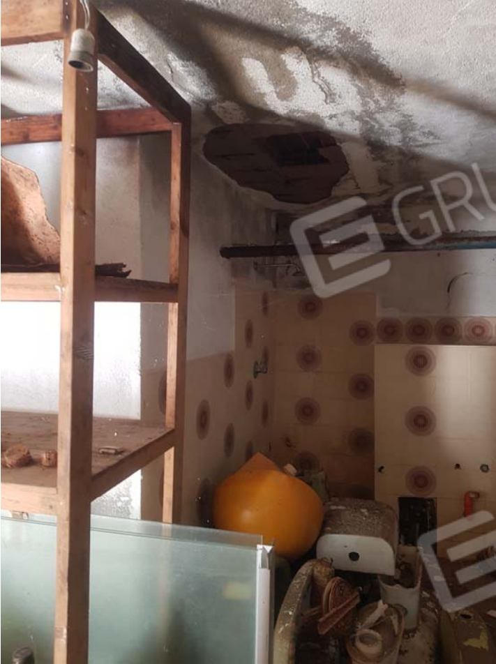
FOTO 19 - Sub.18 magazzino - piano seminterrato
