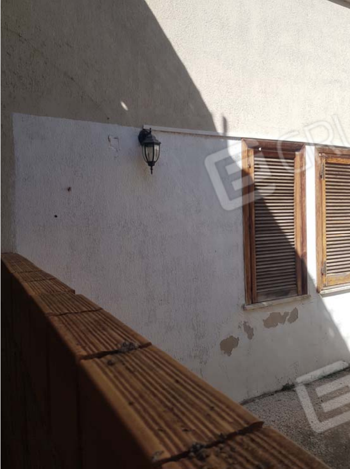
FOTO 45 - Sub.25 appartamento - piano seminterrato
