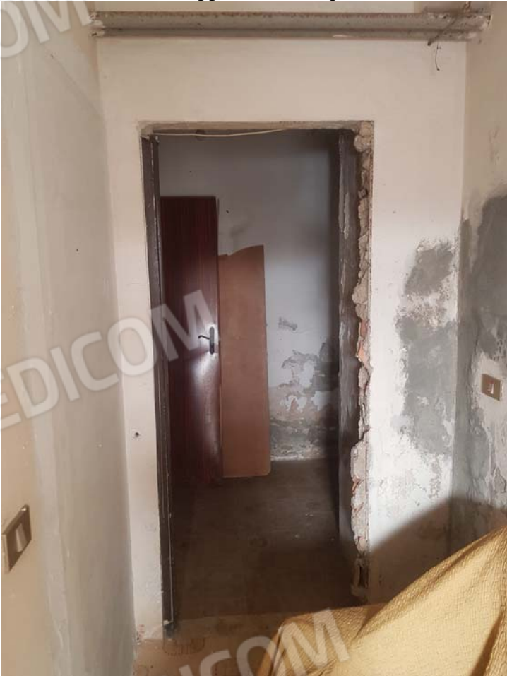
FOTO 32 - Sub.25 appartamento - piano seminterrato
