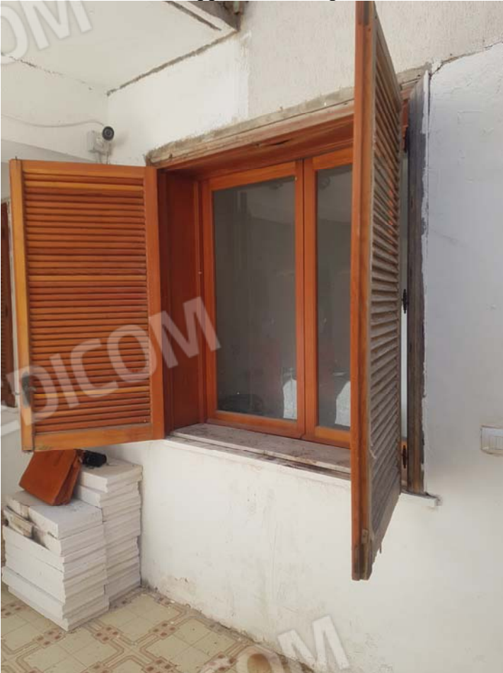
FOTO 46 - Sub.25 appartamento - piano seminterrato
