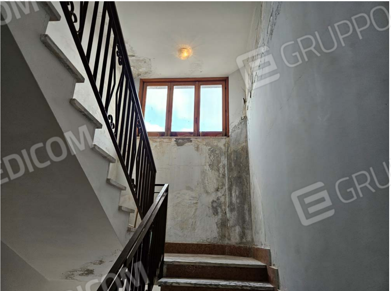
FOTO 14 vano scala fabbricato
