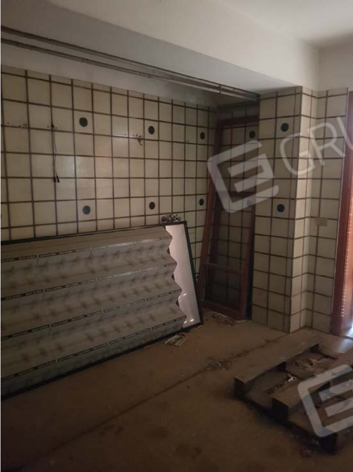
FOTO 39 - Sub.25 appartamento - piano seminterrato
