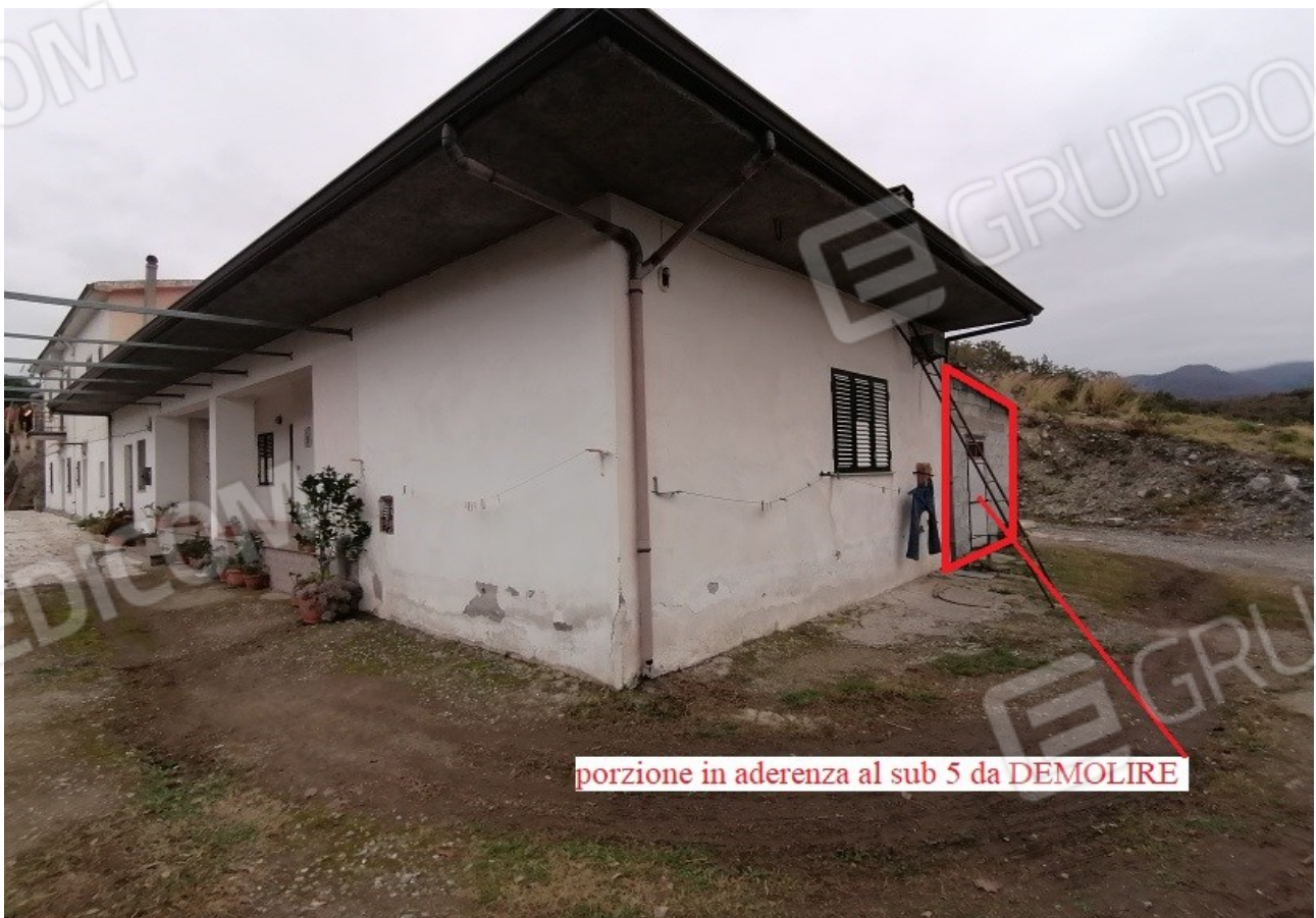
Foto n° 10 – Vista esterna con prospetto sud-ovest (angolo sub 5) –
