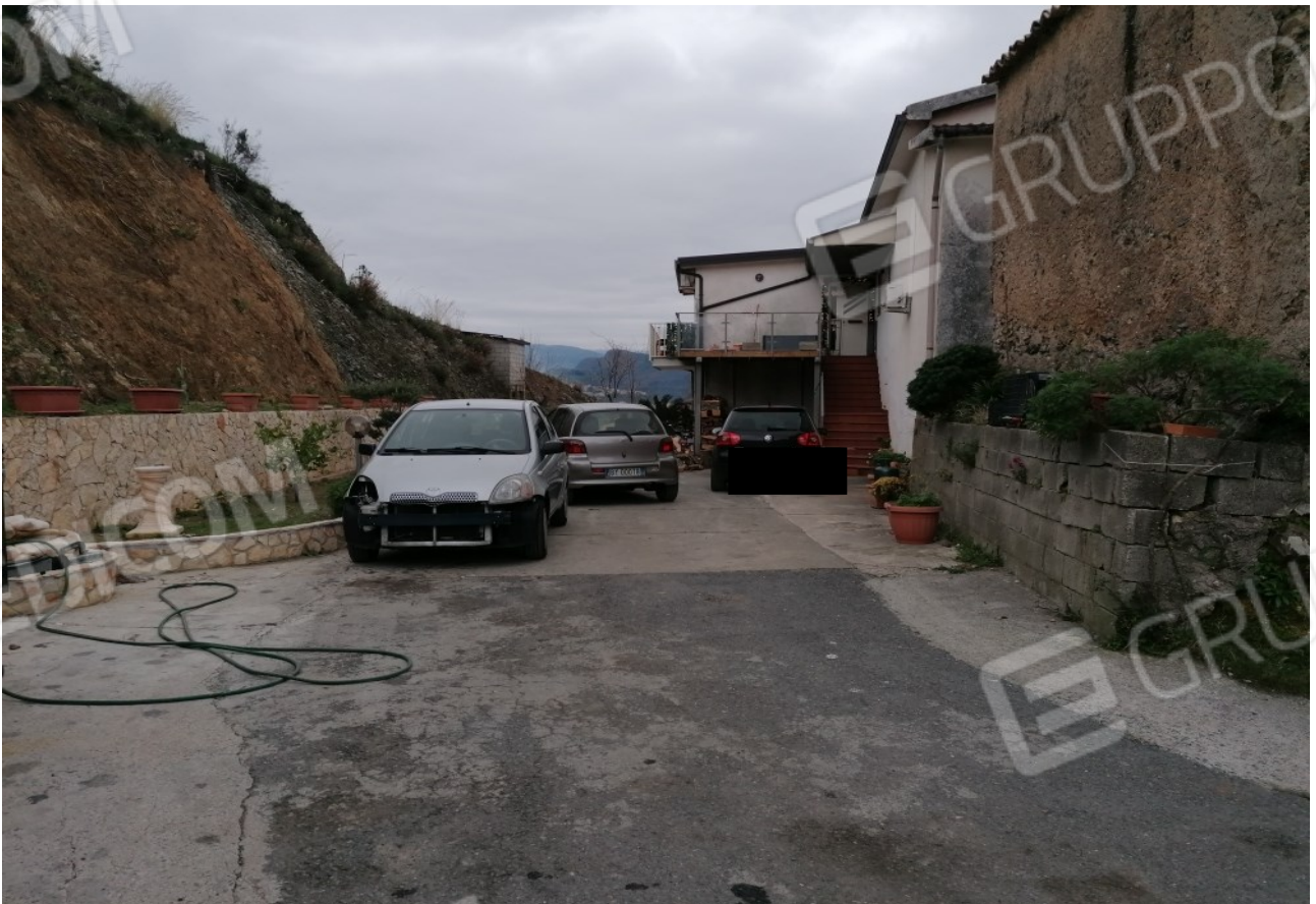
Foto n° 6 – Vista esterna su corte privata di accesso prospiciente a est (immobili interessati NON visibili sul retro) –
