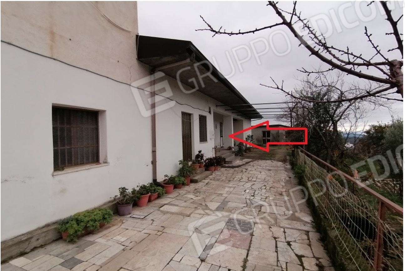
Foto n° 7 – Vista esterna con prospetto ovest degli immobili direzione sud –
