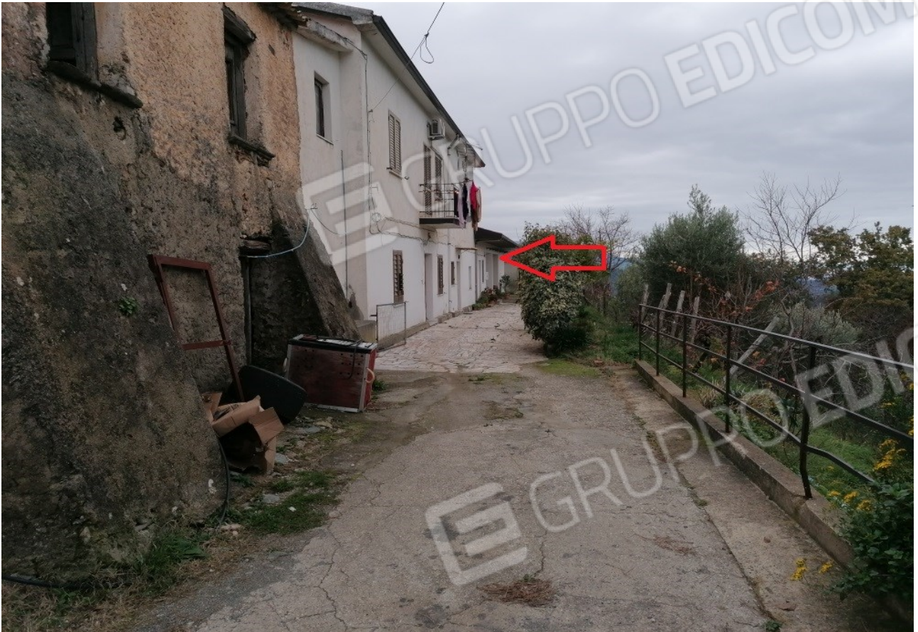
Foto n° 5 – Vista esterna su corte privata di accesso prospiciente a ovest -
