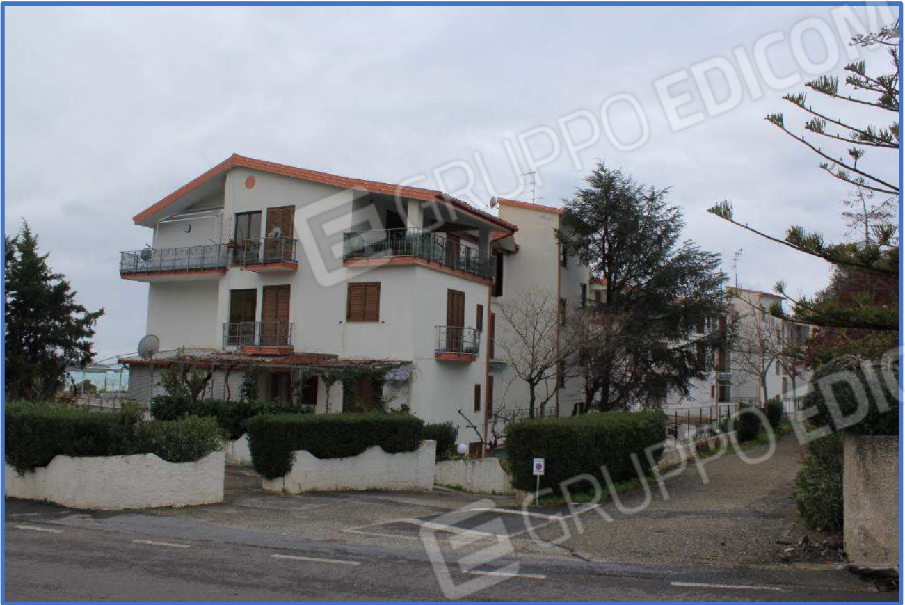
1.3- Vista del fabbricato condominiale (Corpo A) – Angolo Nord/Est
