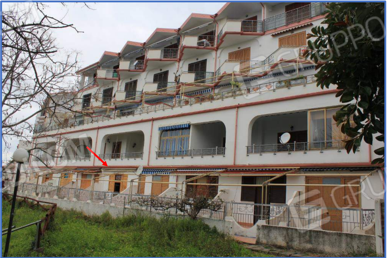
1.4 – Vista del fabbricato condominiale (Corpo A) con indicazione della posizione degli immobili – Fronte Sud
