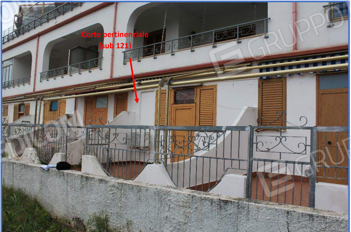
1.14- Vista della corte pertinenziale in oggetto (subalterno 121), da cui si accede all'abitazione
