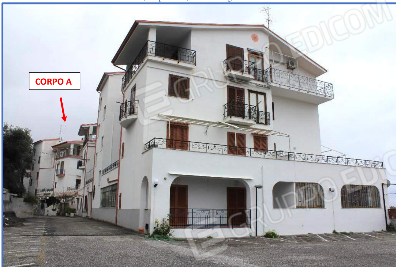
1.5 – Vista del fabbricato condominiale (Corpo B+A) – Vista angolo nord /Ovest
