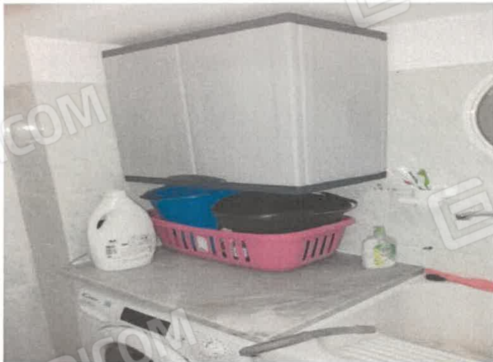
FOTO WC ALL'INTERNO DEL RIPOSTIGLIO
