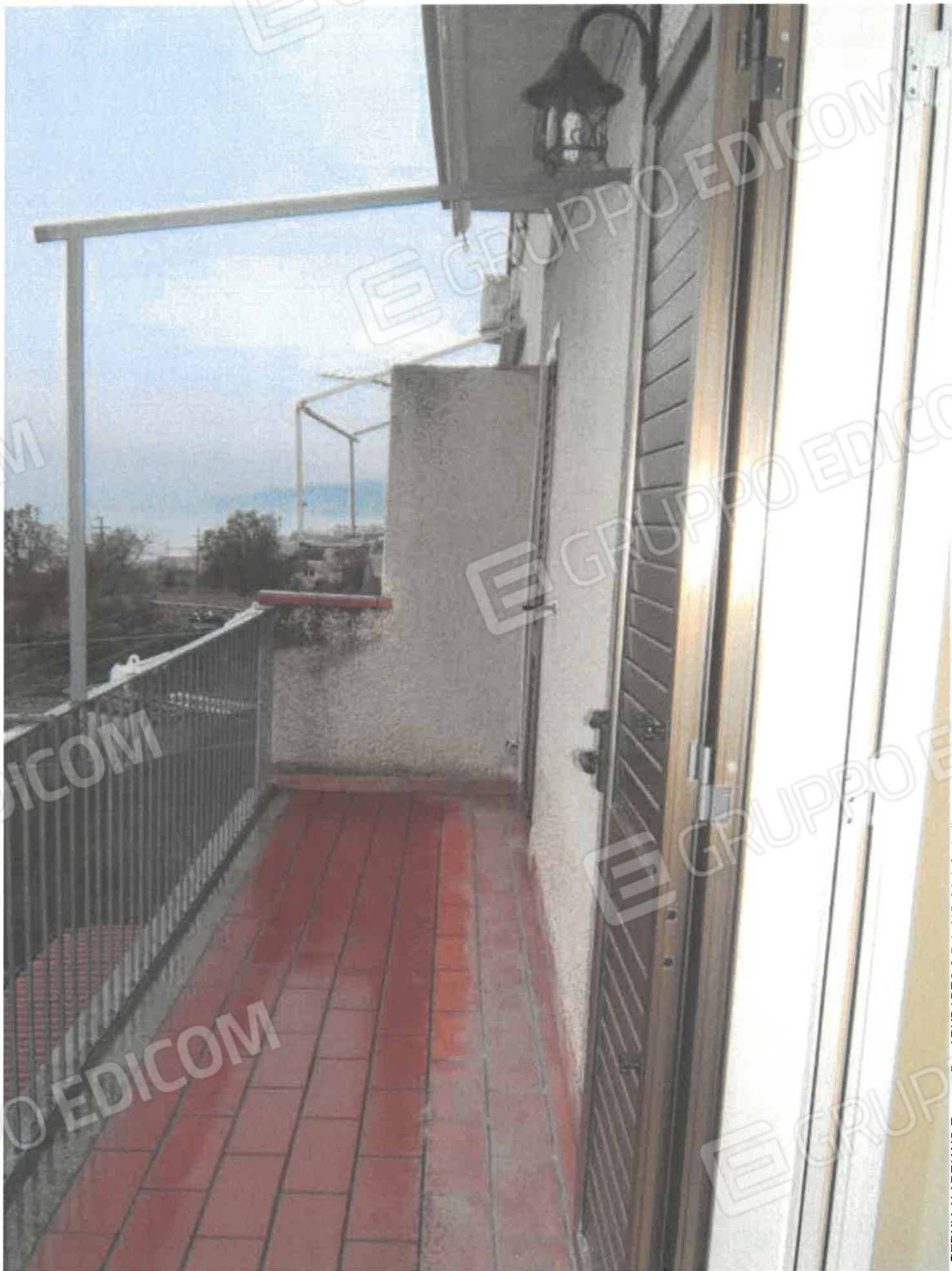
FOTO TERRAZZO LATO OVEST
