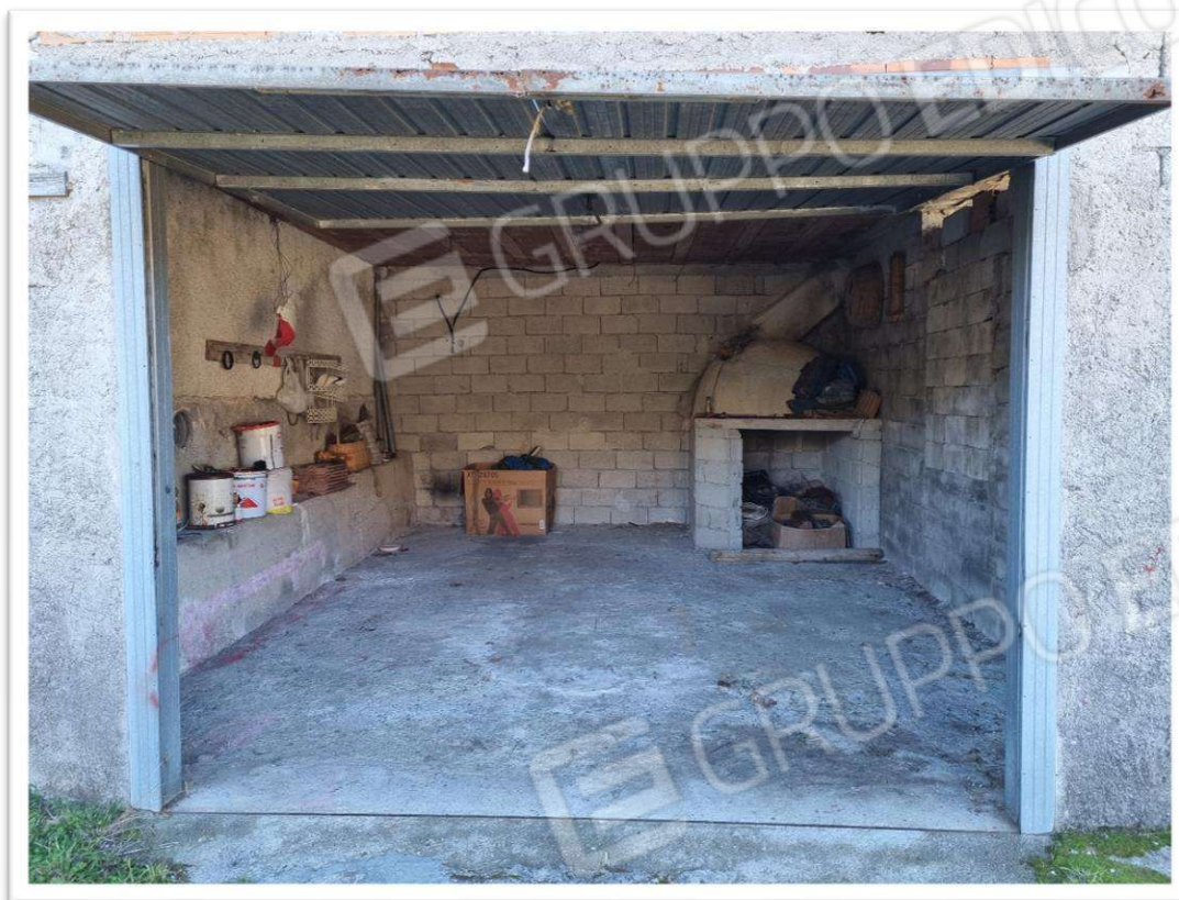
Foto 16 – Locale garage - piano 1°sottostrada
