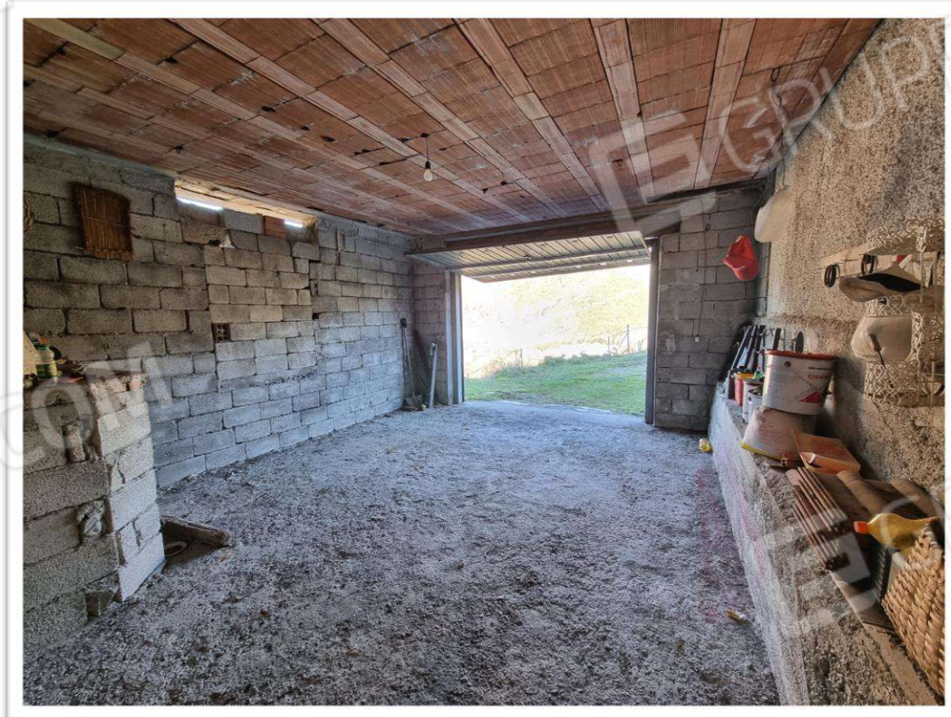
Foto 17 – Locale garage - piano 1°sottostrada
