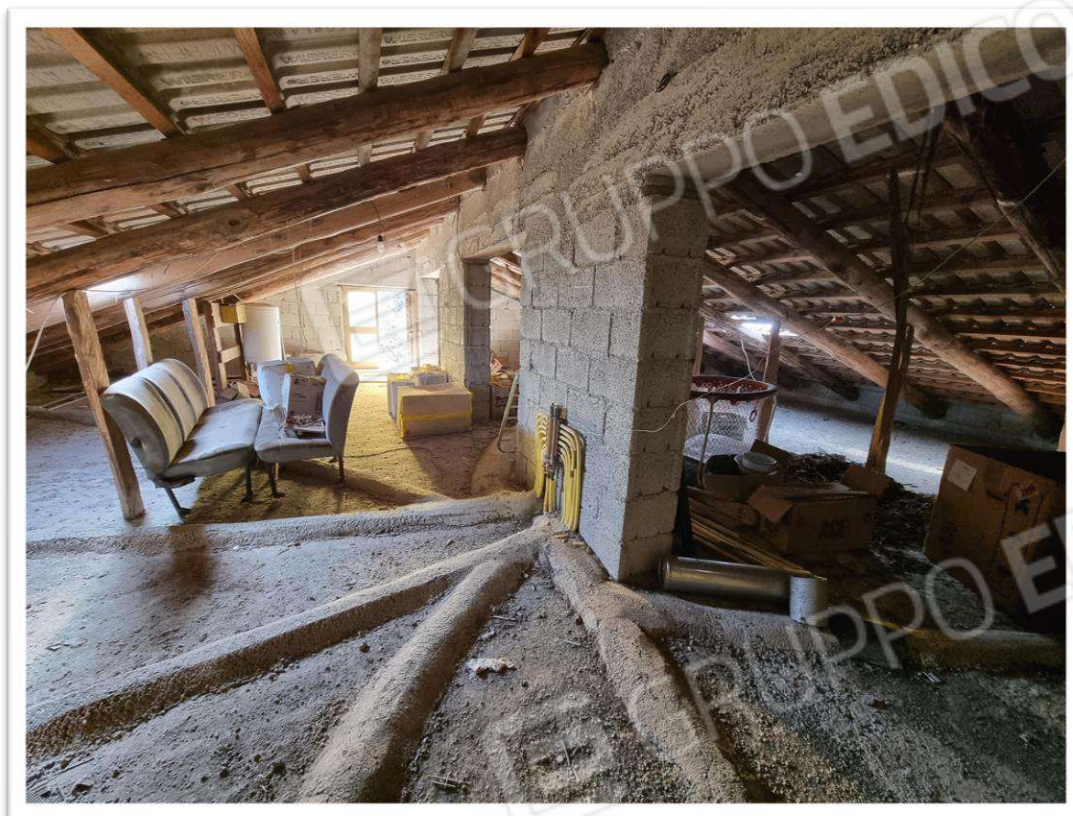
Foto 18 – Locale di sgombero - piano sottotetto
