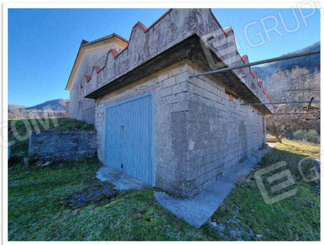
Foto 6 – Particolare vista Nord/Ovest
