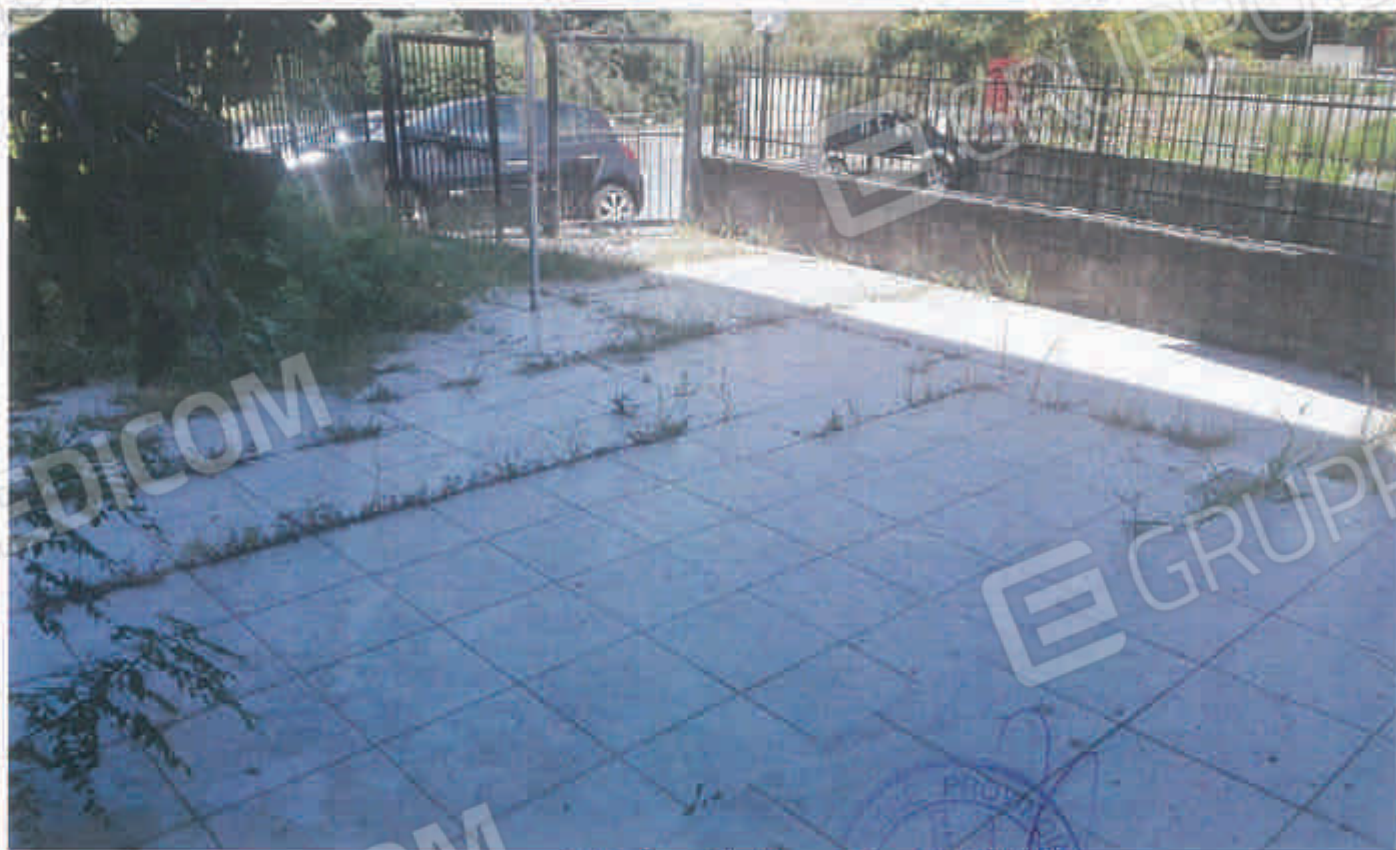
Foto n. 6 – cortile lato nord
