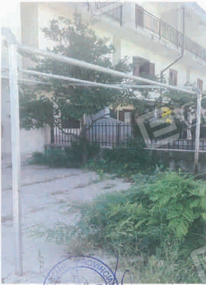
Foto n. 7 - cortile lato nord
