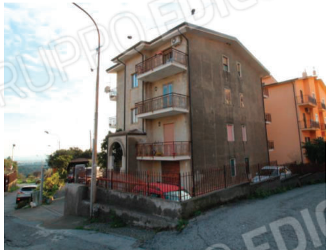
Foto 2: Prospetti est e nord fabbricato
