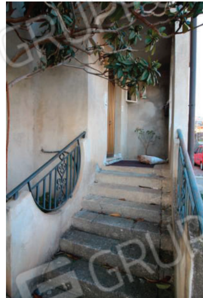
Foto 4: Particolare scale di ingresso fabbricato da completare
