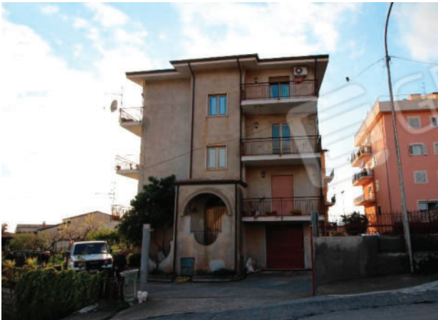
Foto 1: Prospetto principale fabbricato esposizione est
