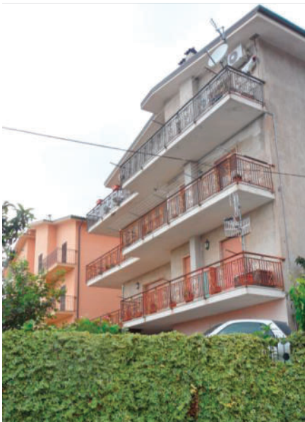
Foto 3: Prospetto sud fabbricato
