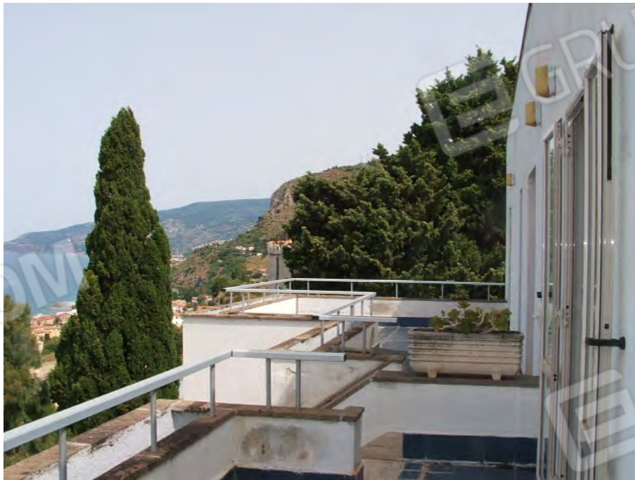
Vista verso nord-ovest
