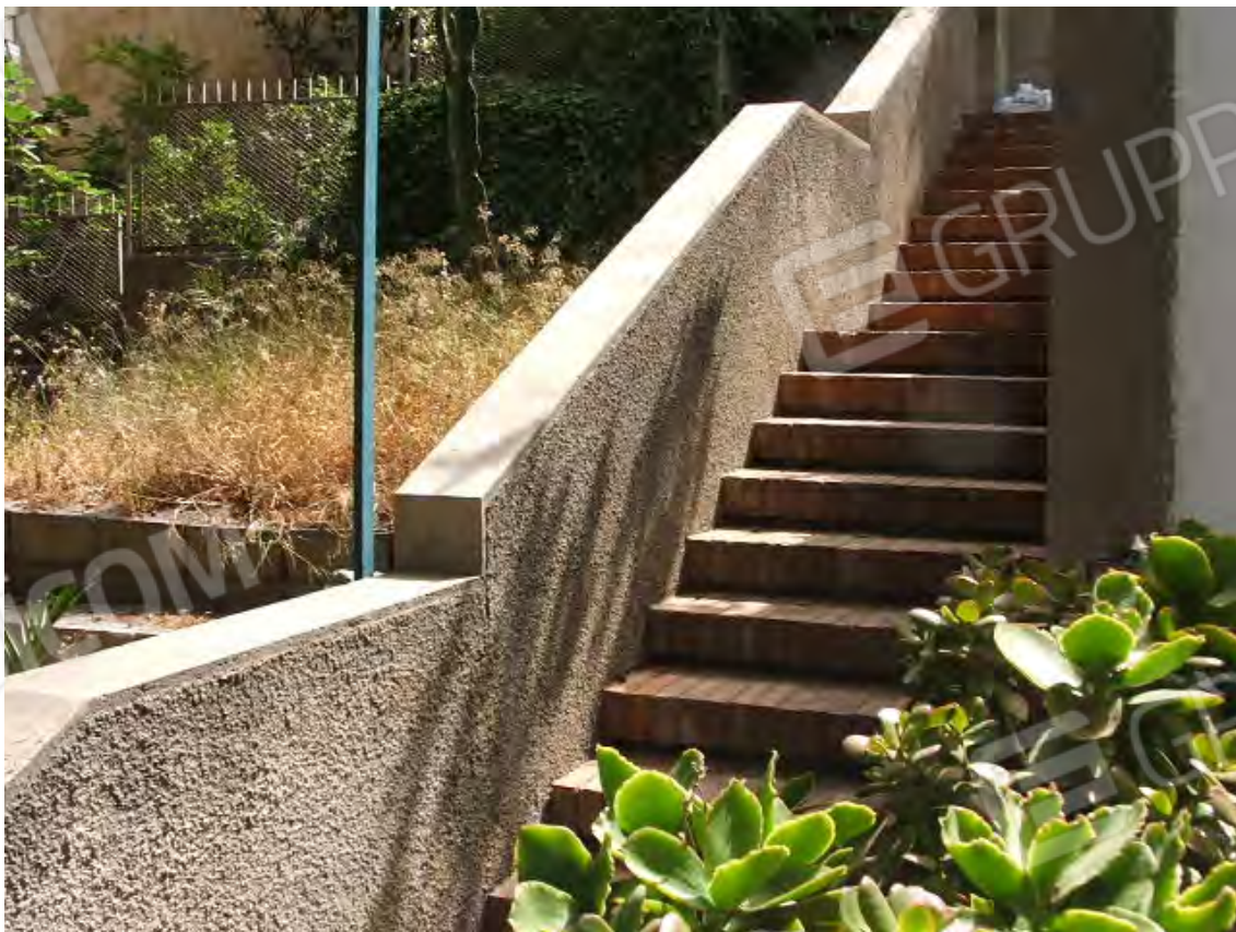
Scalinata verso il piano terra unità collabenti
