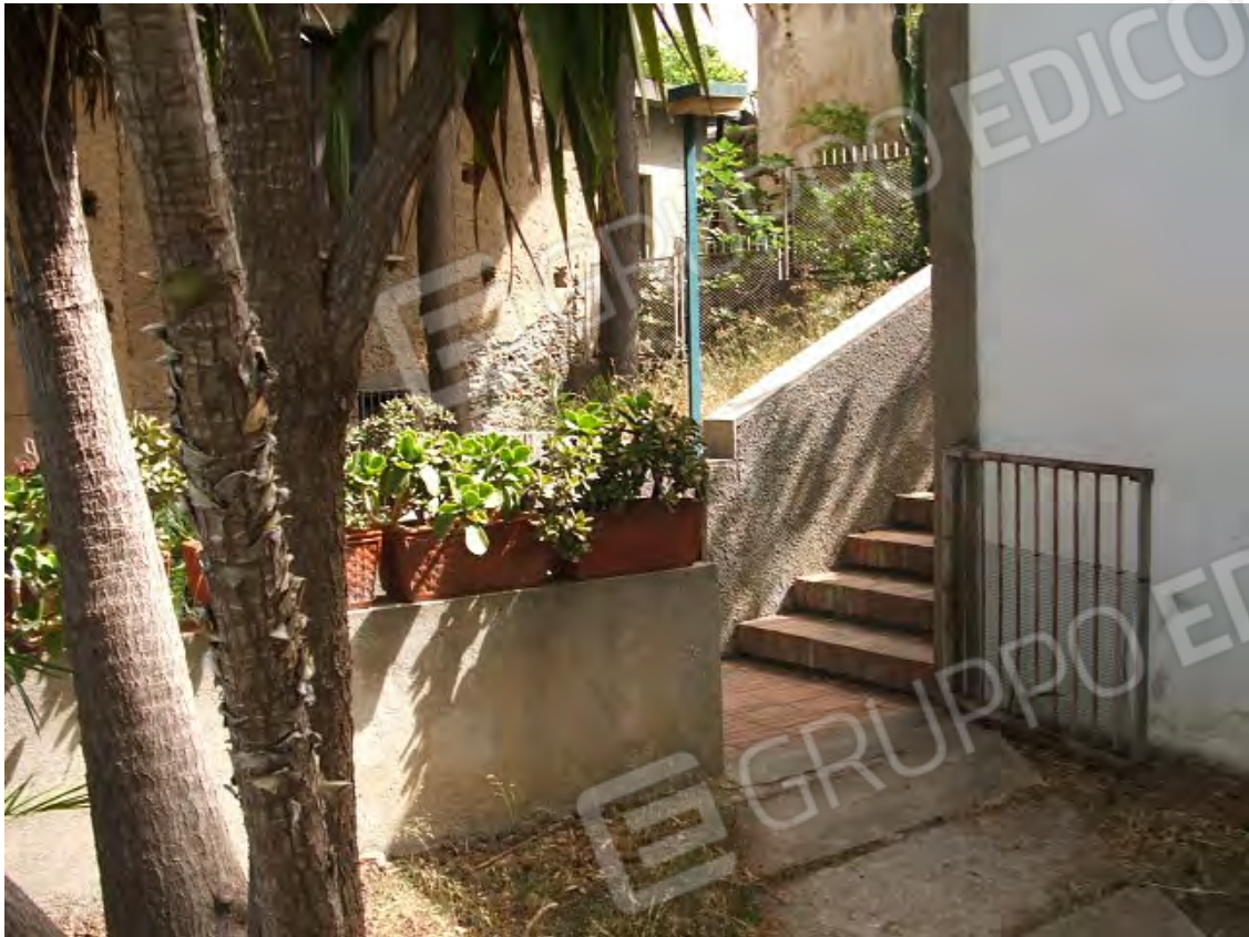
Scalinata verso il piano terra unità collabenti
