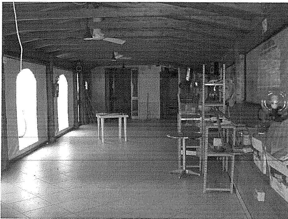
Vista all'interno del corpo di fabbrica con struttura in legno.
