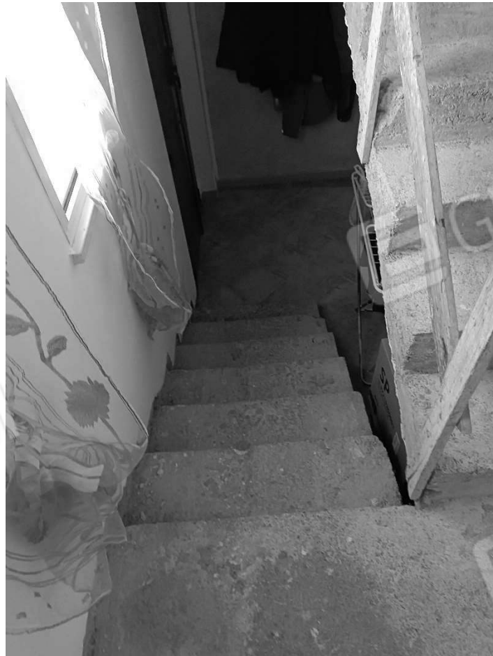
Foto n. 10 – vano scala di collegamento tra piano terra e piano primo
