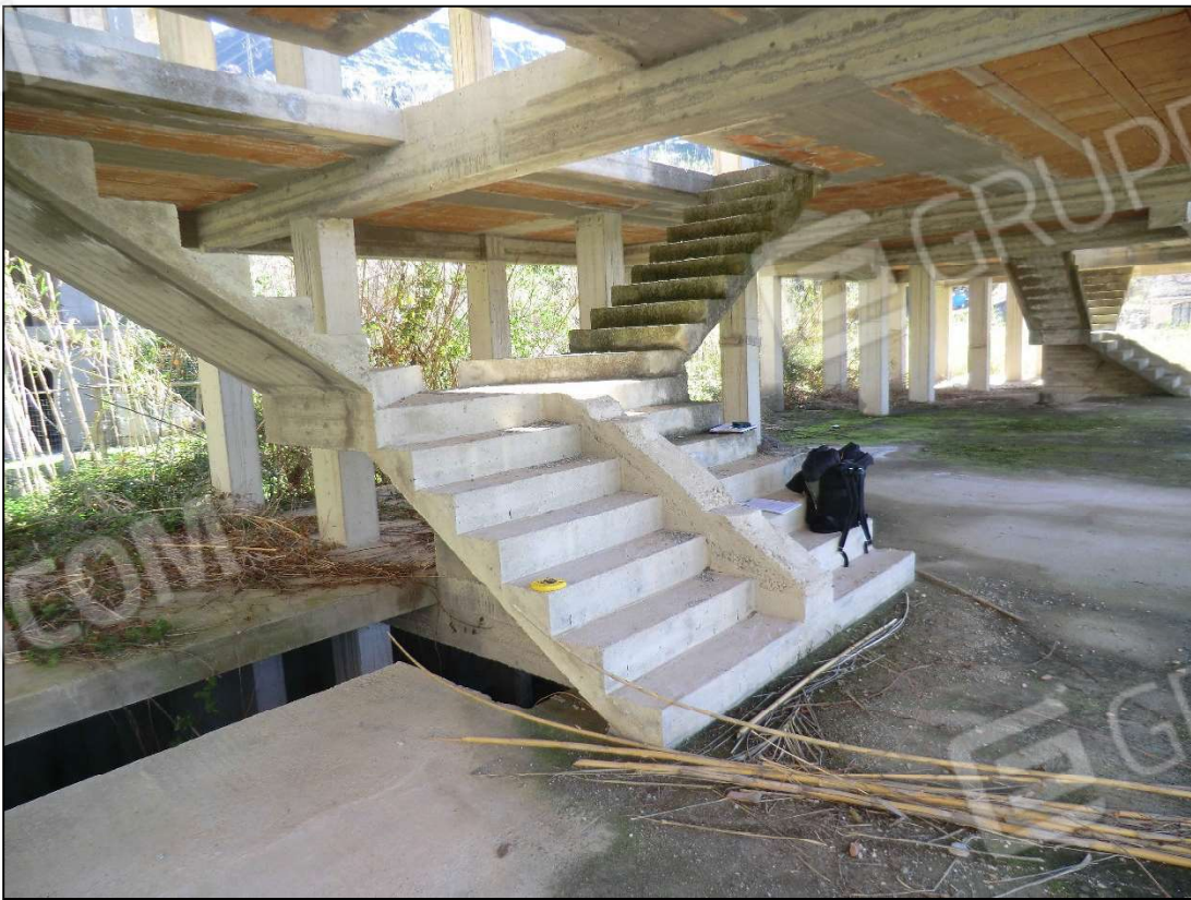
Foto 14_piano terra vista verso sud
