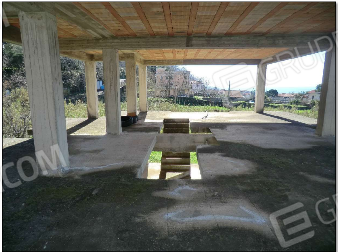
Foto 16_piano primo vista verso sud
