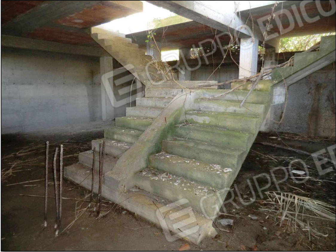
Foto 11_piano interrato lato nord
