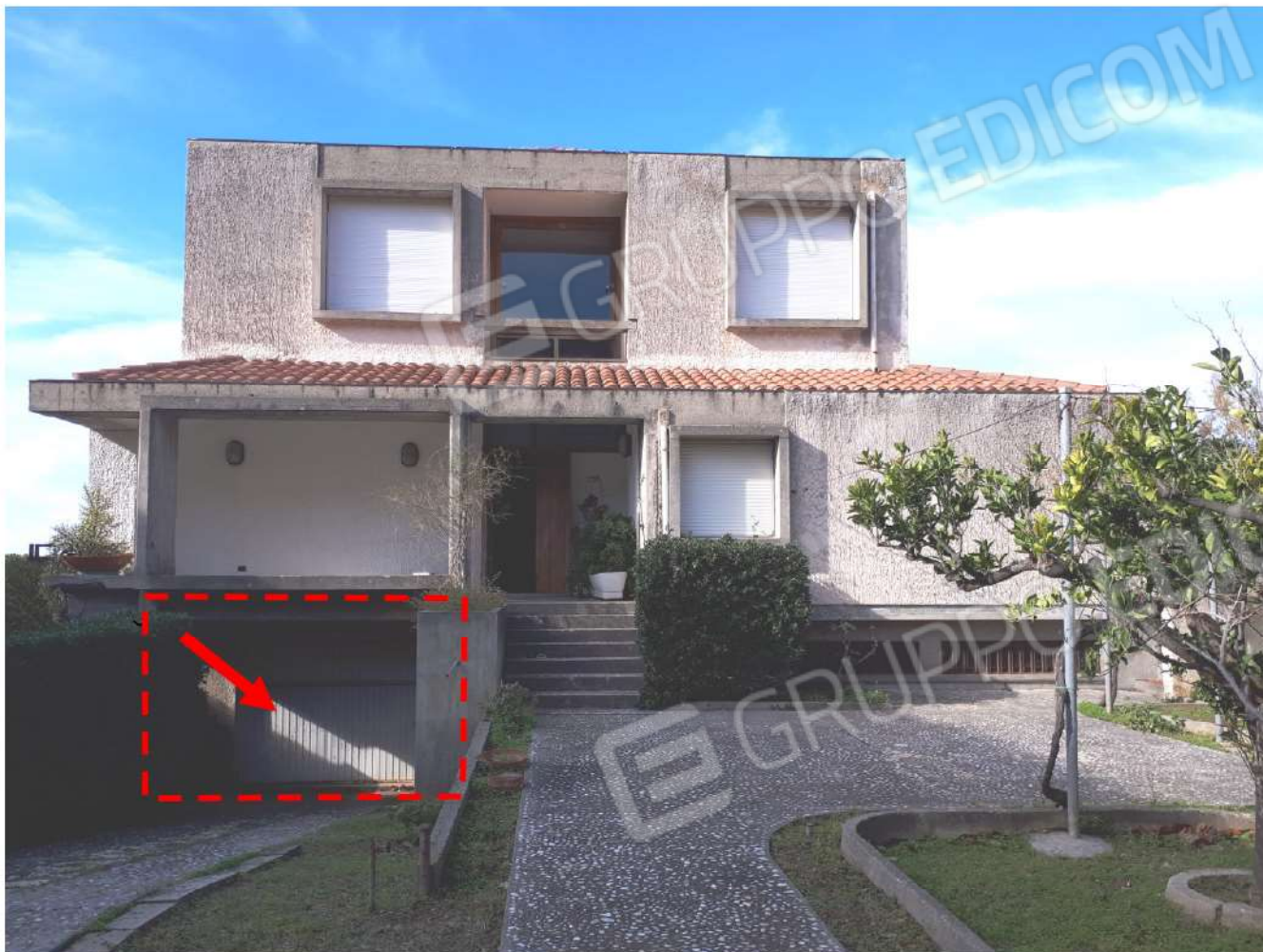
FOTO 3 – VISTA DA EST (INGRESSO GARAGE)
