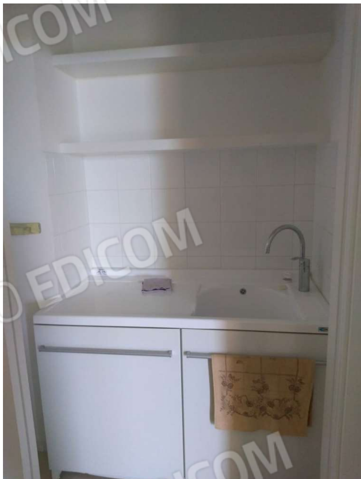
FOTO 12 – LAVATOIO ANGOLO COTTURA Piano T
