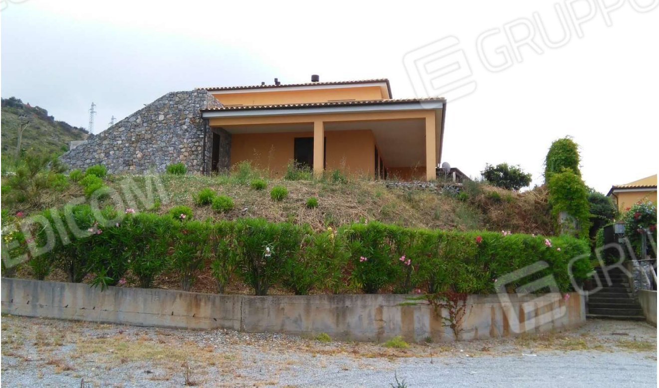
FOTO 02 – VISTA DA NORD
