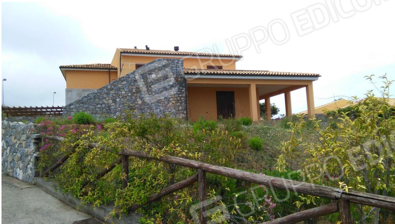
FOTO 03 – VISTA DA NORD/EST
