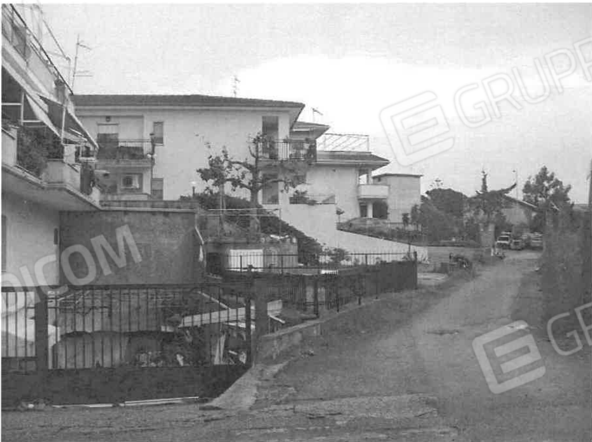
Strada di accesso all'edificio part.IIa 582
