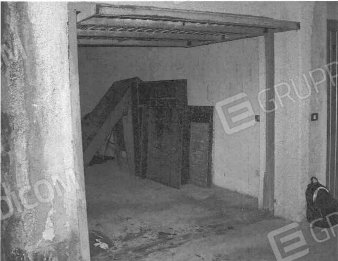
Interno del Box-autorimessa di proprietà di [redacted] sub. 20
