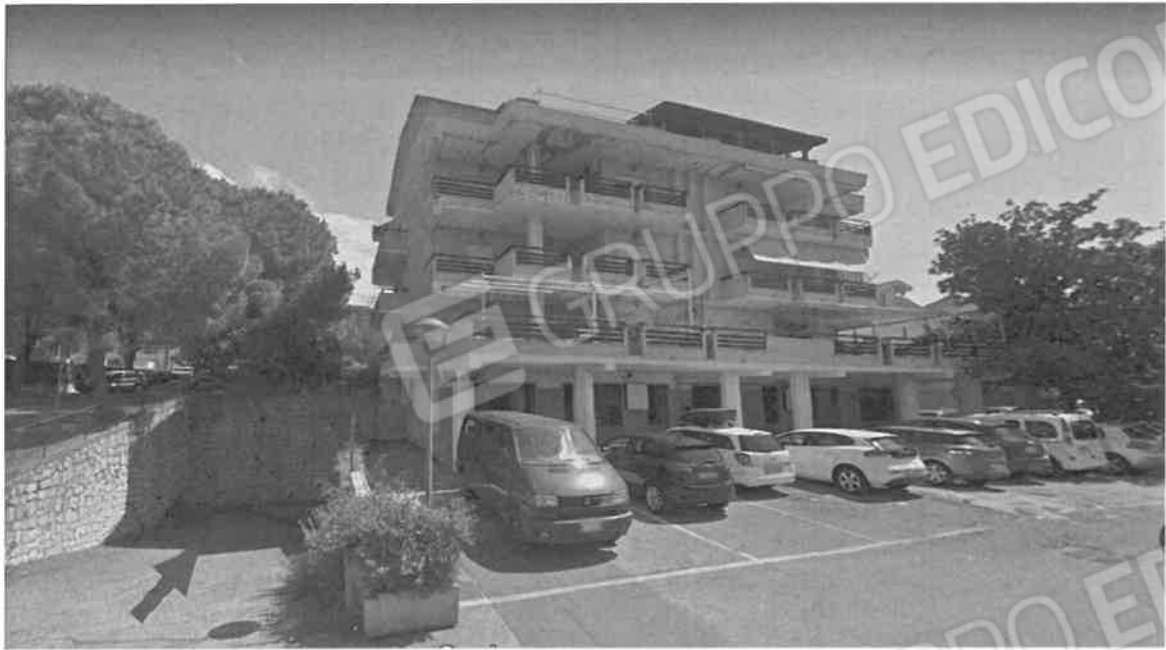
Rampa di accesso al piano interrato
