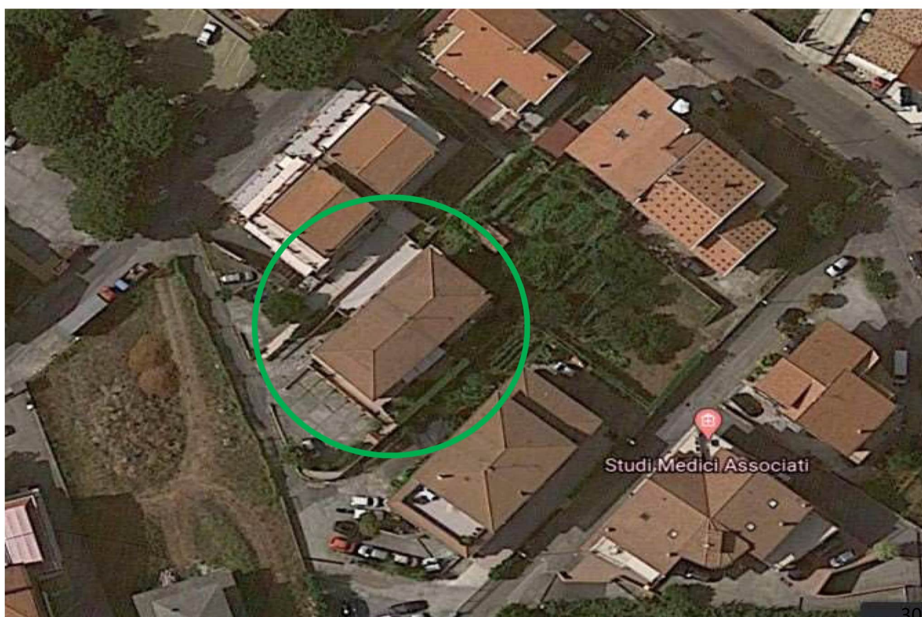
Edificio identificato con la particella n° 582
