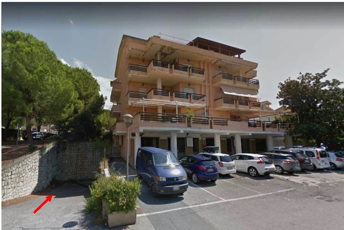
Vista prospettica lato nord dell'edificio "A" contraddistinto con la particella n° 299 con l'indicazione del punto di accesso che conduce verso l'interrato del medesimo edificio, in cui sono ubicate le due autorimesse oggetto di
