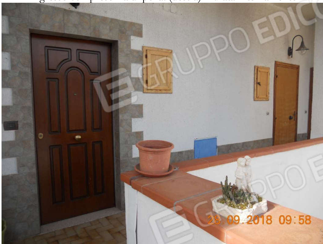
Ingresso con presenza di porta (destra) murata internamente
