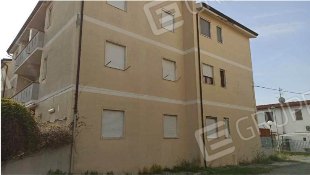
Foto n° 4 – Esterno fabbricato lato ovest
