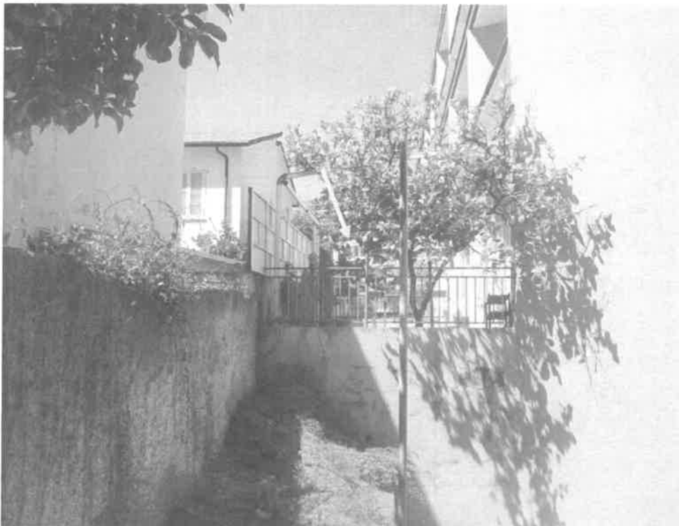
Foto n. 13 – corte dell'appartamento (part. n. 329 sub 16)
