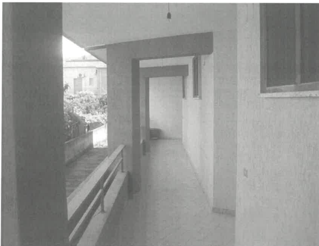
Foto n. 5 – ballatoio accesso appartamenti al piano terra
