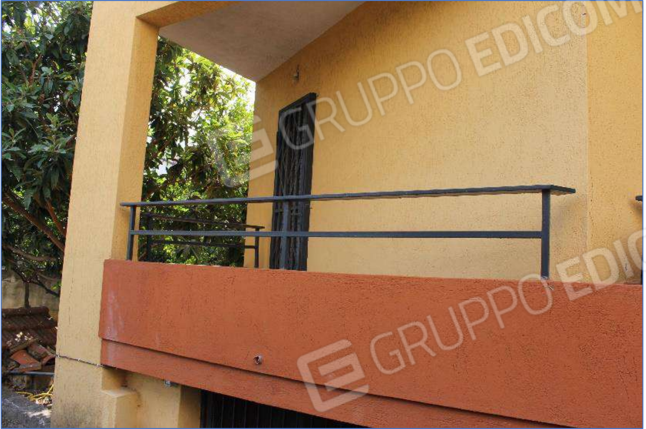
2.18- Balcone della camera lato Nord
