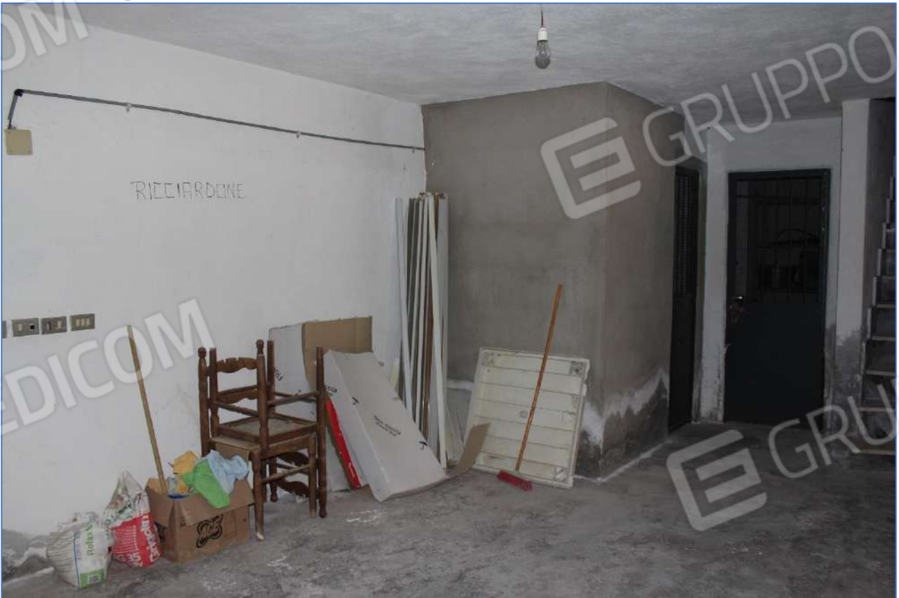
2.25- Vista del posto auto in esecuzione
