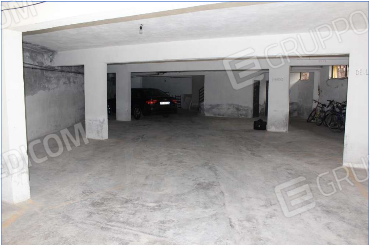
2.23- Autorimessa al seminterrato, vista dall'ingresso
