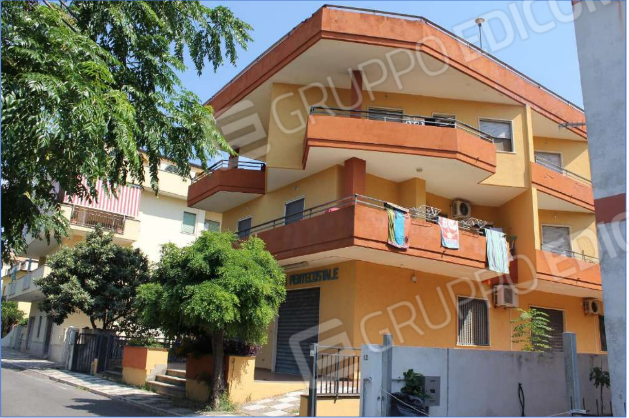
1.3- Vista del fabbricato – angolo Sud
