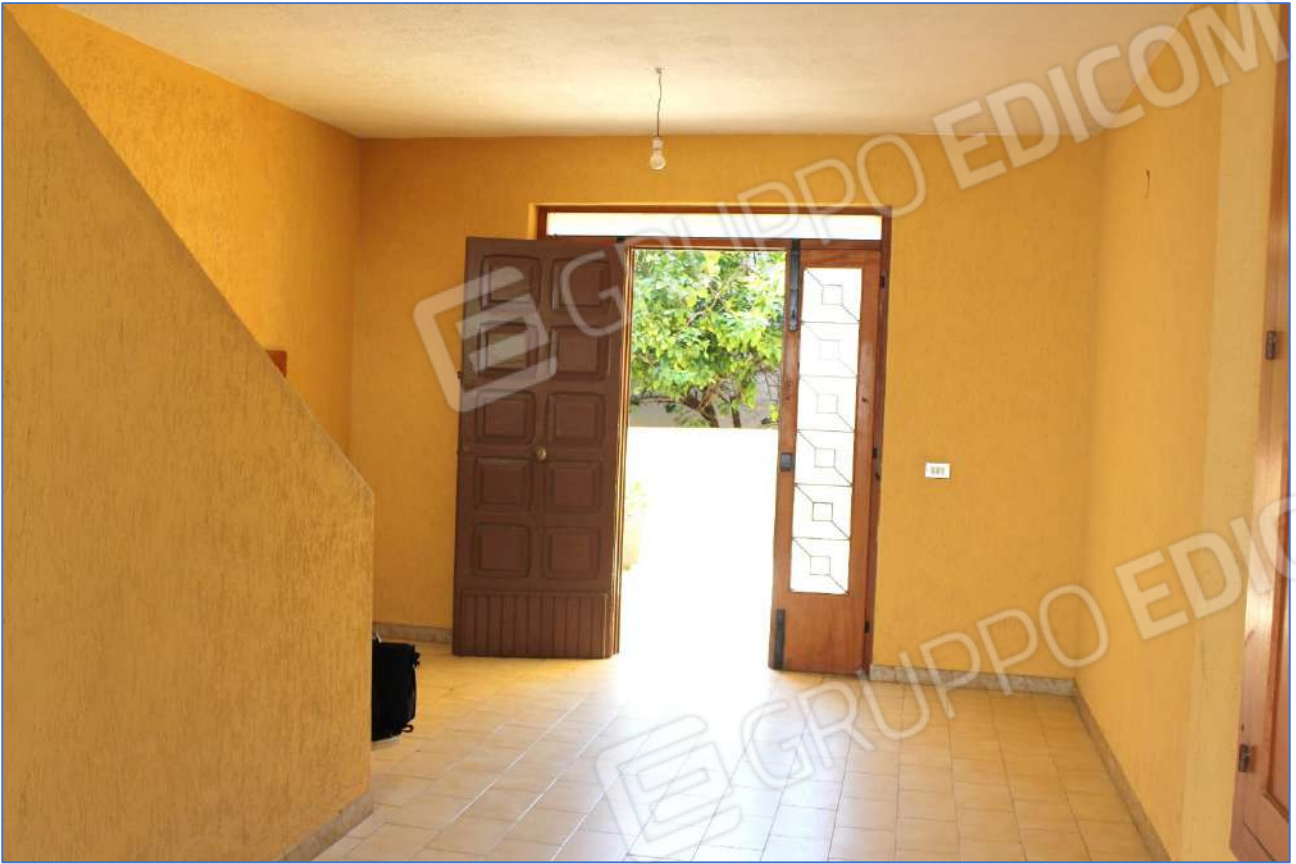
1.7- Portone d'accesso alle abitazioni – vista dell'androne che conduce ai disimpegni e al vano scala
