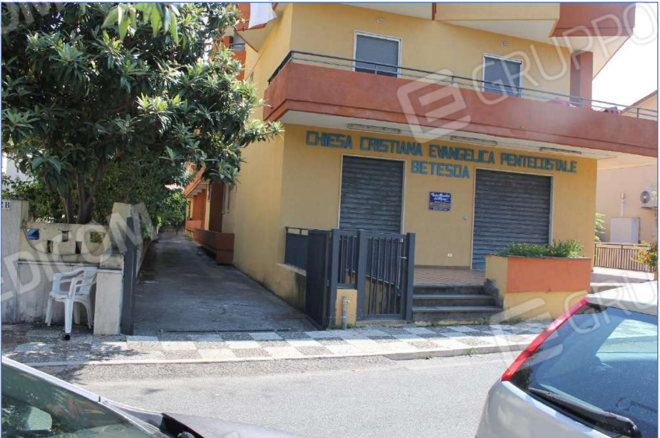
1.10- Vista dell'ingresso carrabile verso il piano seminterrato (accesso all'autorimessa)
