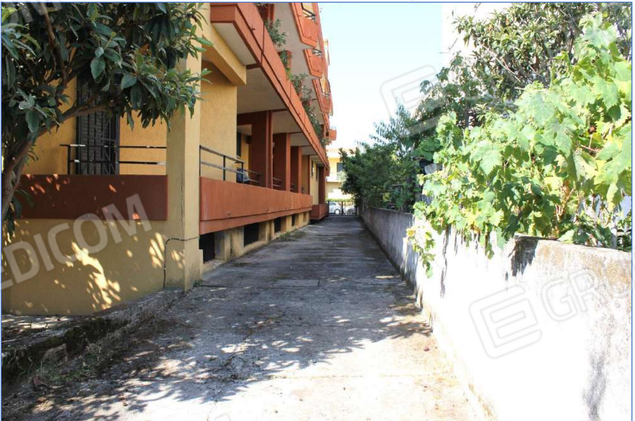
1.12- percorso carrabile verso il piano seminterrato – Vista verso l'ingresso su strada e verso l'abitazione
