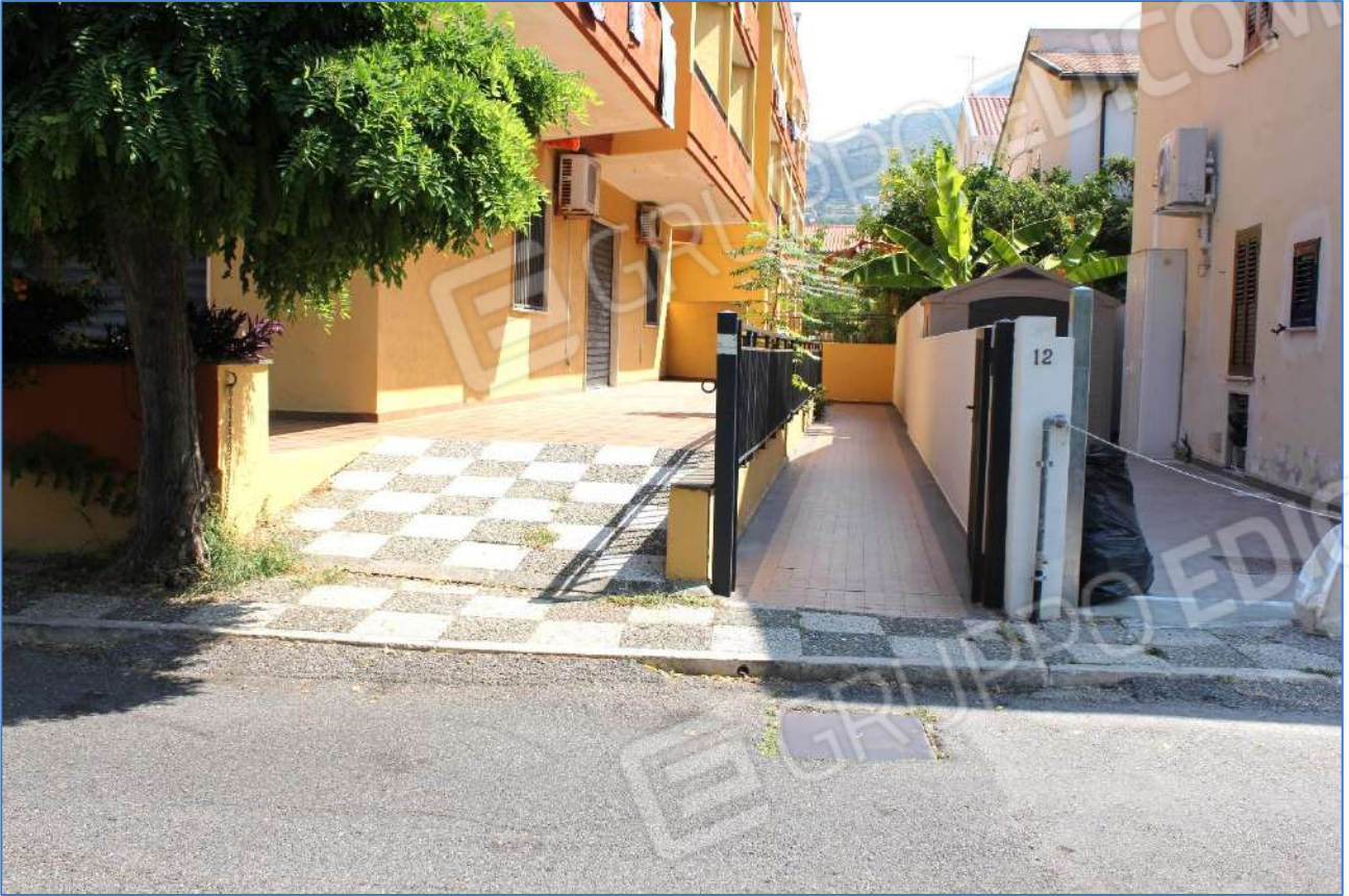
1.5- Ingresso laterale e disimpegno conducente al portone d'accesso alle abitazioni, posto sul retro del fabbricato
