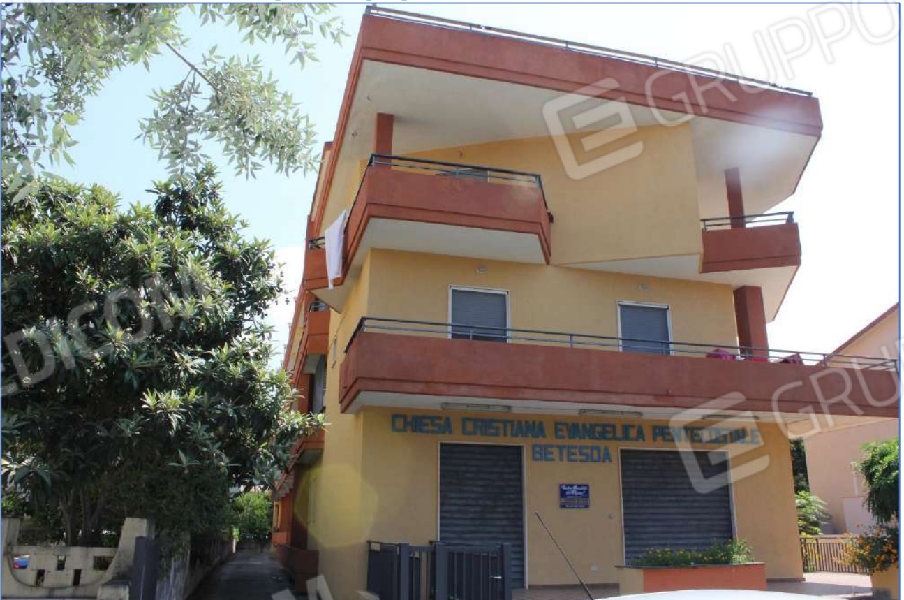
1.4- Vista del fabbricato dalla via pubblica – prospetto lato Sud/Ovest
