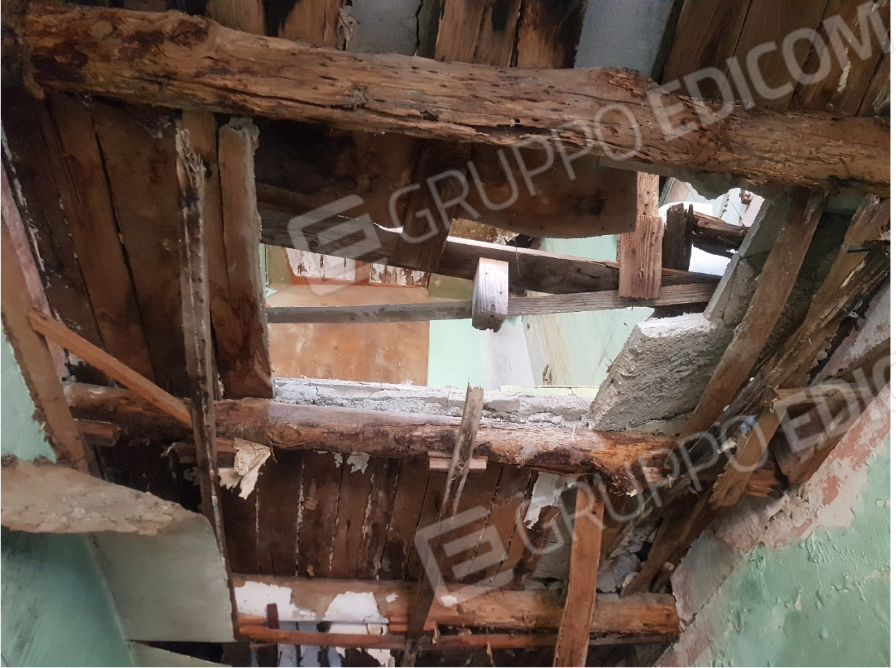
FOTO 52 interno Foglio 40 p.la 49 Sub.5
