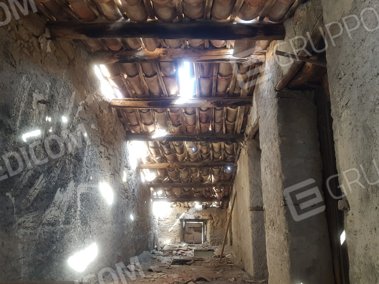
FOTO 65 interno Foglio 40 p.lla 49 Sub.5
