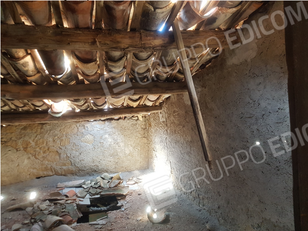
FOTO 70 interno Foglio 40 p.lla 49 Sub.5
