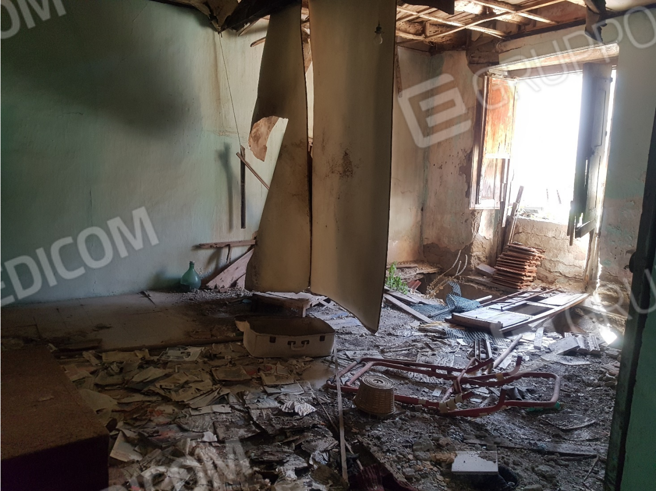
FOTO 61 interno Foglio 40 p.la 49 Sub.5
