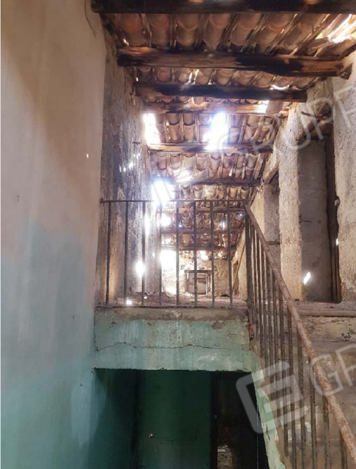
FOTO 64 interno Foglio 40 p.lla 49 Sub.5
