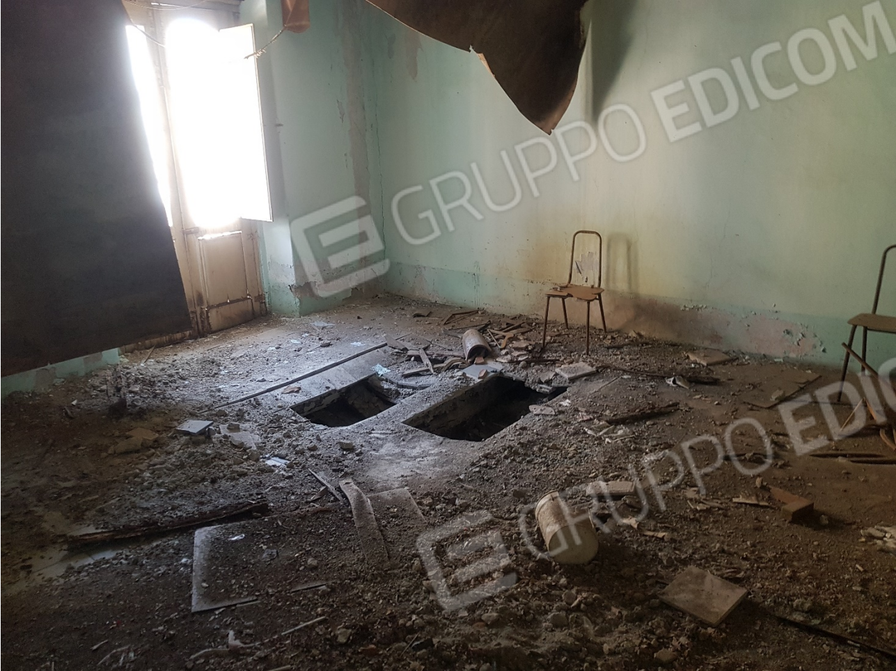
FOTO 58 interno Foglio 40 p.lla 49 Sub.5
