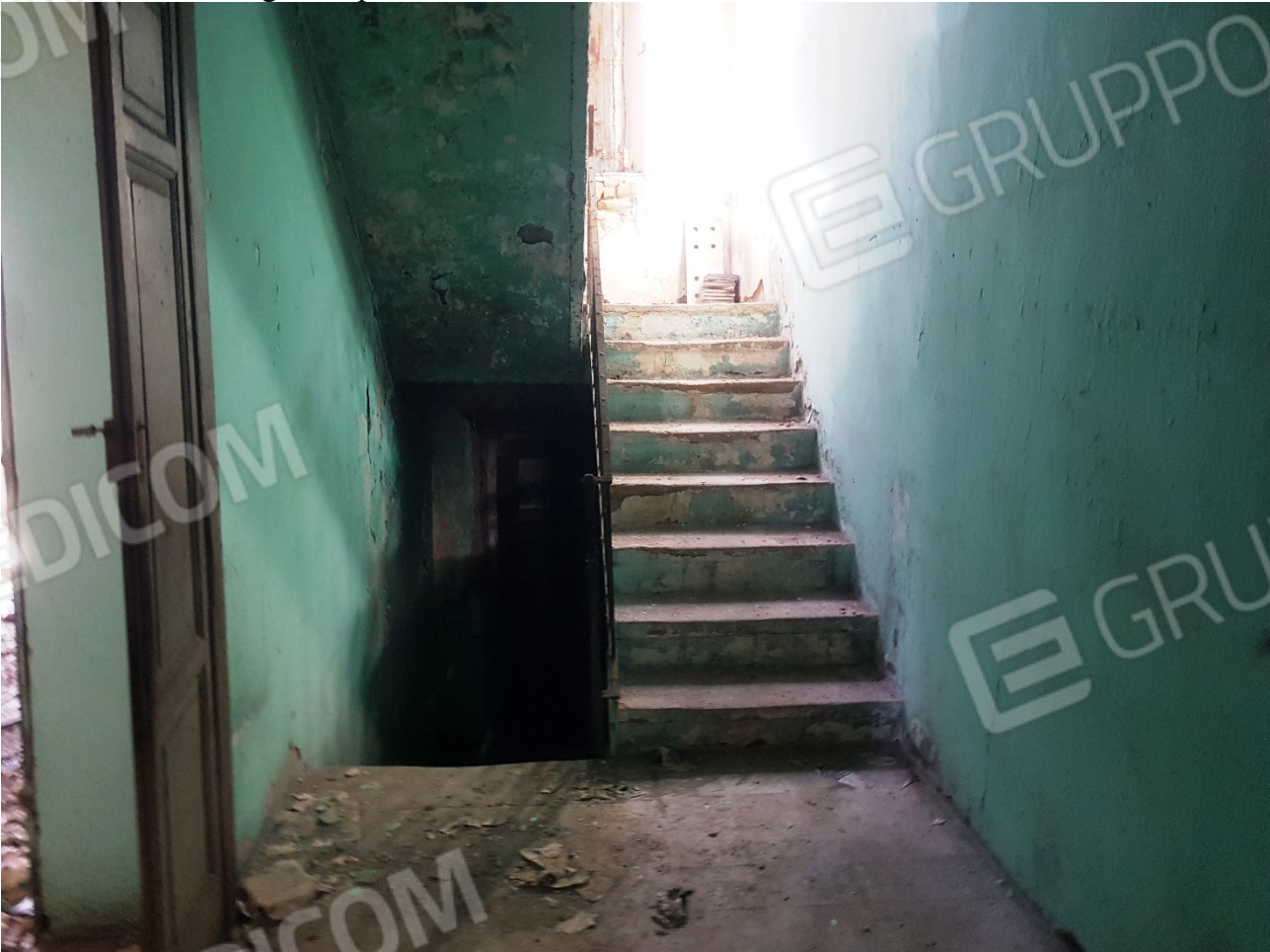
FOTO 59 interno Foglio 40 p.lla 49 Sub.5
