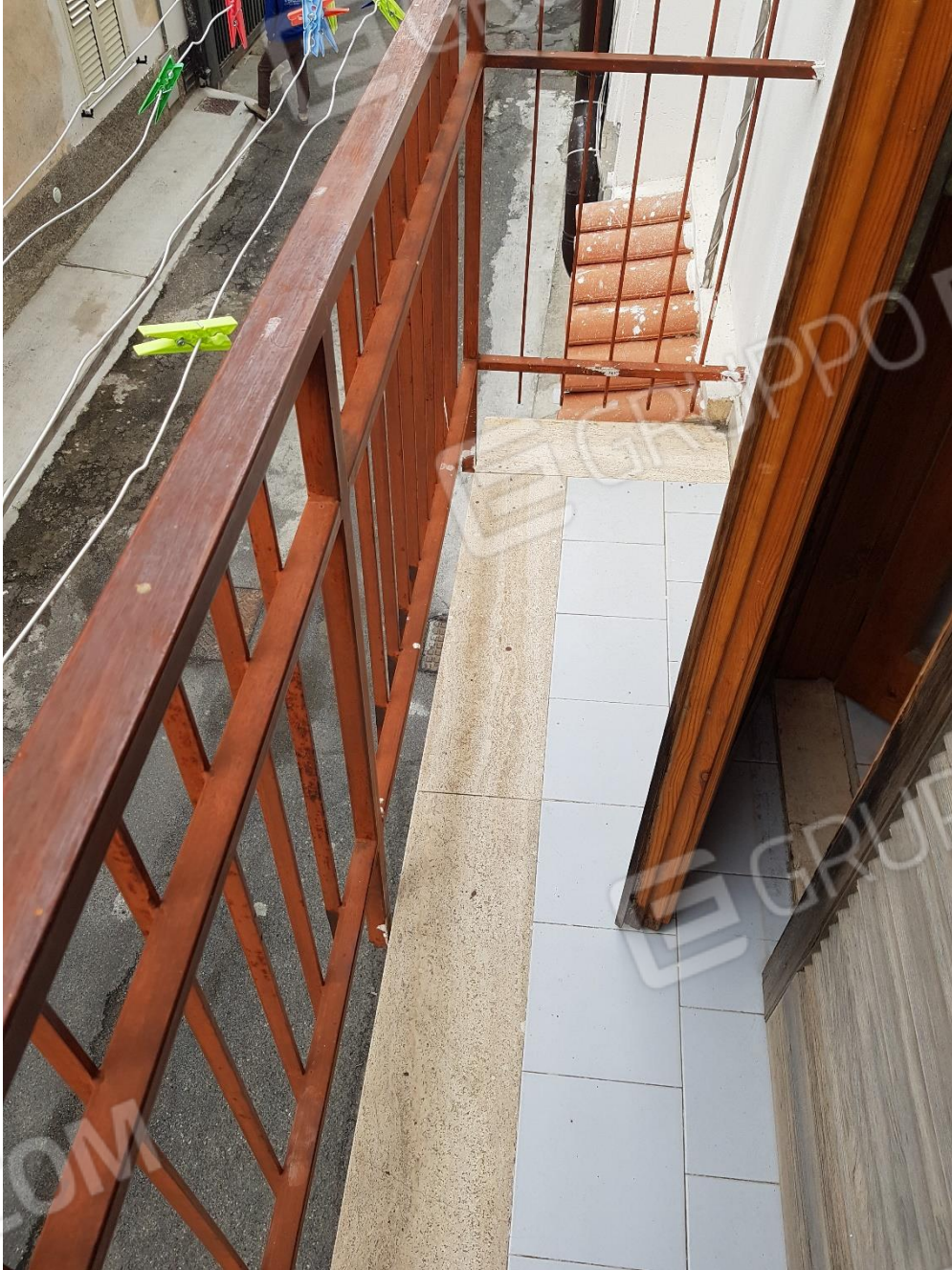
Foto n.11: particolare balcone su facciata ovest
