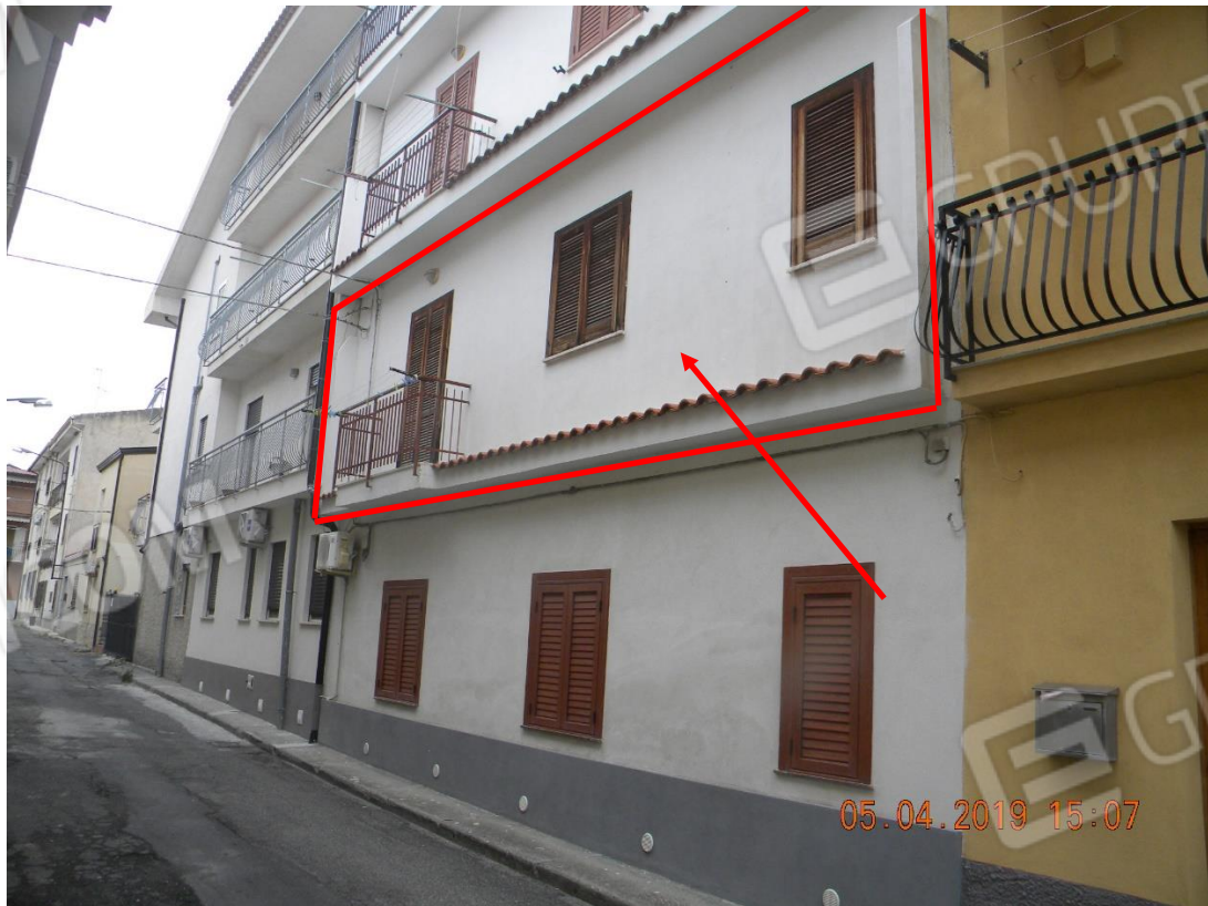
Foto n.2: vista ravvicinata facciata ovest con indicazione appartamento al 1° piano oggetto di esecuzione (via Sardegna)
