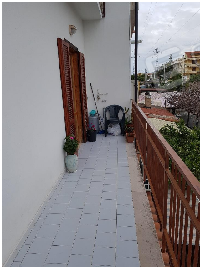
Foto n.8b: balcone facciata est, vista da sud
