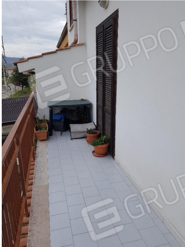
Foto n.8a: balcone facciata est, vista da nord
