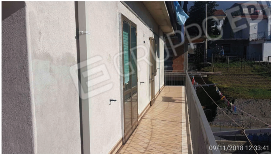
Terrazzo lato Sud
