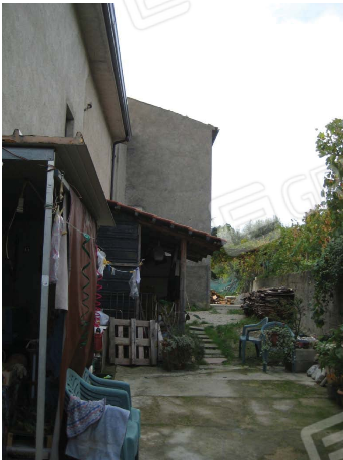
Foto 5 Ripostiglio e Capanno per Attrezzi
