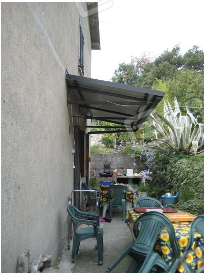
Foto 37 Porta sul Retro con Tettoia
