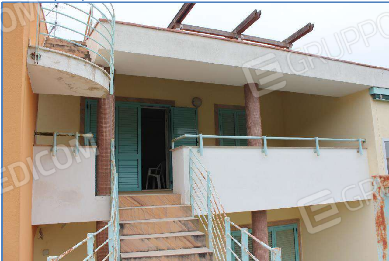
2.2- scaletta e portico pertinenziale d'accesso all'abitazione
