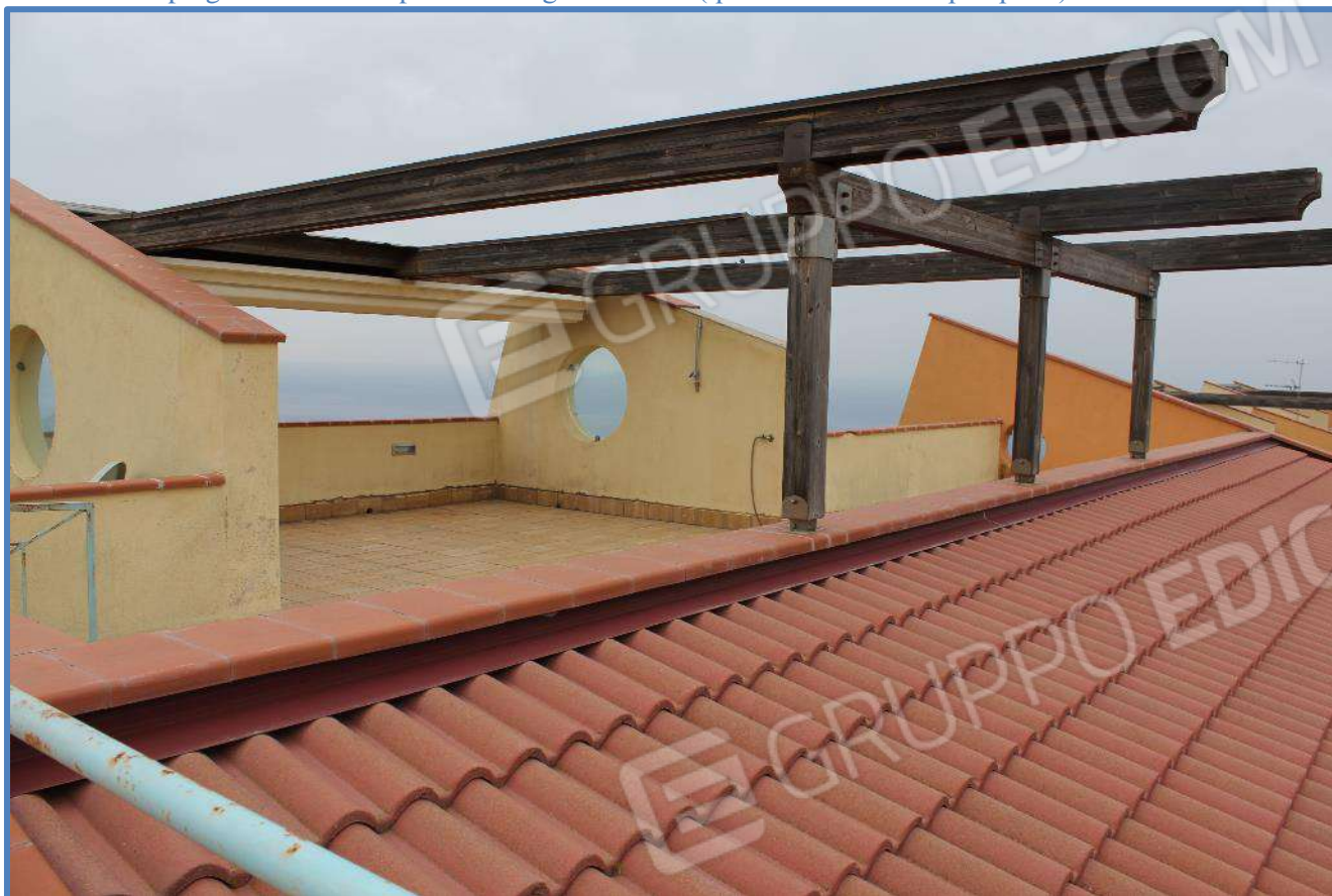
3.3- Vista sul pergolato e sulla copertura in tegole di cotto (quest'ultima oltre il parapetto)
