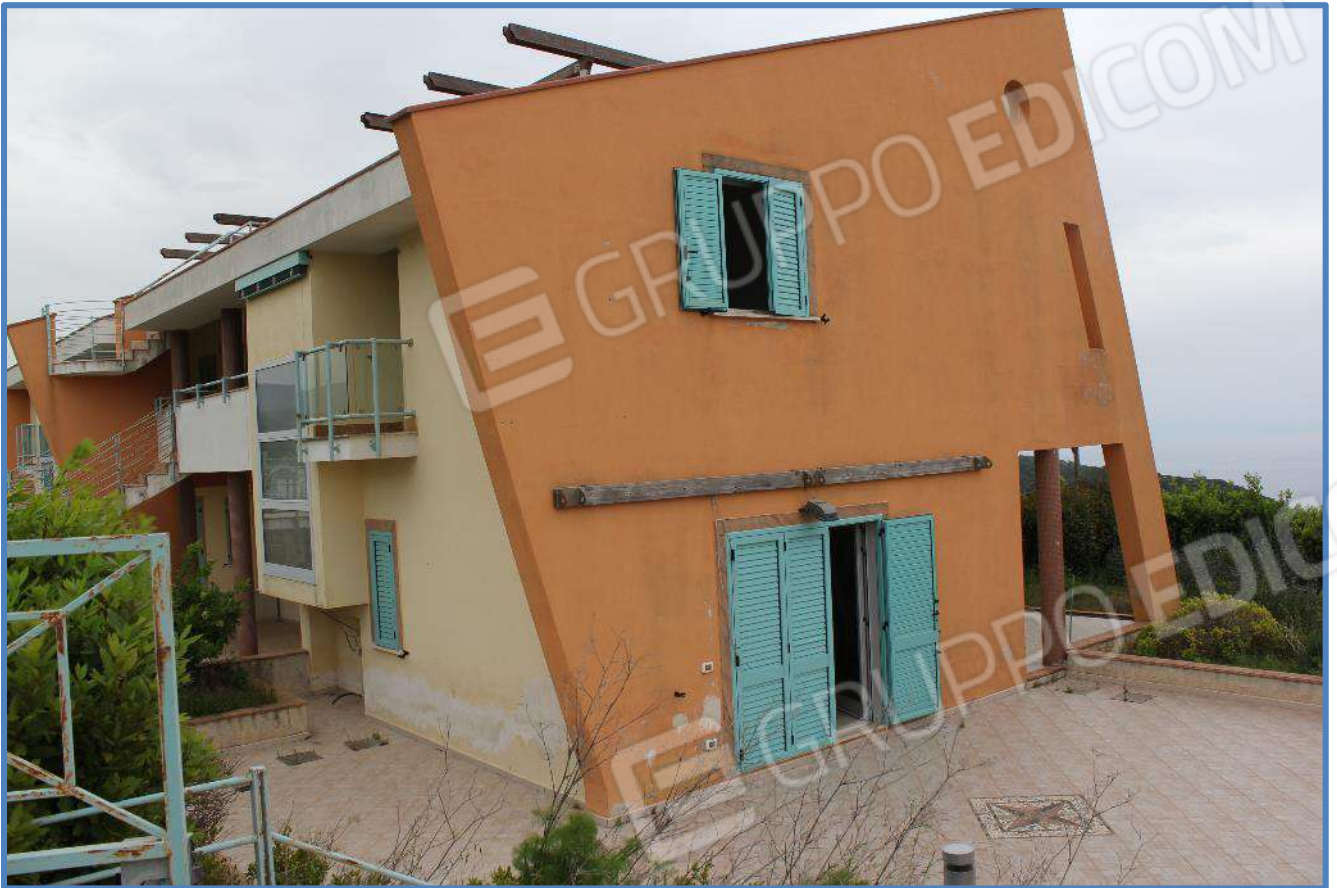
5.3- Facciata del locale “Duplex” – La zona giorno al piano terra, la zona notte al piano primo.
