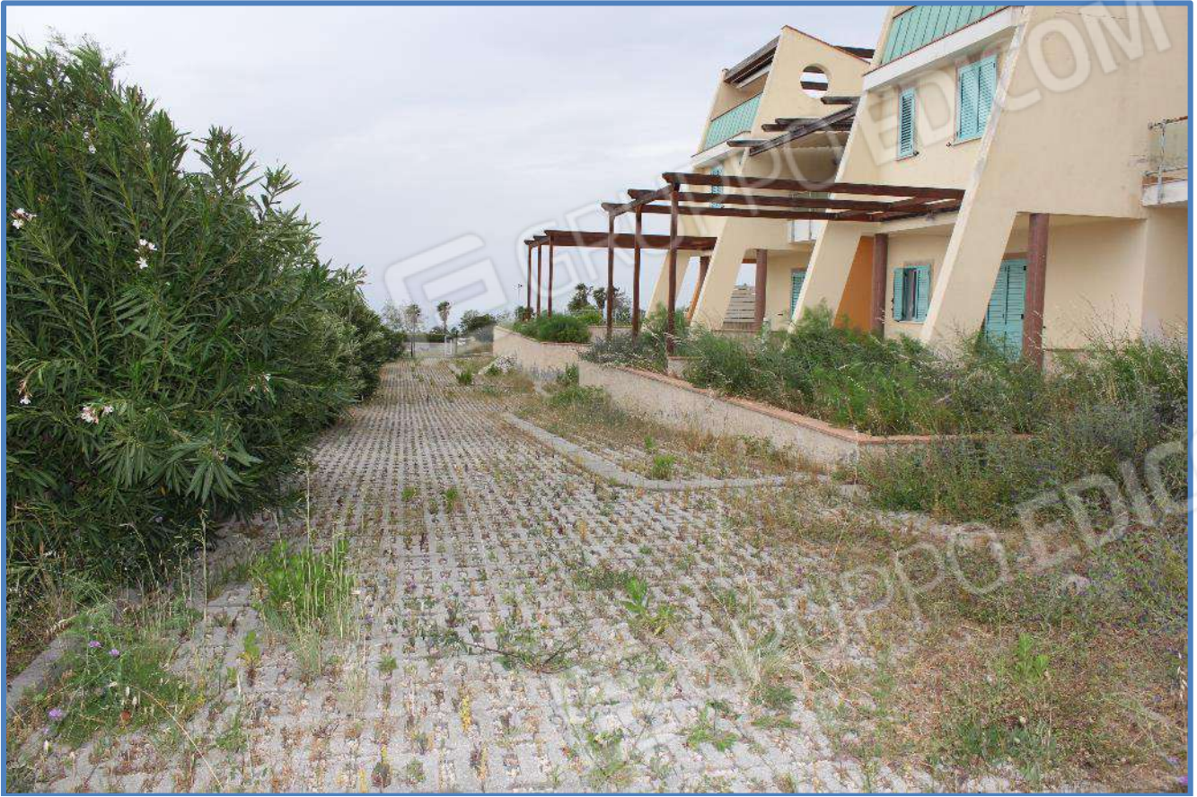
0.15- Corte di accesso ai fabbricati – lato S/O
