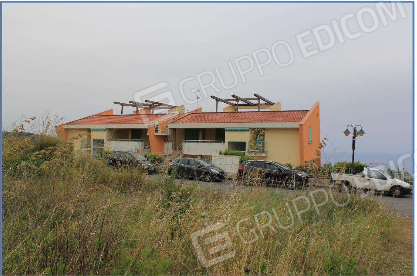
0.9- Fabbricato individuato con particella n. 733
