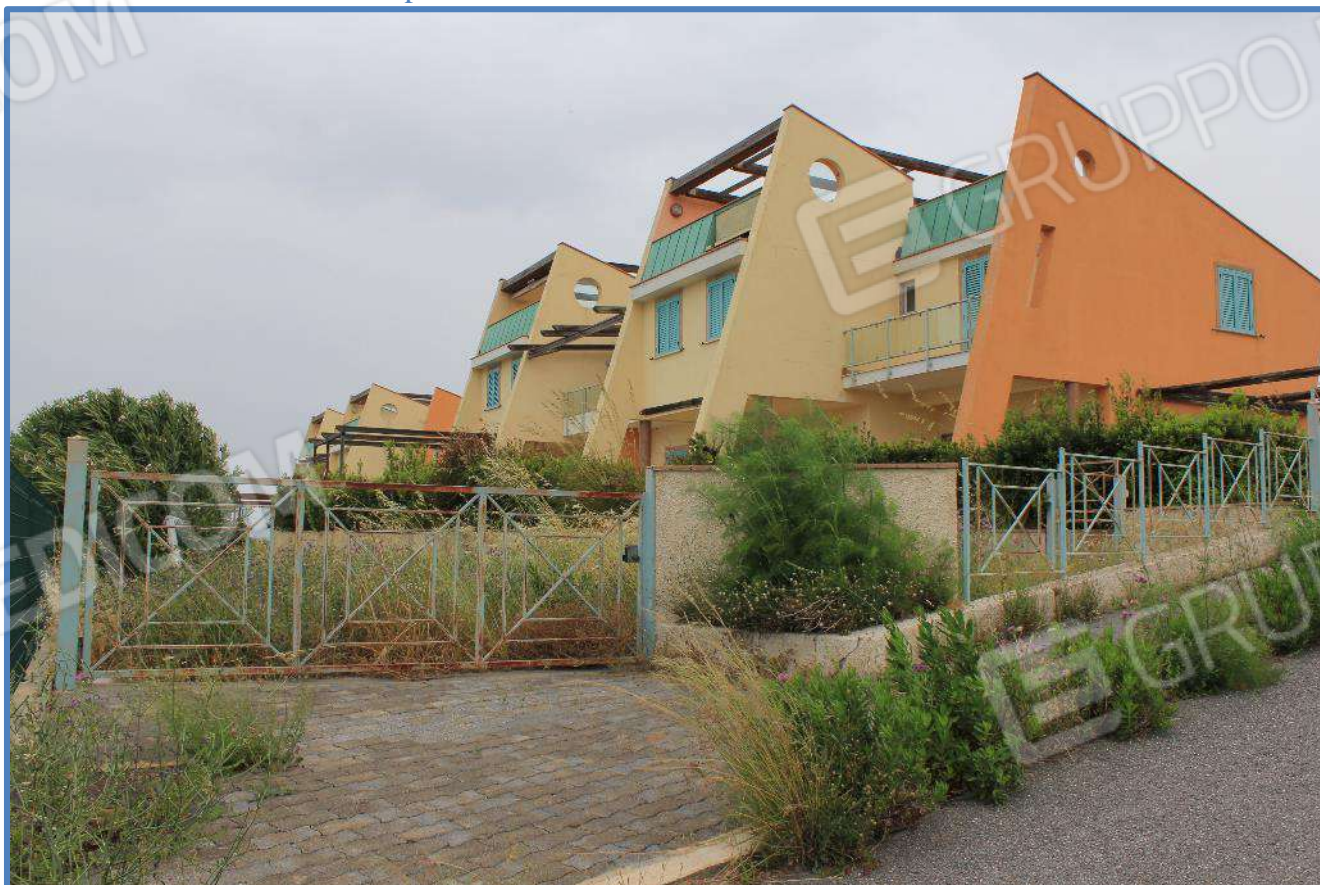
0.6- Fabbricato individuato con particella n. 734
