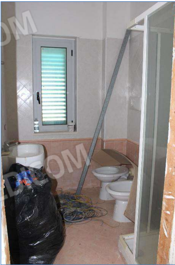
8.12, 8.13- Zona giorno – Locale WC
