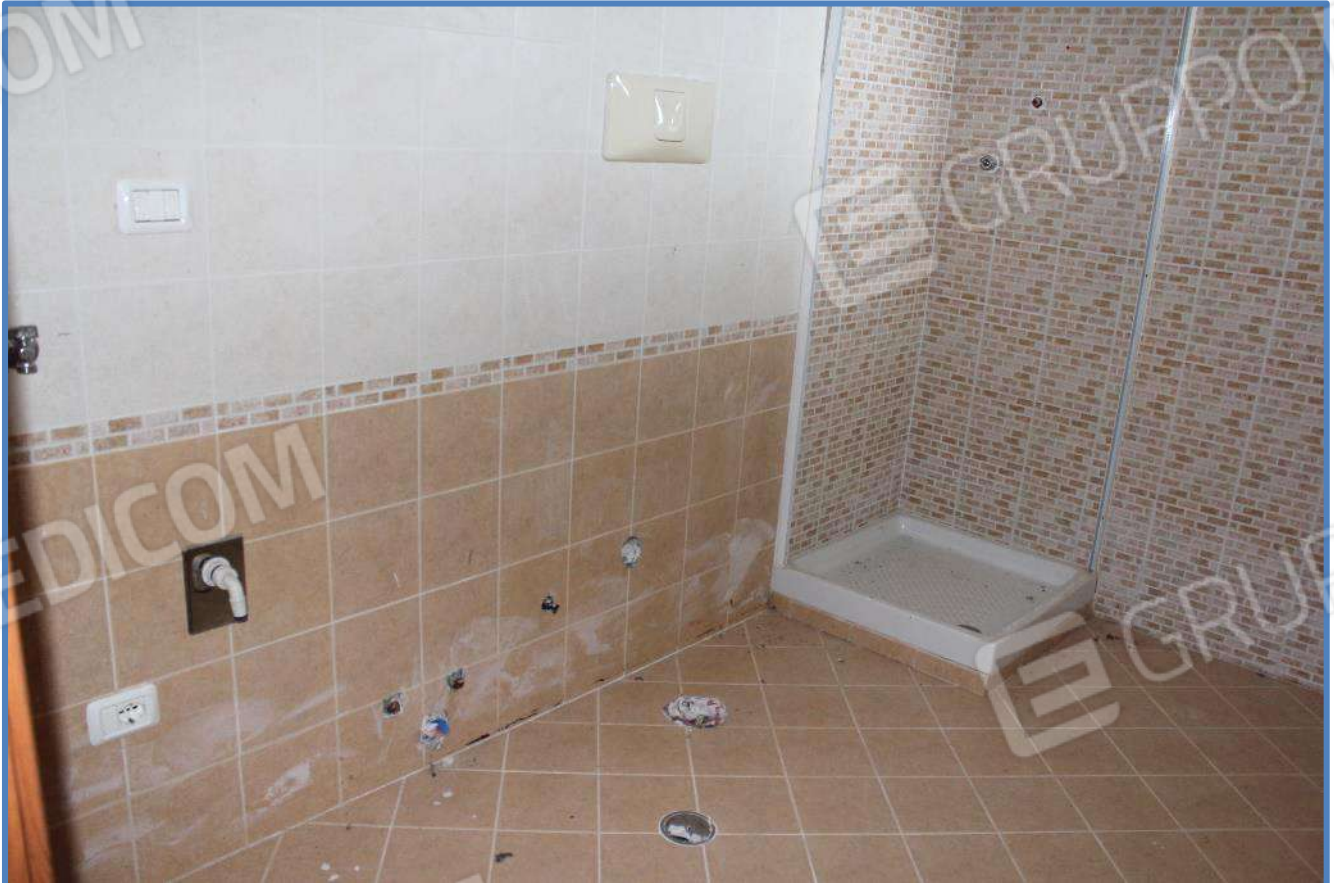
7.7- Zona giorno – Locale WC
