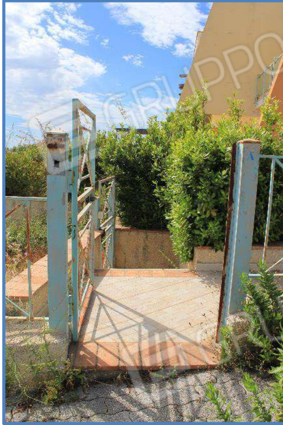
8.1- CANCELLETTO pedonale per l'accesso alla proprietà abitativa (lett. A)
