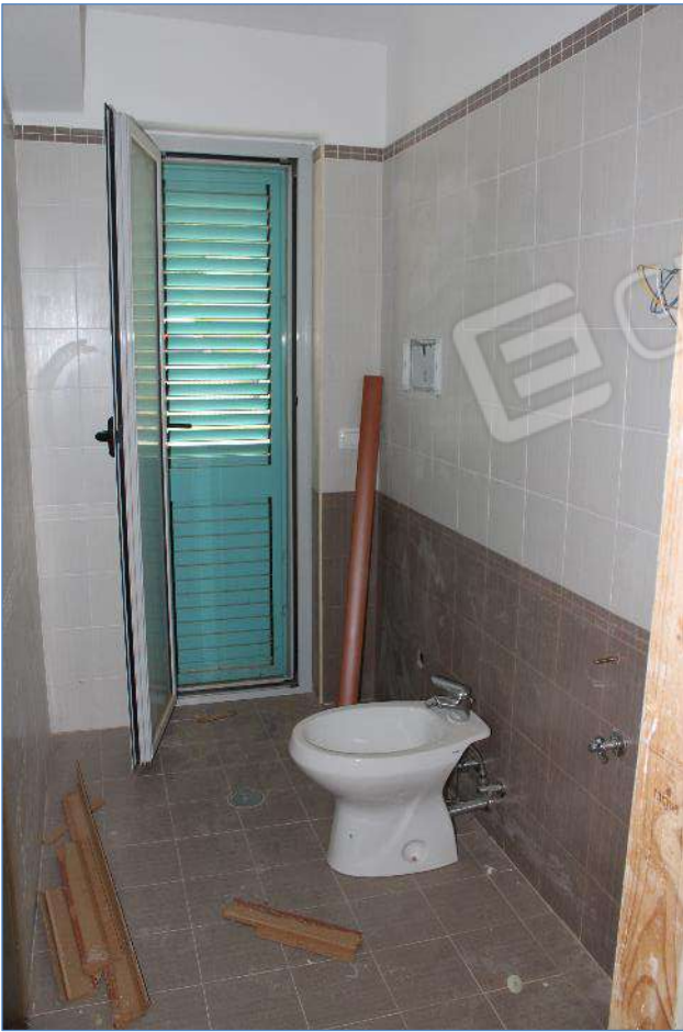
4.23, 4.24- Zona notte – Locale WC
