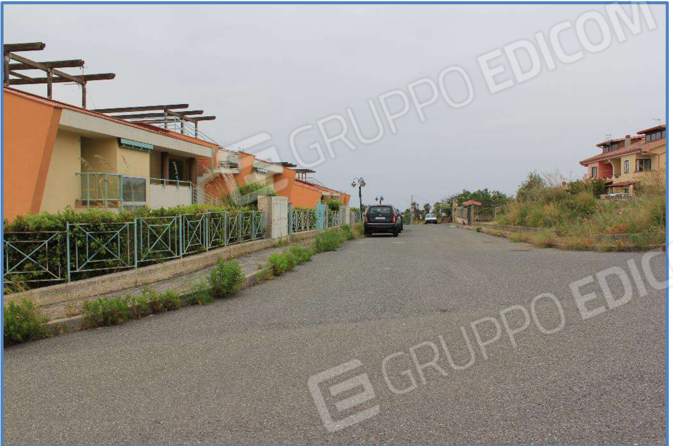
0.13- Strada di lottizzazione – lato N/E
