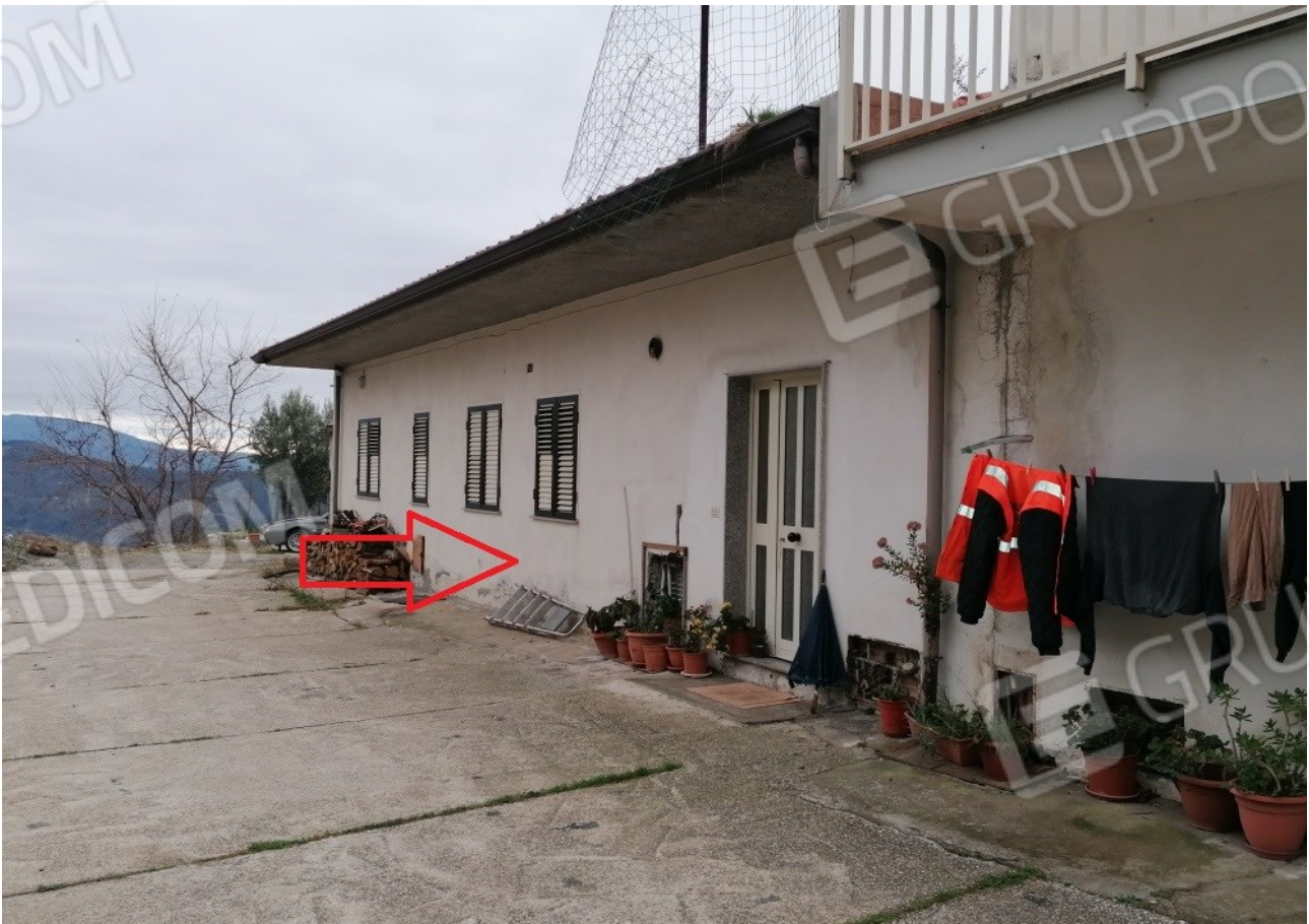
Foto n° 14 – Vista esterna con prospetto est degli immobili direzione sud –
