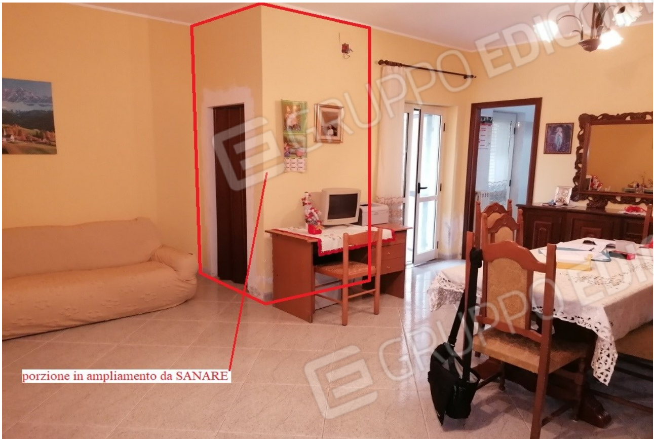
Foto n° 17 – Vista interna (vano soggiorno) –
