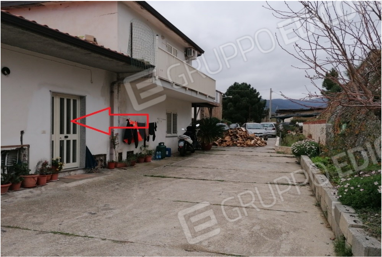
Foto n° 13 – Vista esterna con prospetto est sull'accesso dell'immobile sub 6 –
