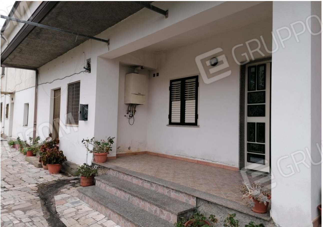
Foto n° 8 – Vista esterna con prospetto ovest degli immobili (accesso sub 5) –
