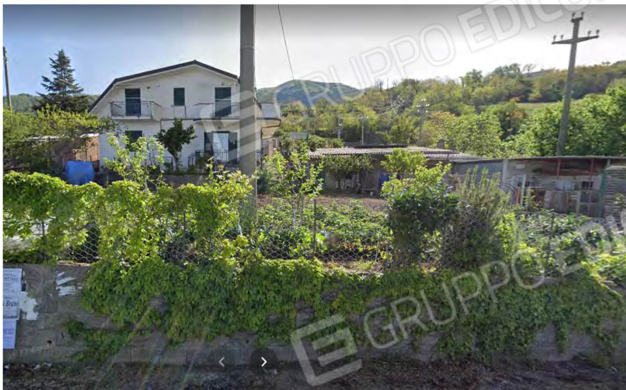
Vista dalla strada Provinciale da ovest
