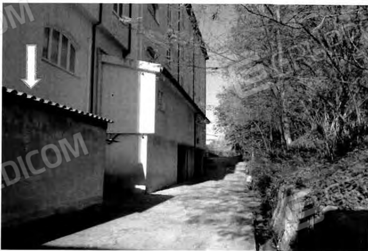
Foto 8 - Fronte esterno dell'albergo con il locale in ampliamento per servizi idrici
