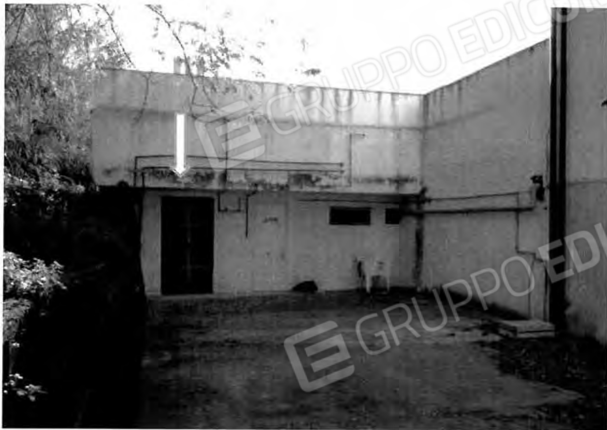
Foto 9 - Ingresso dei locali sottostanti la piscina
