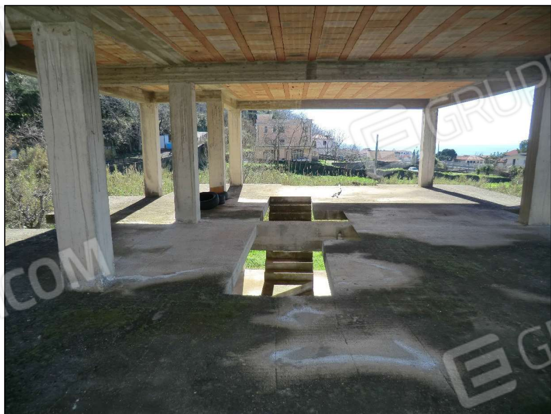
Foto 16_piano primo vista verso sud
