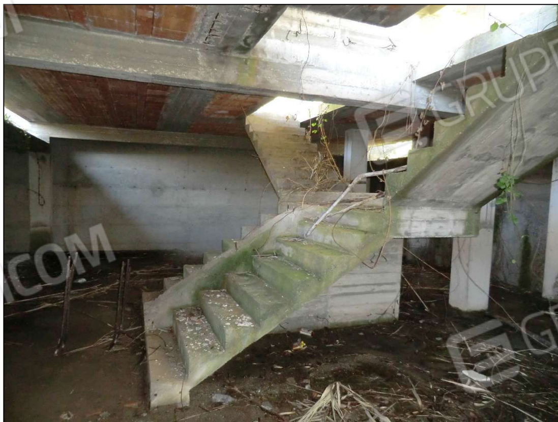
Foto 10_piano interrato lato nord
