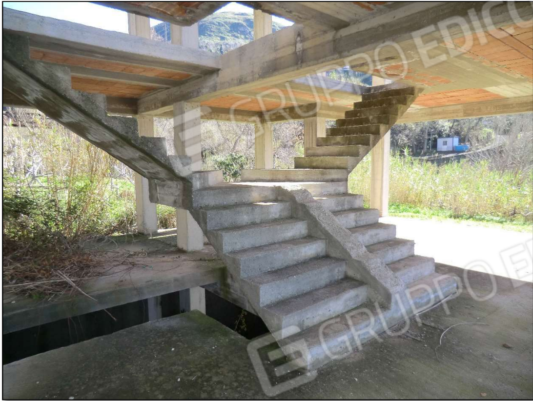
Foto 13_piano terra vista verso sud
