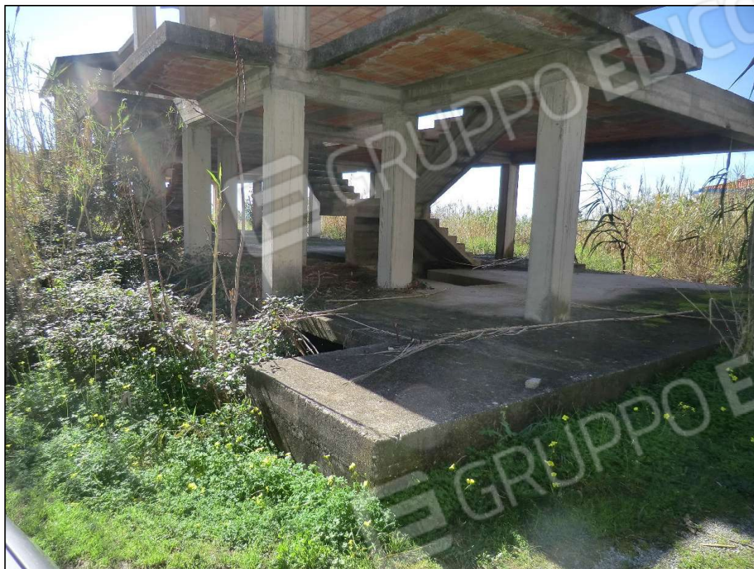
Foto 15_piano terra vista nord est
