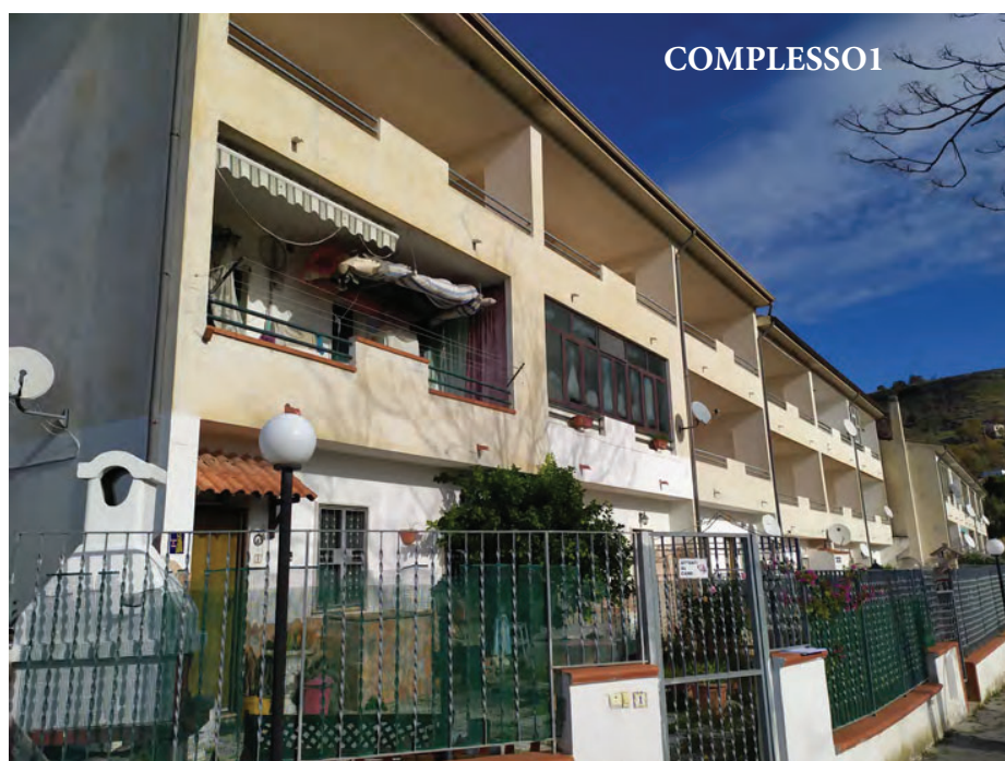
FOTO 3 - COMPLESSO 1 AL QUALE APPARTIENE L'IMMOBILE OGGETTO DI STIMA
