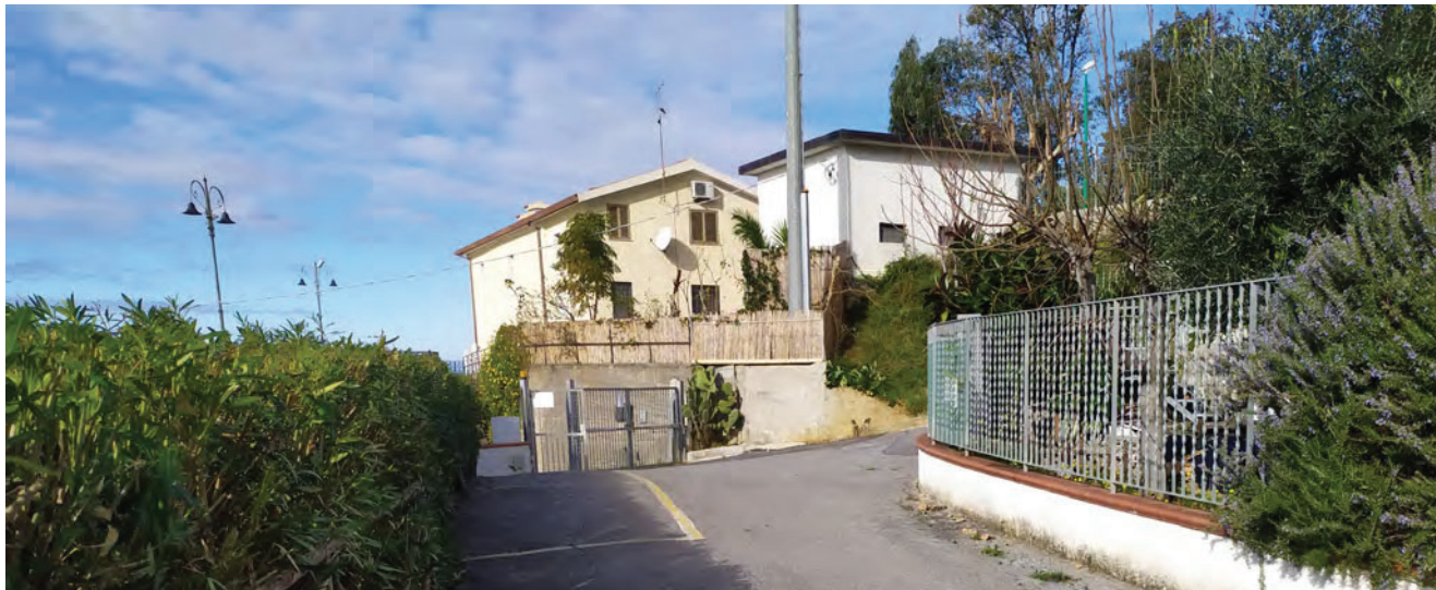
FOTO 1 - INGRESSO SECONDARIO A NORD DEL CONDOMINIO
