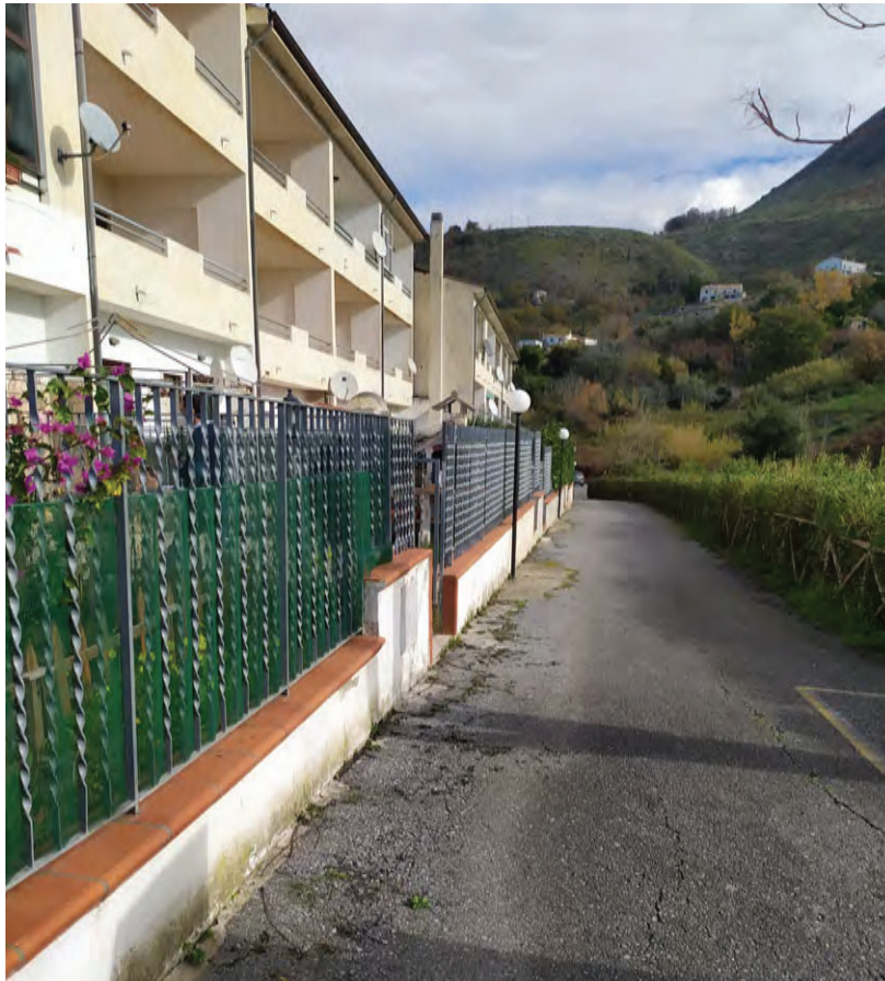
FOTO 4 - STRADA CARRABILE CHE CIRCONDA IL CONDOMINIO
