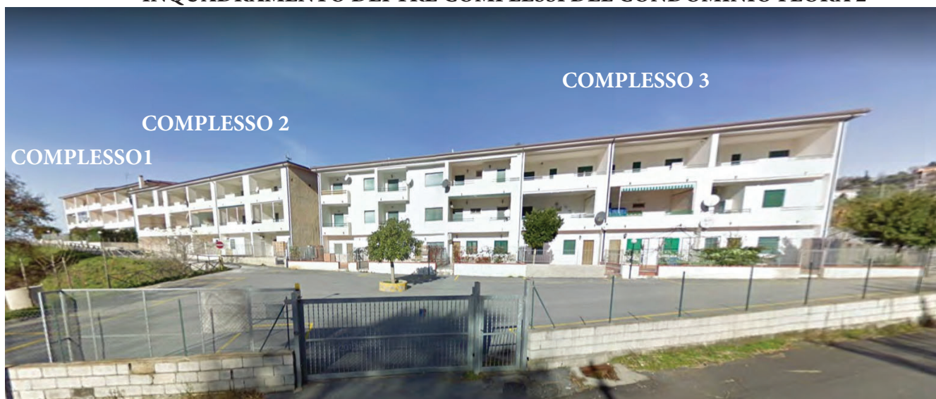
FOTO 2 - INGRESSO PRINCIPALE A SUD/OVEST DEL CONDOMINIO CON INQUADRAMENTO DEI TRE COMPLESSI DEL CONDOMINIO FLORA 2
